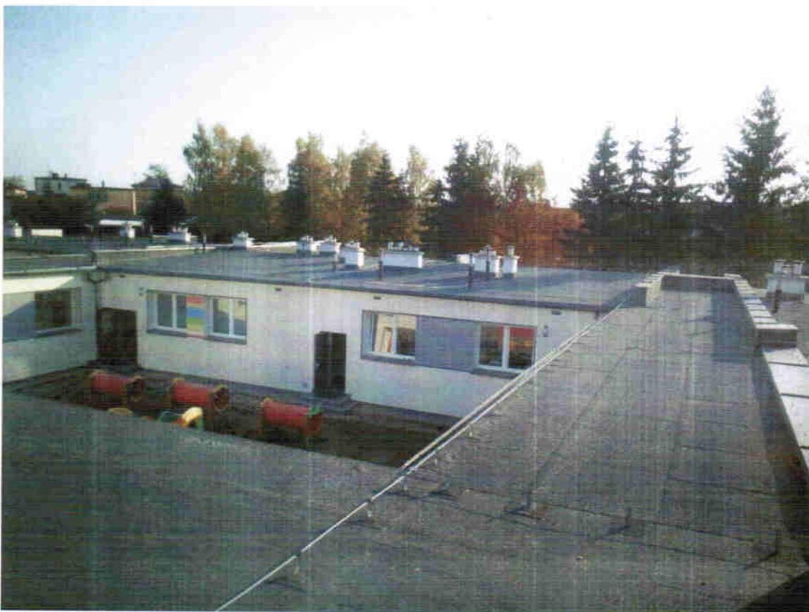
Zdjęcie nr 1 Dach płaski Przedszkola nr 1 w Tucholi
