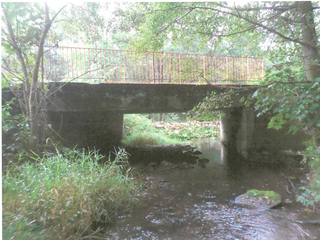
Fot. 2. Widok obiektu od strony górnej wody.
