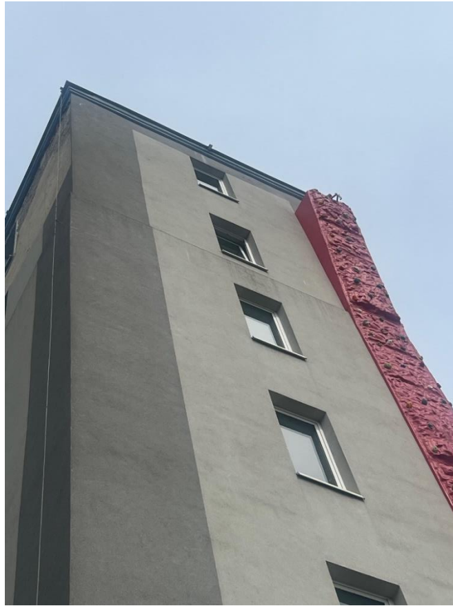
Fot. 2 Stan elewacji
