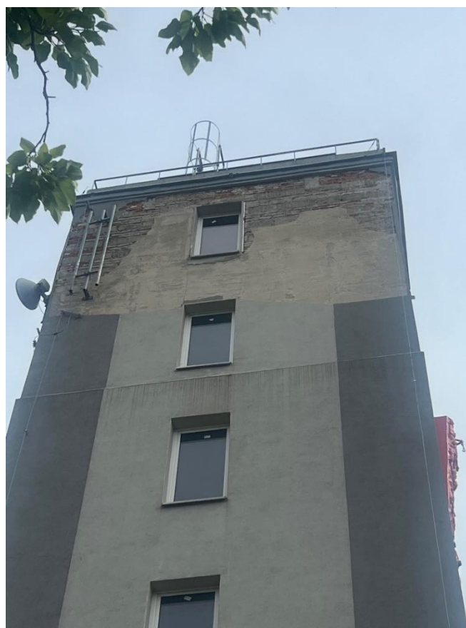
Fot. 1 Stan elewacji
