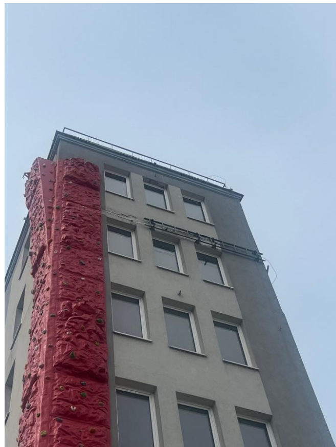
Fot. 3 Stan elewacji
