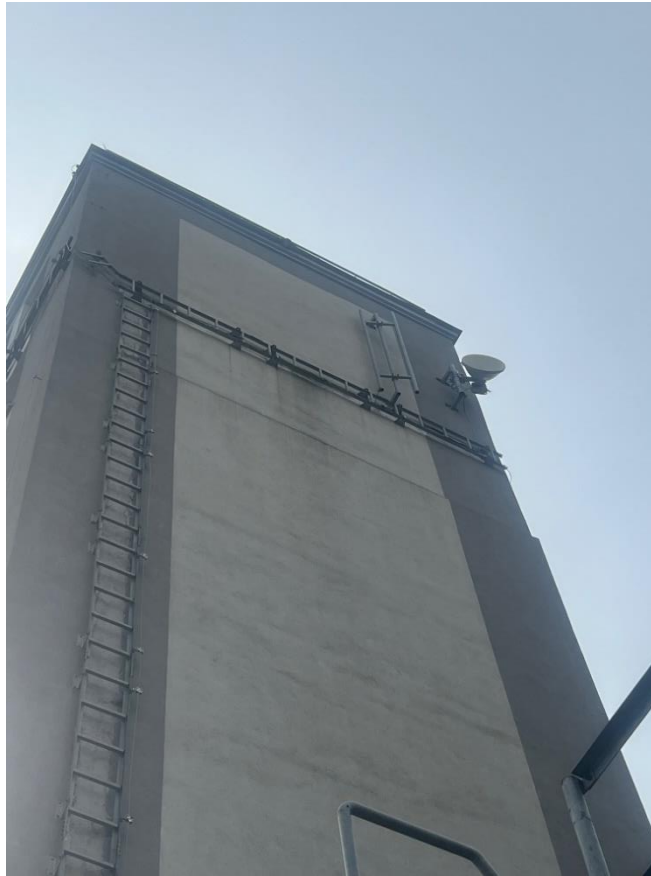
Fot. 4 Stan elewacji
