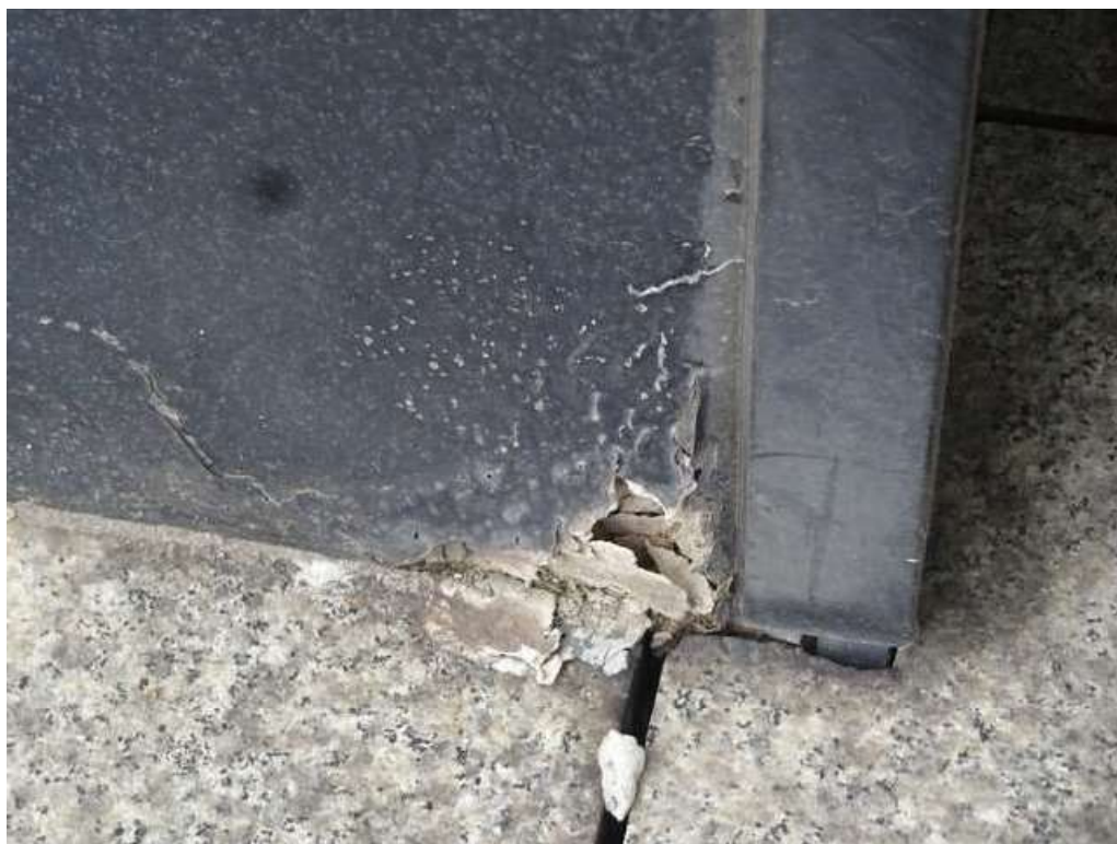
Fot. 9: Zniszczona płyta "ETERTILE"
