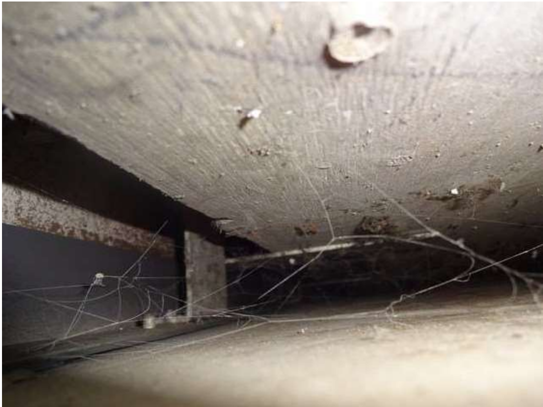
Fot. 13: Podkonstrukcja płyt - kątownik kompozytowy i płaskowniki zakotwione w żelbecie
