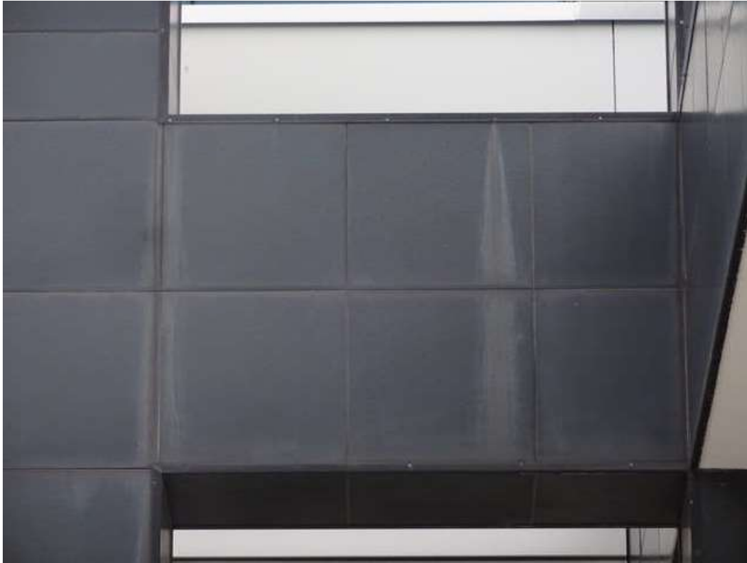
Fot. 5: Obróbki krawędzi z kątowników mocowane wkrętami
