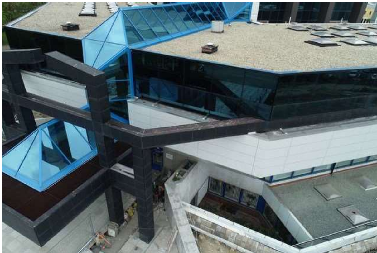
Fot. 4: Portyk i fragment pasa elewacyjnego obłożone płytami "ETERTILE"
