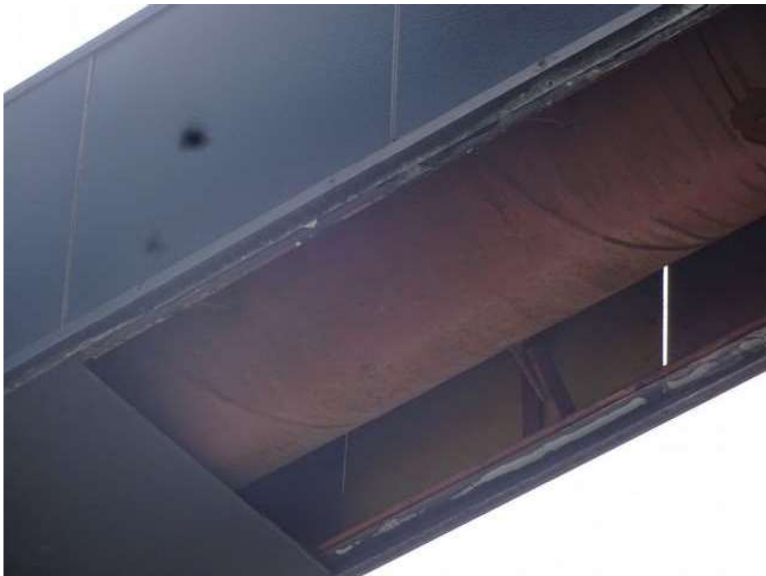
Fot. 14: Podkonstrukcja płyt - kątowniki kompozytowe, kątowniki stalowe, przewiązki i płaskowniki
