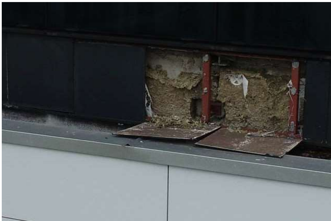
Fot. 12: Odspojone płyty na południowo-zachodnim pasie elewacyjnym
