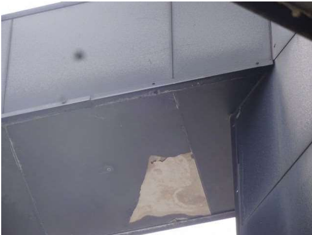
Fot. 8: Łuszczenie się oraz ubytki w płytach "ETERTILE"
