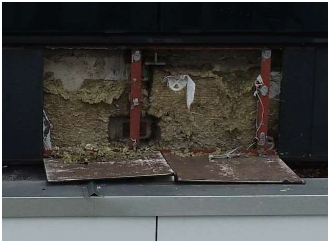
Fot. 15: Podkonstrukcja płyt pasa elewacyjnego ze stalowych kątowników
