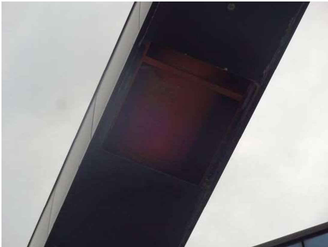
Fot. 11: Belka skośna od strony południowo-zachodniej z widocznym brakiem płyty
