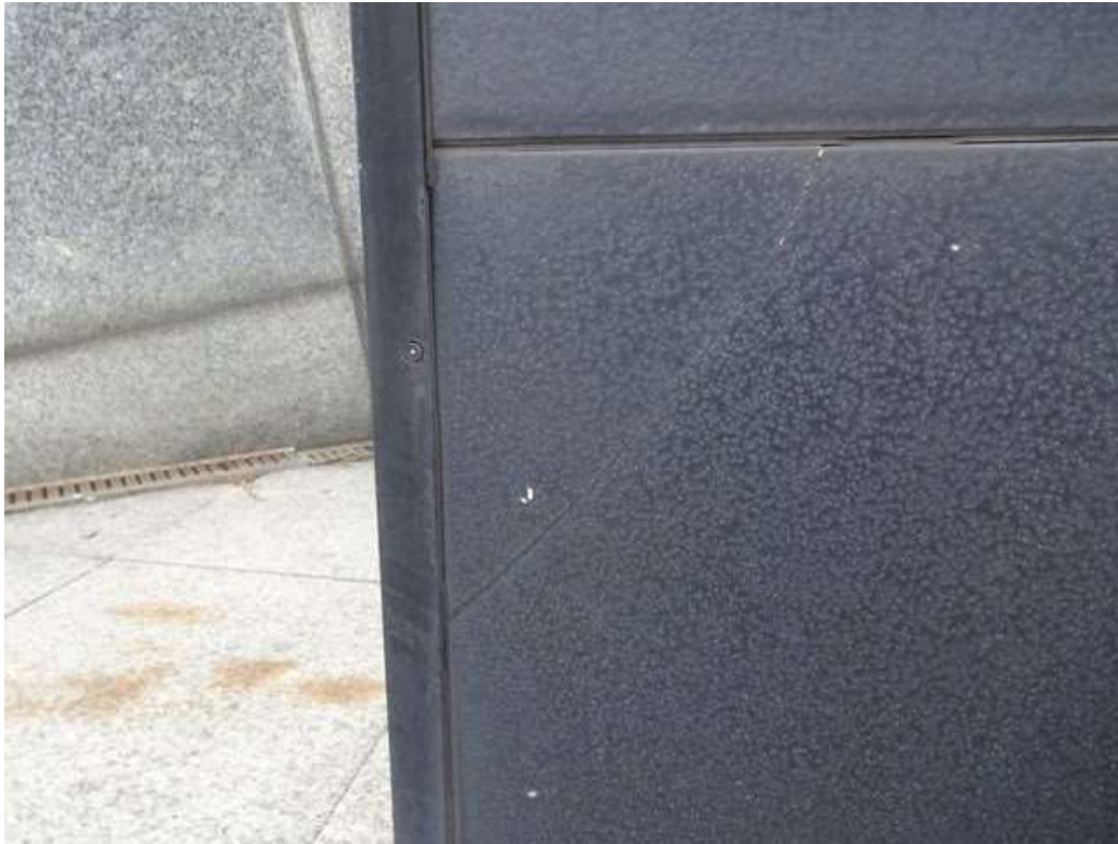
Fot. 6: Pęknięcia płyty oraz ubytki i pęknięcia spoin
