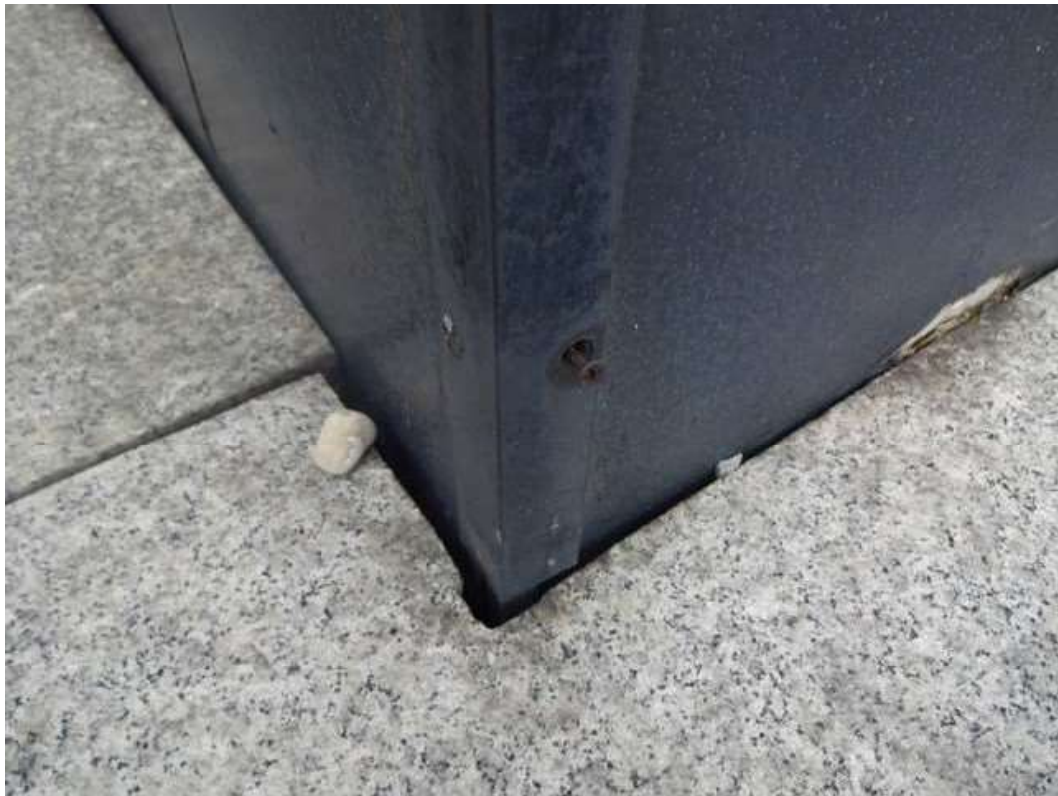
Fot. 7: Skorodowane i niedokręcone łączniki
