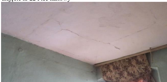
Zdjęcie nr 24 Widok spękanego tynku sufitu i ścian
