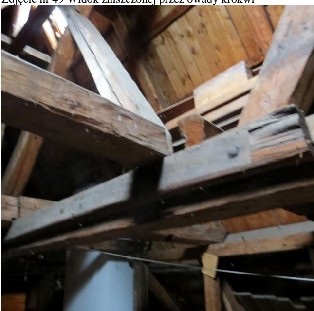
Zdjęcie nr 51 Brak połączeń elementów konstrukcyjnych dachu
