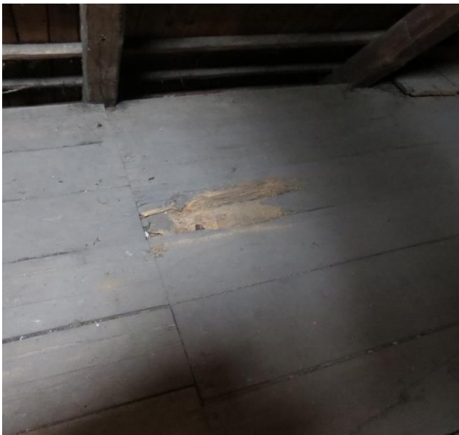
Zdjęcie nr 37 Widok zniszczonej podłogi na poddaszu
