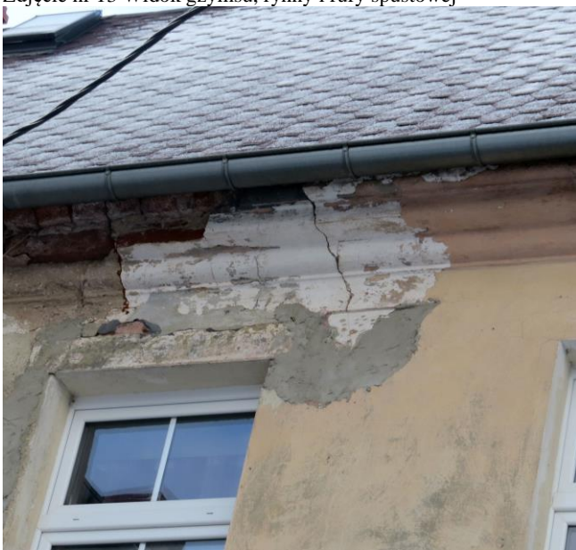
Zdjęcie nr 15 Widok spękanego gzymsu i nadproża
