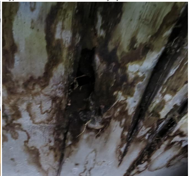
Zdjęcie nr 46 Widoczne zagrzybenie
