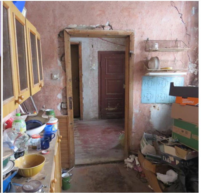
Zdjęcie nr 26 widok zniszczonych ścian i podłogi
