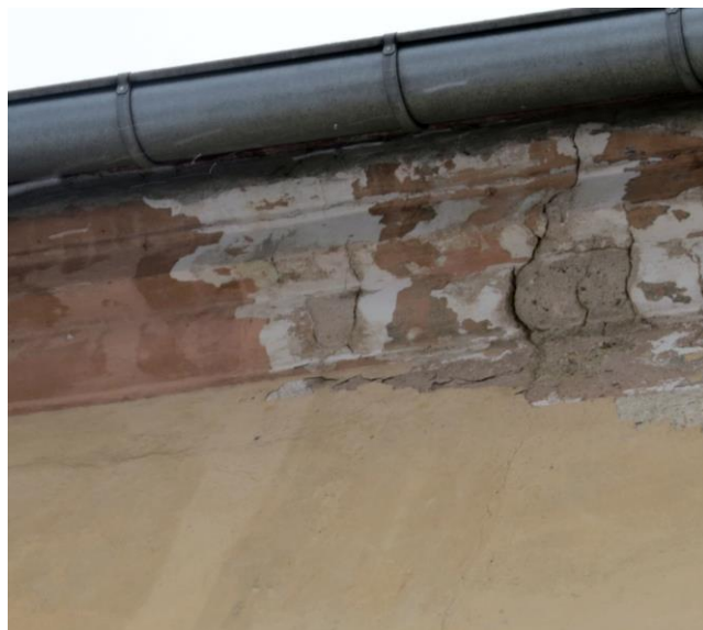
Zdjęcie nr 14 Widok spękanego gzymsu
