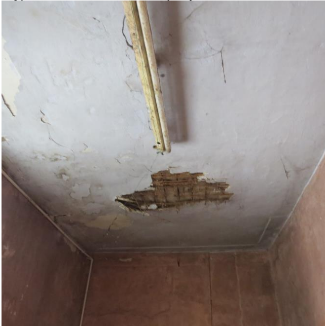
Zdjęcie nr 27 Widok spękanego tynku z trzciny na suficie
