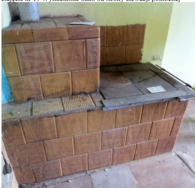
Zdjęcie nr 21 Kuchnia służąca do gotowania i ogrzewania
