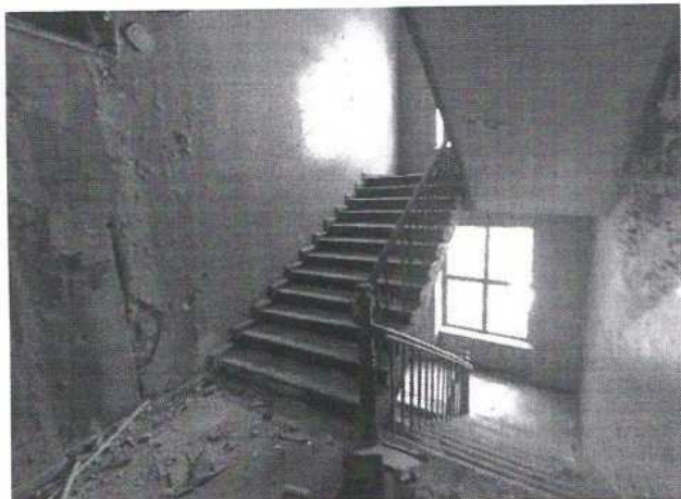
Fot. 10 - Klatka schodowa – III piętro
