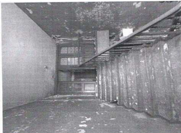
Fot. 11 - Klatka schodowa – poddasze
