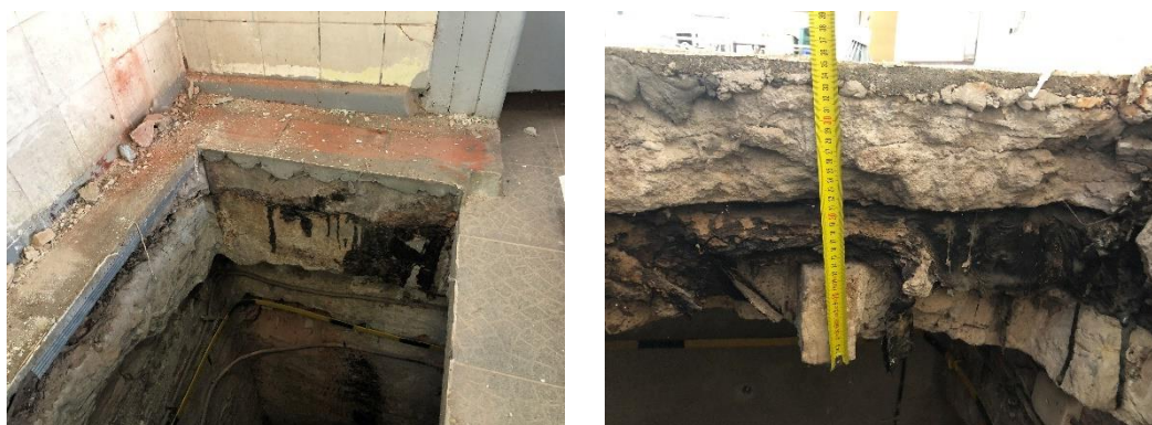
Fot. 1. Odkrywka O1
