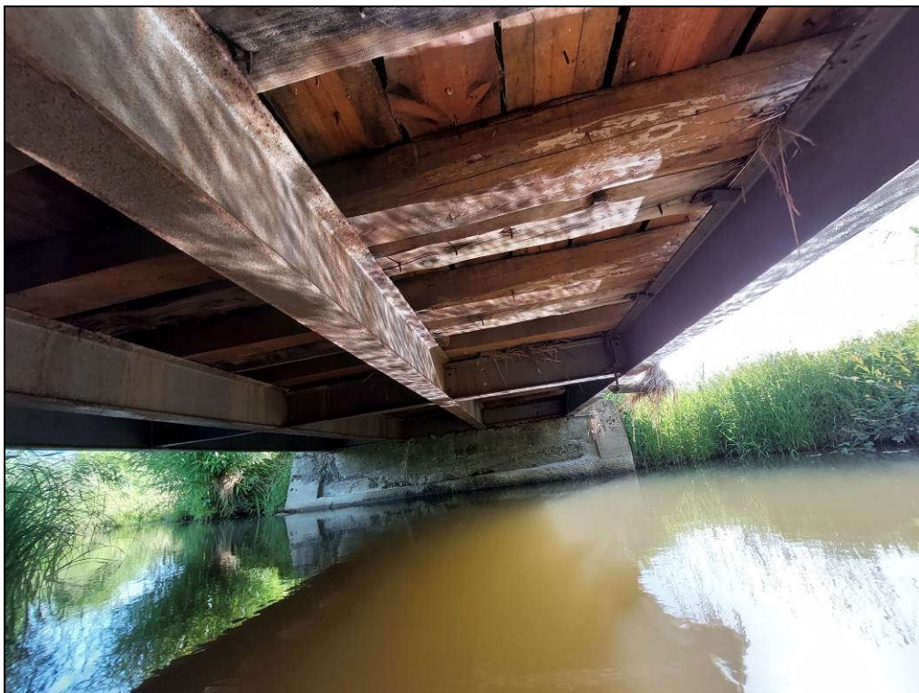
Fot. 4. Widok ogólny spodu ustroju nośnego.
