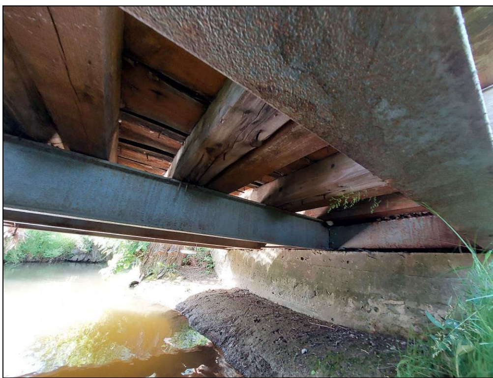
Fot. 7. Widok przyczółka lewobrzeżnego.
