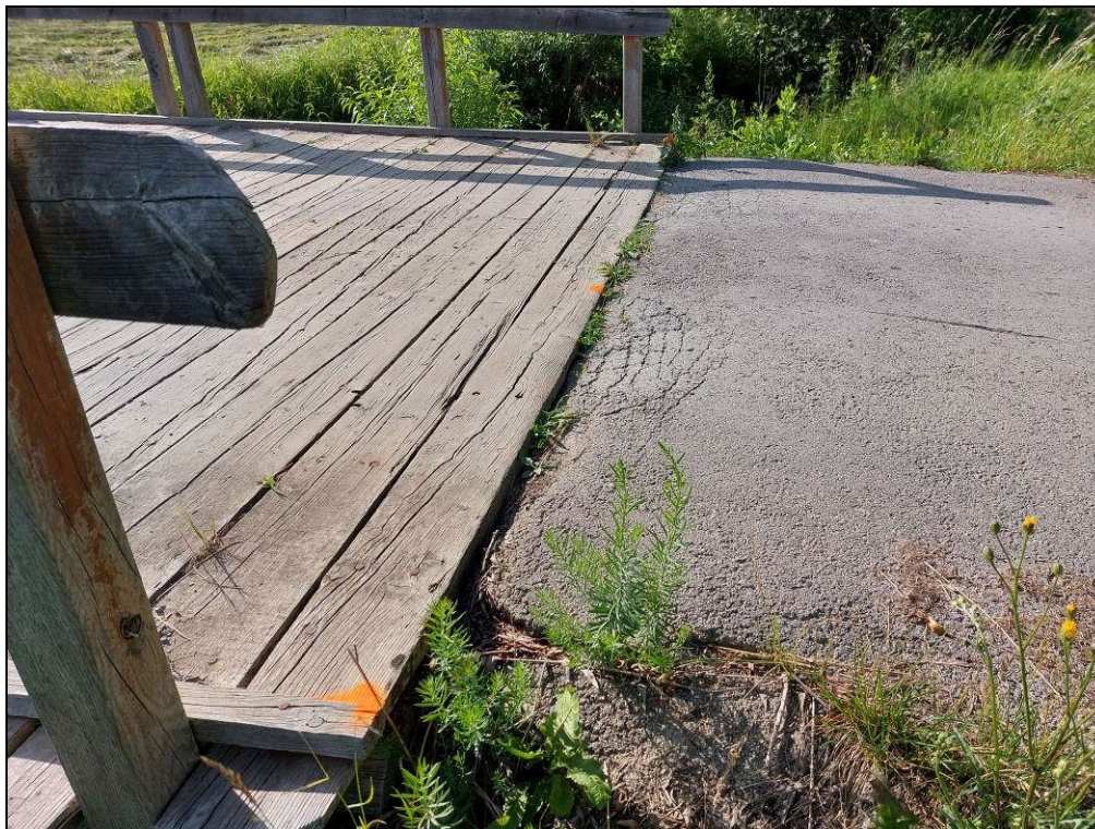
Fot. 17. Dojazd od strony m. Trochowiny. Zaniżenia nawierzchni względem pomostu oraz spękania siatkowe nawierzchni bitumicznej świadczą o osiadaniu jezdni w obrębie dojazdu do obiektu.
