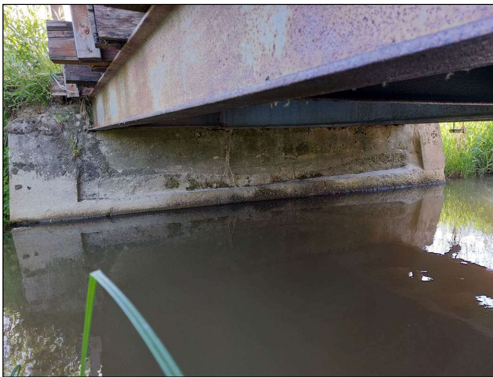
Fot. 6. Widok przyczółka prawobrzeżnego.
