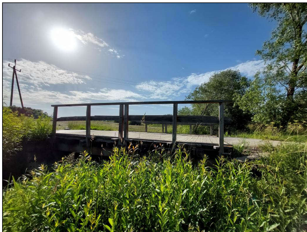
Fot. 2. Widok mostu od strony dolnej wody.
