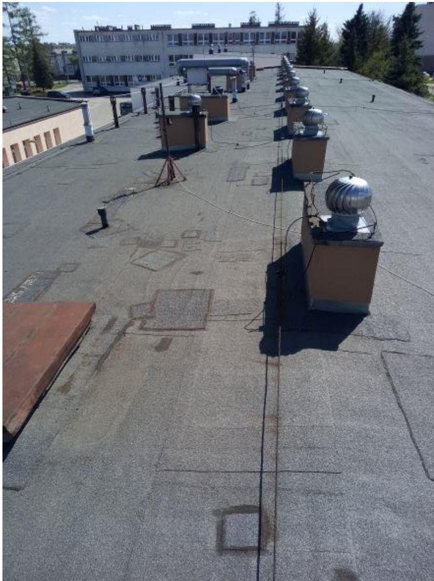
istniejące pokrycie dachowe
