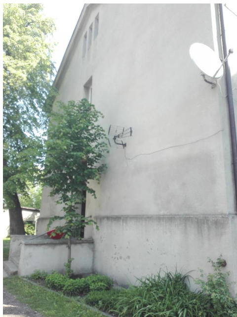
Fot.3 Elewacja zachodnia
