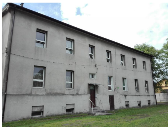
Fot.1 Elewacja północna
