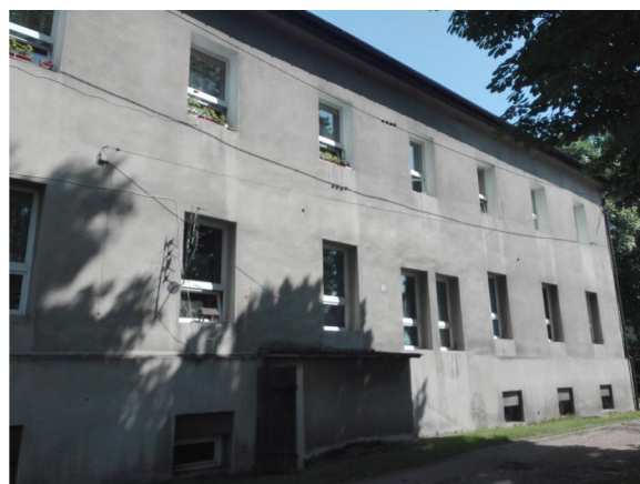
Fot.2 Elewacja południowa
