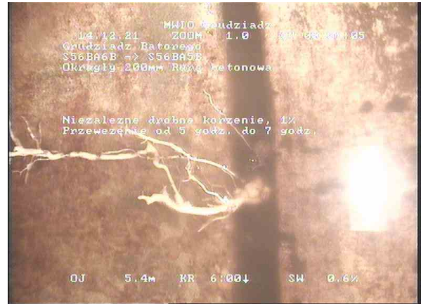
196bed2c-1f20-4343-875d-d8b53a655819_20211214_145858_779.jpg, 00:01:01, 5.44 Niezależne drobne korzenie, 1% Przewężenie od 5 godz. do 7
