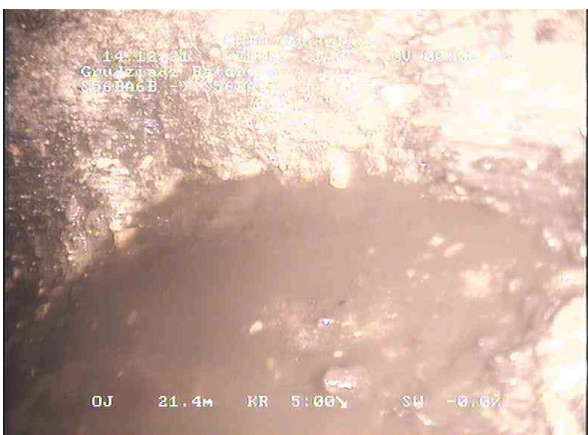
8510d9b4-2a46-4320-984f-eca31f81d7ca_20211214_135601_450.jpg, 00:05:00, 21.45 Przerwanie, brakujące fragmenty ściany, Długość: 100mm od
