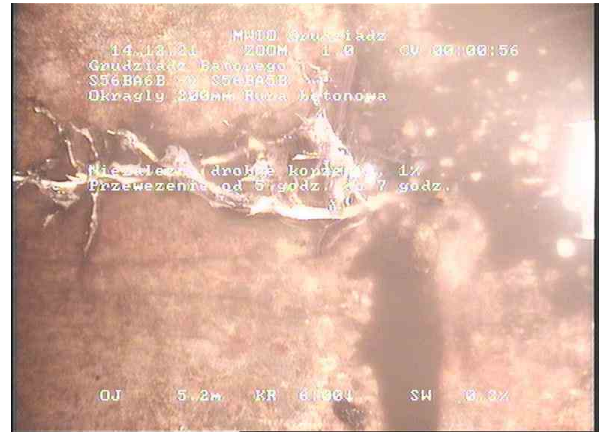
59397407-e2c6-42eb-84f4-063e2cdadeb2_20211214_135035_515.jpg, 00:00:52, 5.26 Niezależne drobne korzenie, 1% Przewężenie od 5 godz. do 7
