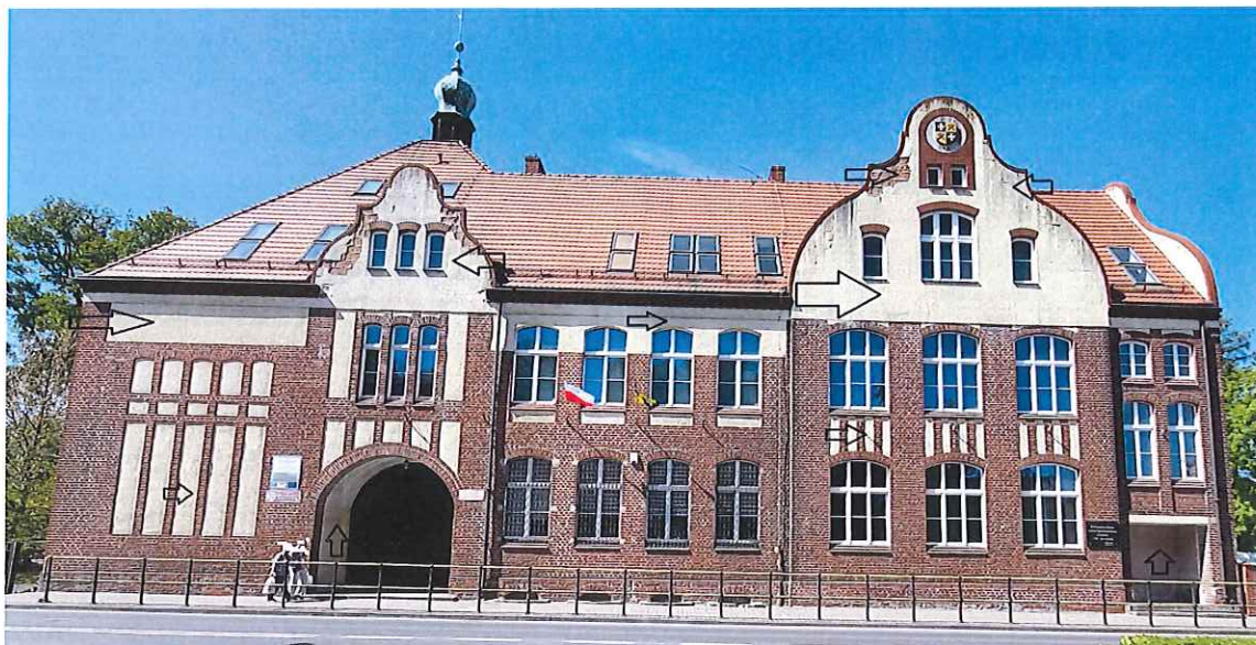
Fot. 51. Oznaczenia wypraw tynkarskich przeznaczonych do naprawy.
