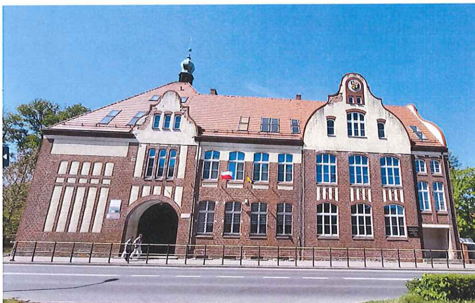
Fot. nr 3. Widok elewacji frontowej budynku dydaktycznego.
