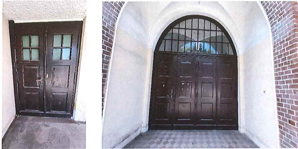
Fot. 52. Drzwi główne do renowacji wraz z okuciami, przeszkleniami i ościeżnicami.
