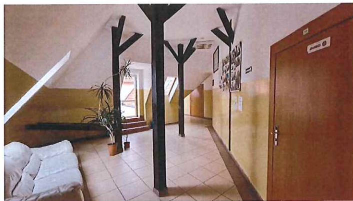
Fot. nr 14-19. Ciąg komunikacyjny w poziomie poddasza budynku dydaktycznego.
