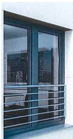
Fot. 55. Przykładowy wygląd okna transmisyjnego z balustradą.
