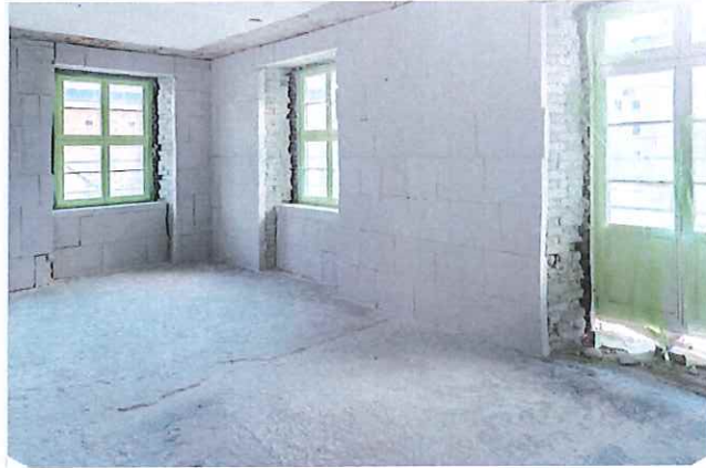
Fot. nr 58. Ocieplenie od wewnątrz płytami mineralnymi.
