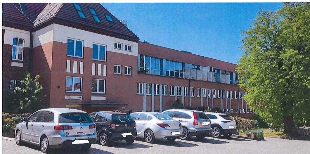
Fot. nr 28. Widok elewacji frontowej budynku hali sportowej.
