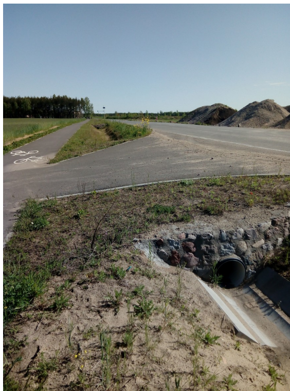
Widok na istniejący przepust przeznaczony do przebudowy (przepust P-5)
