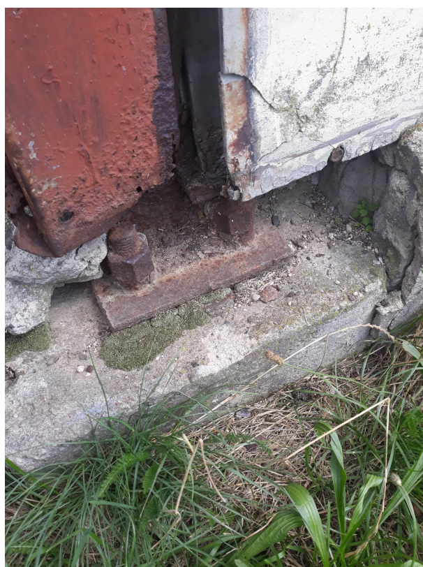
Fot. 5÷6 - Widok na konstrukcję nośną budynku z słupów stalowych oraz styk z podwalań
