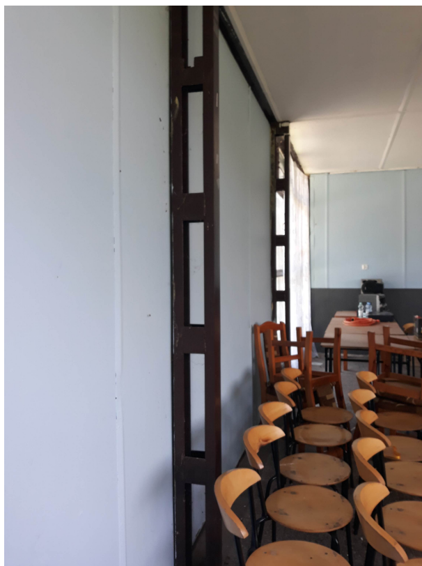
Fot. 5÷6 - Widok na konstrukcję nośną budynku z słupów stalowych oraz styk z podwalań
