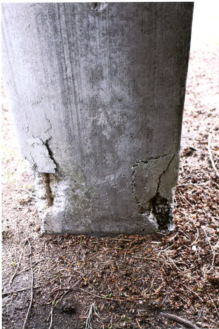
Fot nr 7 Radom. Pomnik ofiar terroryzmu niemieckiego z czasów II wojny światowej. Stan przed konserwacją lipiec 2022 roku. Widok głębokich uszkodzeń struktury pomnika. Metalowe pręty zbrojenia konstrukcji.
