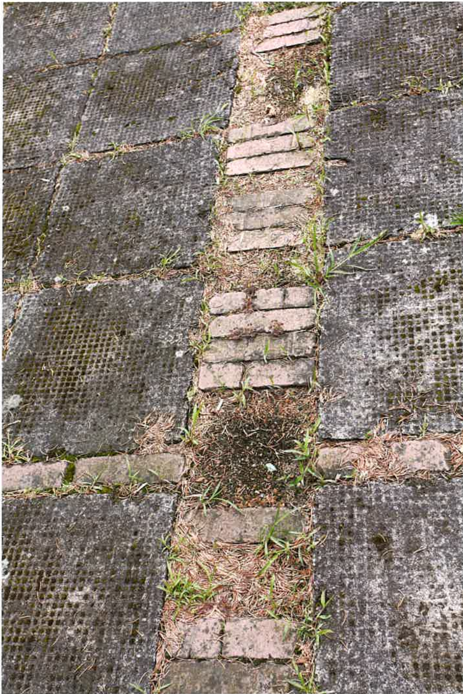
Fot nr 15 Radom. Pomnik ofiar terroryzmu niemieckiego z czasów II wojny światowej. Stan przed konserwacją lipiec 2022 roku. Widok fragmentu placu przed pomnikiem- betonowe płyty oraz cegły klinkierowe. Zły stan zachowania.
