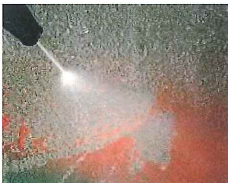
Czyszczenie powierzchni betonowej wodą pod wysokim ciśnieniem po użyciu WallGard Graffiti Barrier
