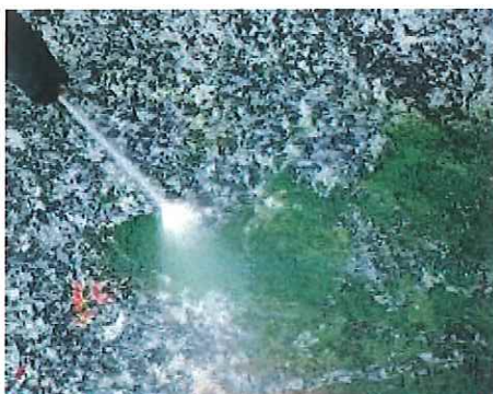
Czyszczenie powierzchni granitowej wodą pod wysokim ciśnieniem po użyciu WallGard Graffiti Barrier
