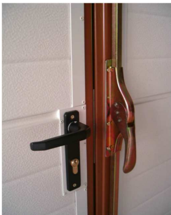
Rys. 2. Skrzydło czynne z klamką oraz skrzydło bierne – rygle blokowane dwupunktowo za pomocą specjalnej dźwigni.
