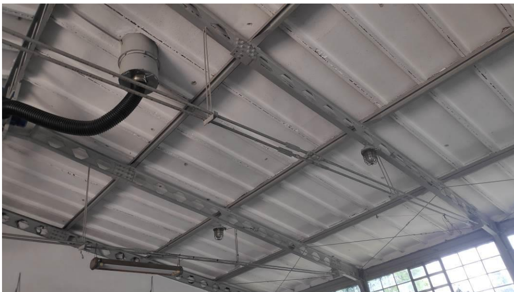
21. Widok korytkowych płyt dachowych, ażurowego dźwigara dachowego, stężeń połączeniowych i ściągów.
