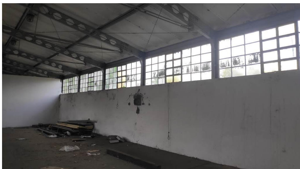
84. Stolarka okienna, konstrukcja stropodachu.
