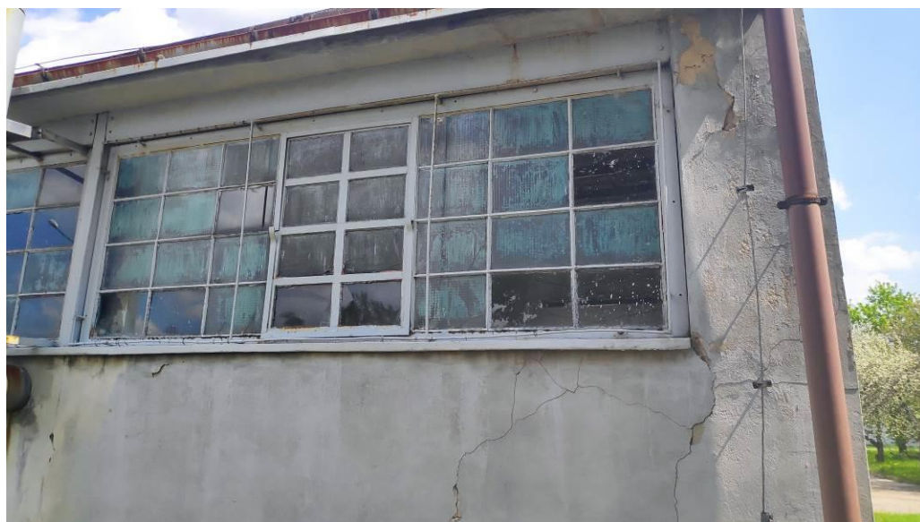
8. Zarysowania, odspojenia tynku na ścianie zewnątrznej. Widoczna stolarka okienna.
