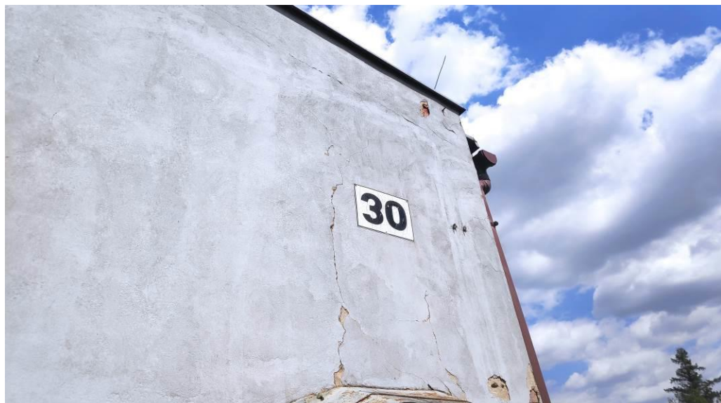
4. Zarysowania, odspojenia tynku na ścianie zewnątrznej.
