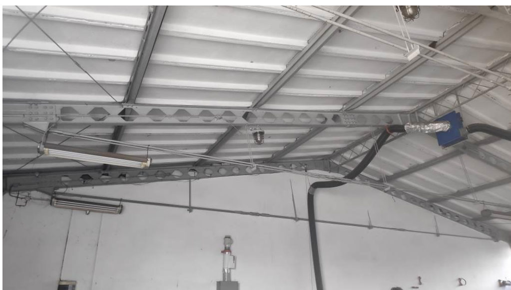
18. Widok korytkowych płyt dachowych, ażurowego dźwigara dachowego, stężeń połaciowych i ściągów.
