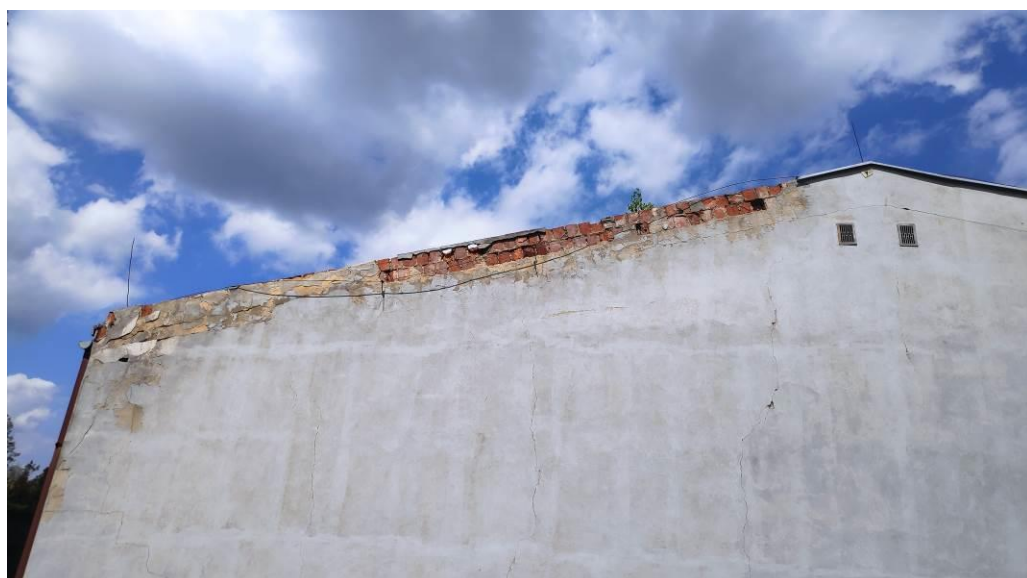
6. Brak obróbki blacharskiej ścian szczytowych. Widoczne odspojenia tynku elewacyjnego. Zmurszałe cegły z wywietrzałą zaprawą.
