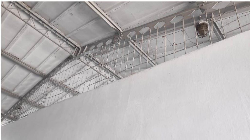
14. Widok korytkowych płyt dachowych, ażurowego dźwigara dachowego i ściany działowej.
