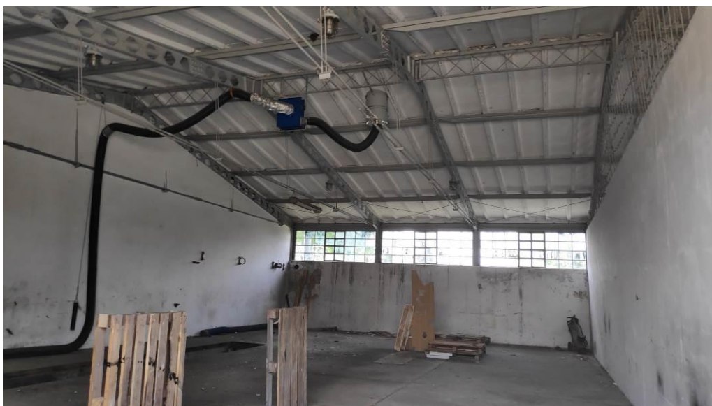
15. Widok korytkowych płyt dachowych, ażurowego dźwigara dachowego, stężeń połączonych i ściągów. Widoczna stolarka okienna.
