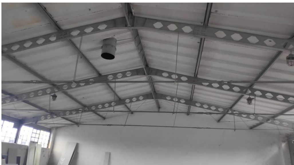
24. Widok korytkowych płyt dachowych, ażurowego dźwigara dachowego, stężeń połaciowych i ściągów. Widoczne zdeformowane wieszaki ściągow
