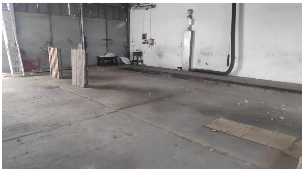
54. Widoczne przerwy dylatacyjne posadzki betonowej, kanał przebiegowy, bramy garażowe
