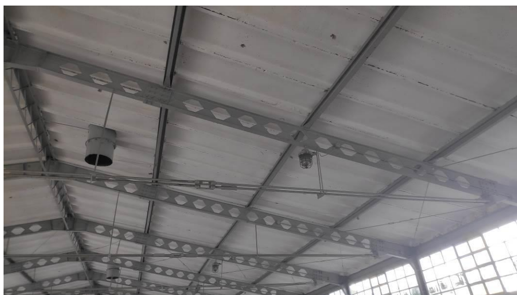
23. Widok korytkowych płyt dachowych, ażurowego dźwigara dachowego, stężeń połaciowych i ściągów. Widoczne zdeformowane wieszaki ściągow.
