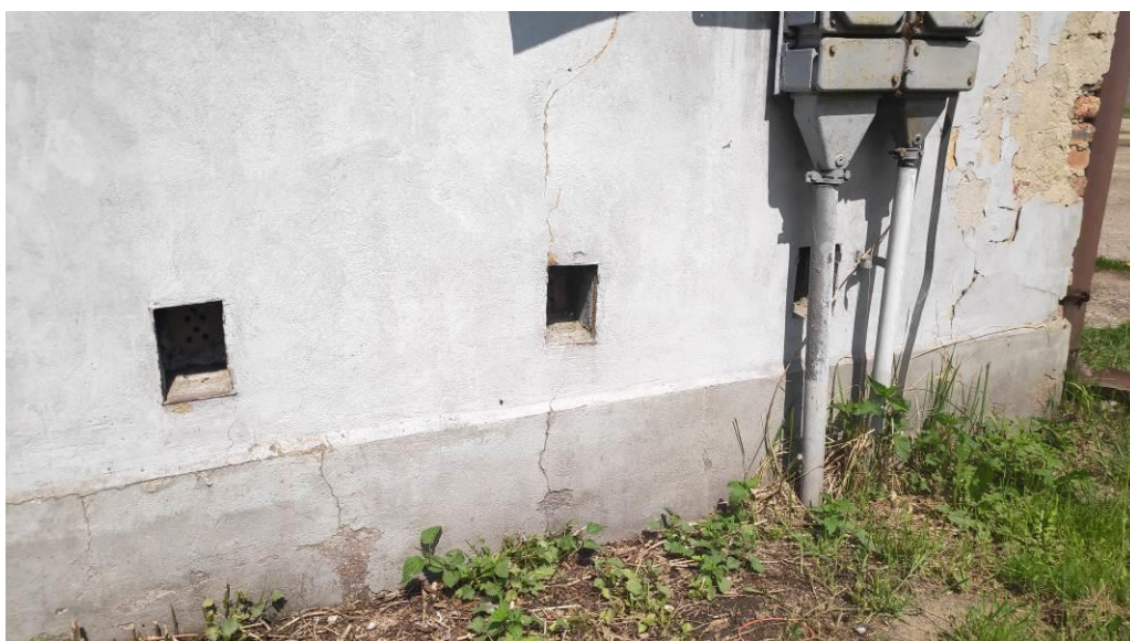
5. Zarysowania, odspojenia tynku na ścianie zewnątrznej. Widoczne cegły ceramiczne.
