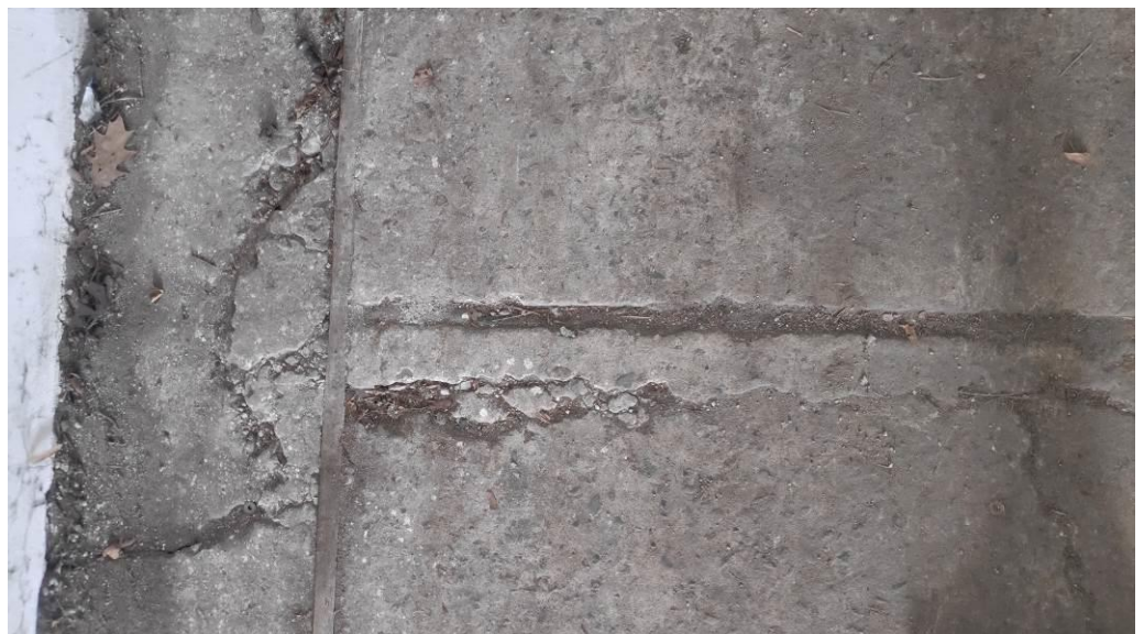
48. Widoczne przerwy dylatacyjne, zarysowania i spękania posadzki betonowej.
