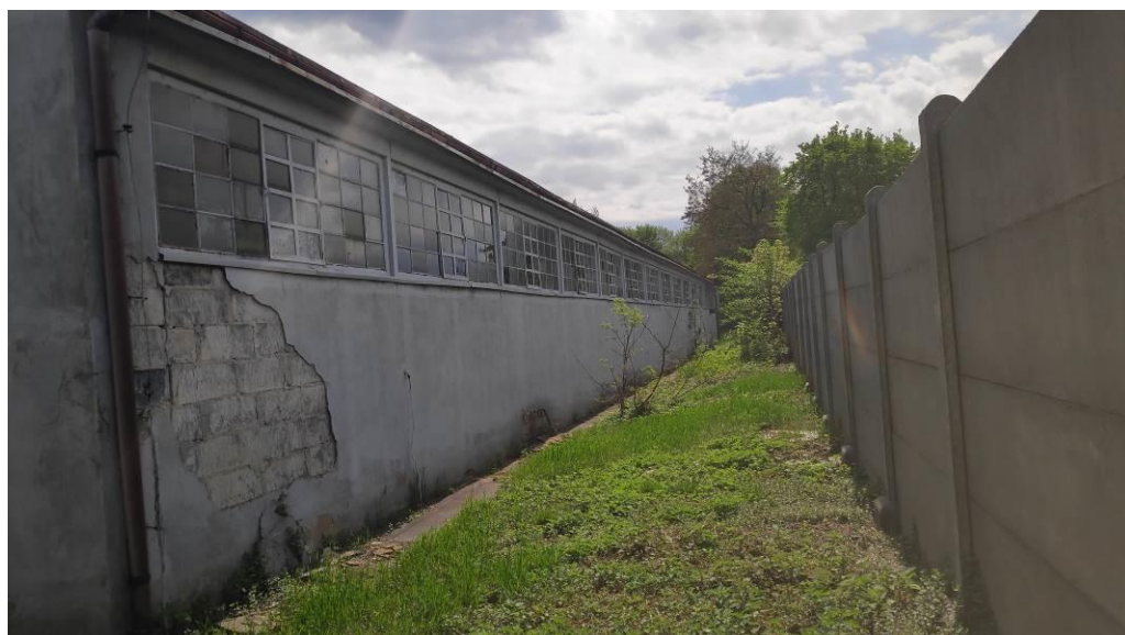
12. Zarysowania, odspojenia tynku na ścianie zewnętrznej. Widoczna stolarka okienna, ceramiczne i betonowe pustaki murowe, opaska budynku.
