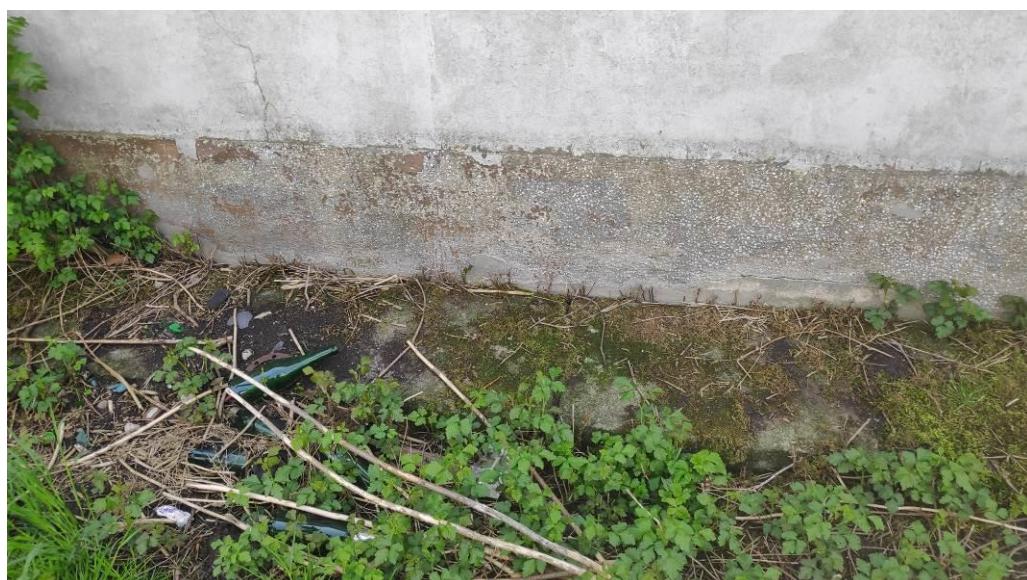
92. Betonowa opaska budynku.
