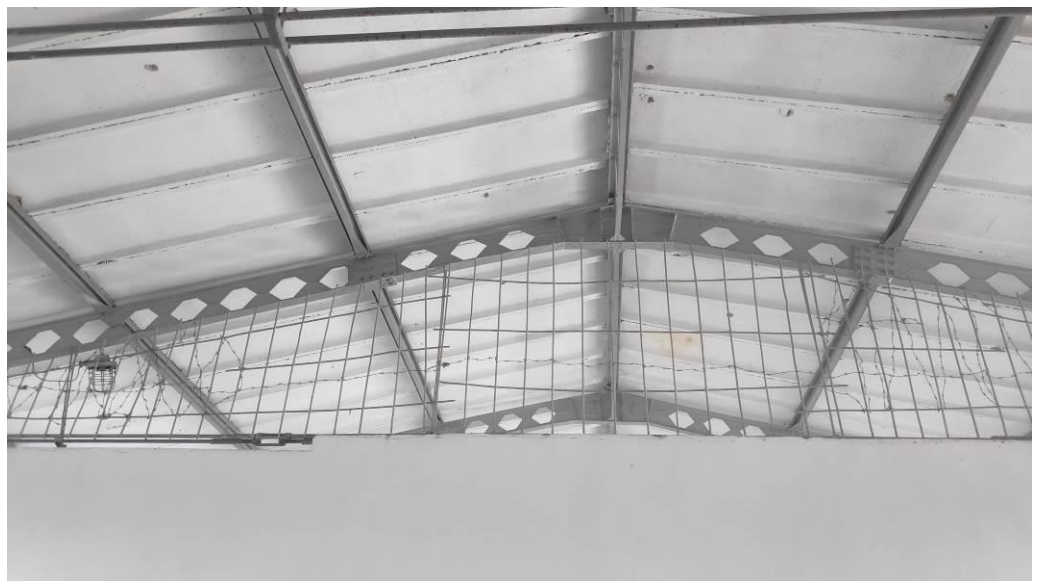
20. Widok korytkowych płyt dachowych, ażurowego dźwigara dachowego, stężeń połączeniowych i ściągów.
