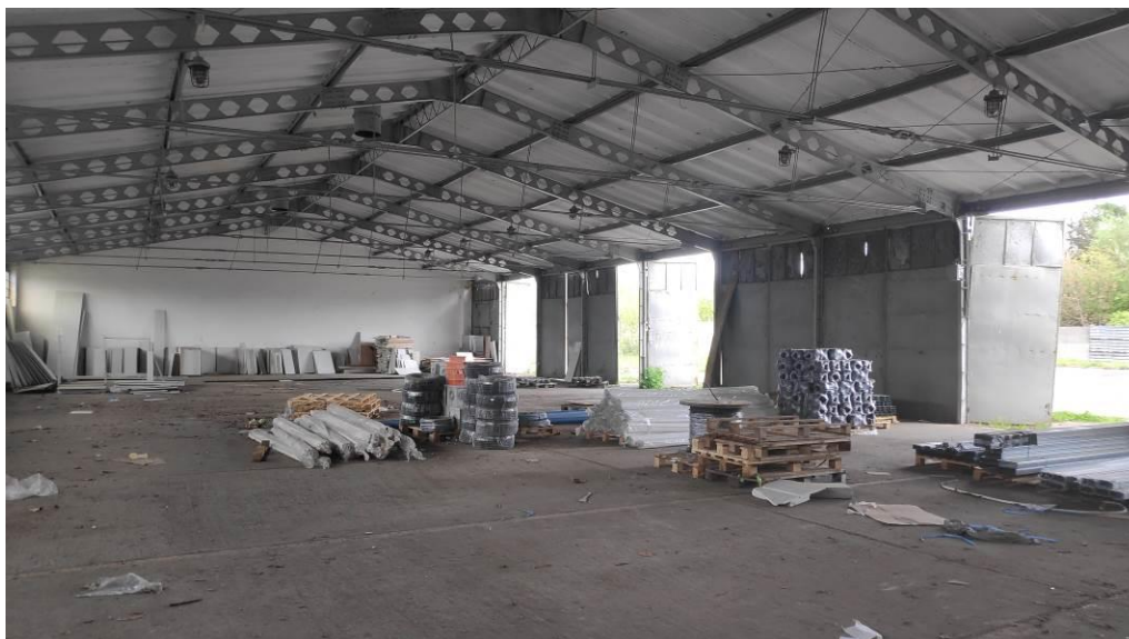
25. Wnętrze garażu. Widoczne bramy garażowe. Widok korytkowych płyt dachowych, ażurowego dźwigara dachowego, stężeń połaciowych i ściągów. Widoczne zdeformowane wieszaki ściągów
