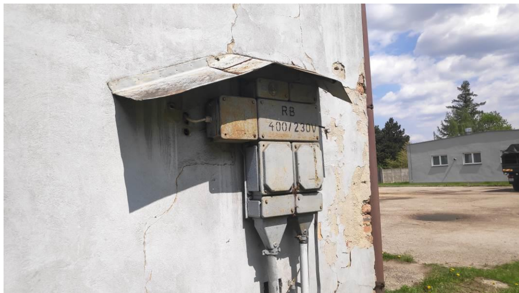
94.Instalacja elektryczna – tablica rozdzielcza.
