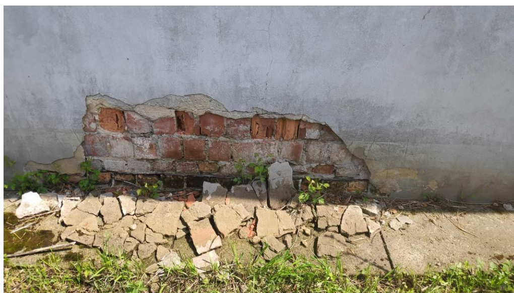
11. Odspojenie tynku na cokole ściany zewnętrznej. Widoczne ceramiczne pustaki murowe z wykruszoną, wywietrzałą zaprawą, opaska budynku.
