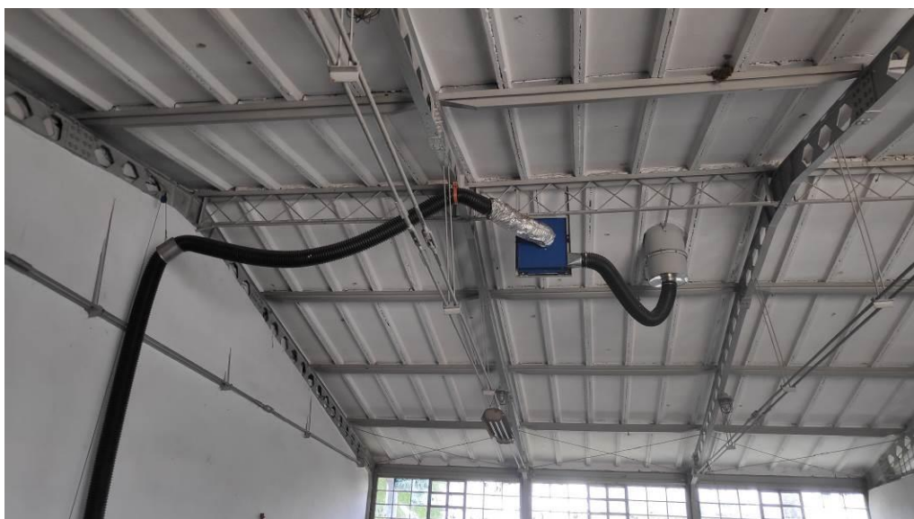
17. Widok korytkowych płyt dachowych, ażurowego dźwigara dachowego, stężeń połaciowych i ściągów. Widoczna stolarka okienna.
