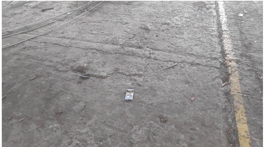
46. Widoczne przerwy dylatacyjne i zarysowania posadzki betonowej.
