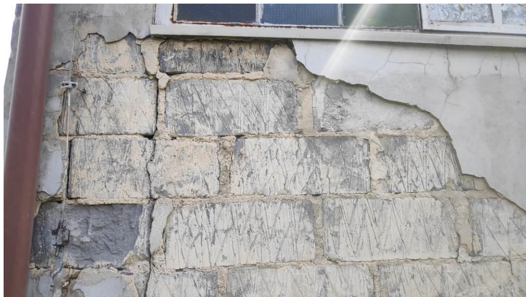
10. Odspojenie tynku na ścianie zewnętrznej. Widoczne betonowe pustaki murowe z wykruszoną, wywietrzałą zaprawą.
