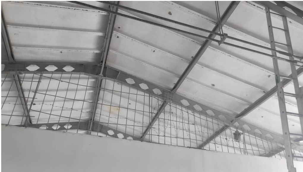
19. Widok korytkowych płyt dachowych, ażurowego dźwigara dachowego, stężeń połączeniowych i ściągów.
