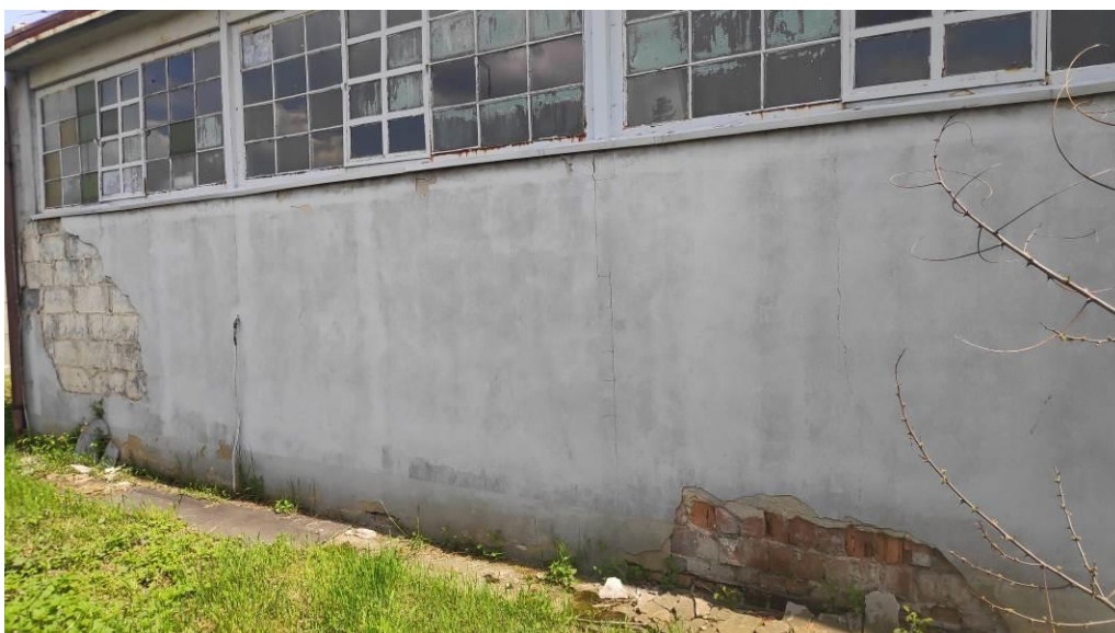
9. Zarysowania, odspojenia tynku na ścianie zewnątrznej. Widoczna stolarka okienna, ceramiczne i betonowe pustaki murowe, opaska budynku.
