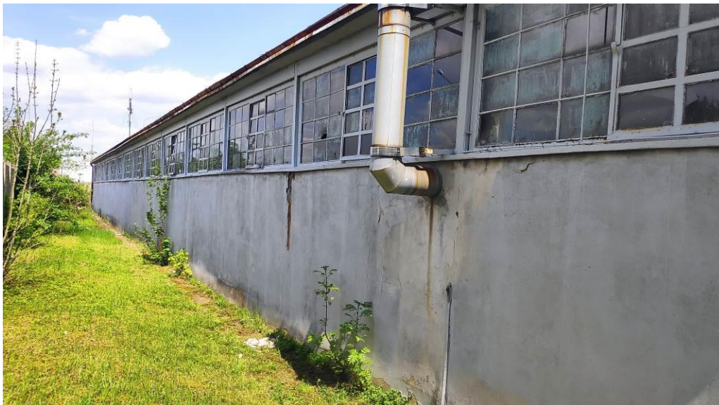
7. Zarysowania, odspojenia tynku na ścianie zewnątrznej. Widoczna stolarka okienna.
