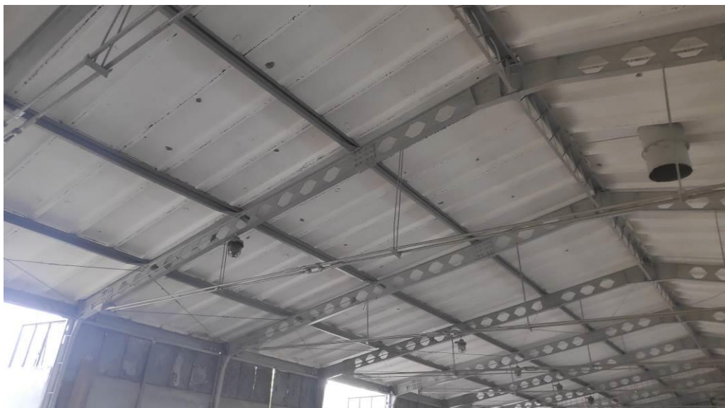
22. Widok korytkowych płyt dachowych, ażurowego dźwigara dachowego, stężeń połaciowych i ściągów.
