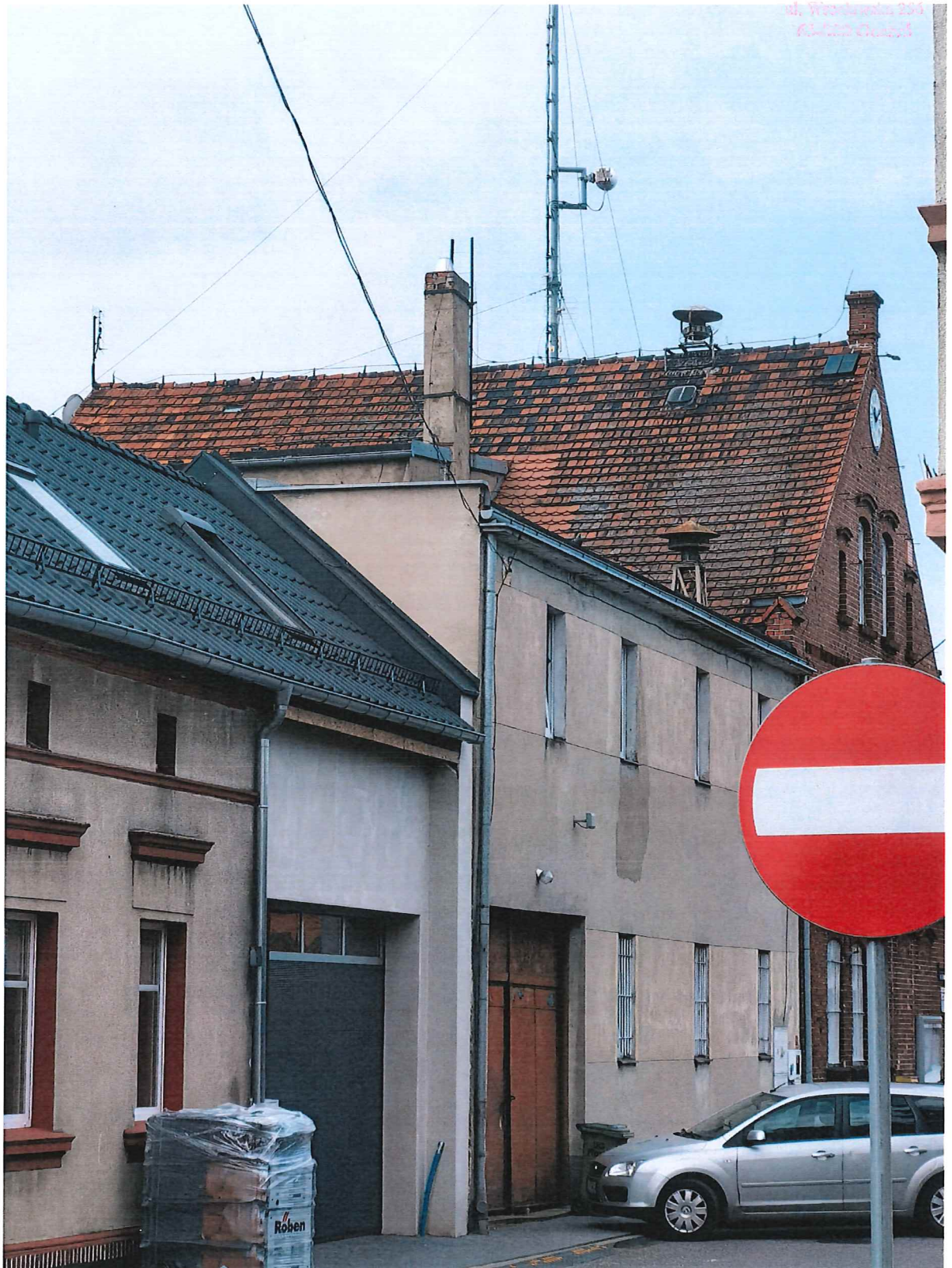
Ryc. 3. Komin do przemurowania i elementy do konserwacji.
