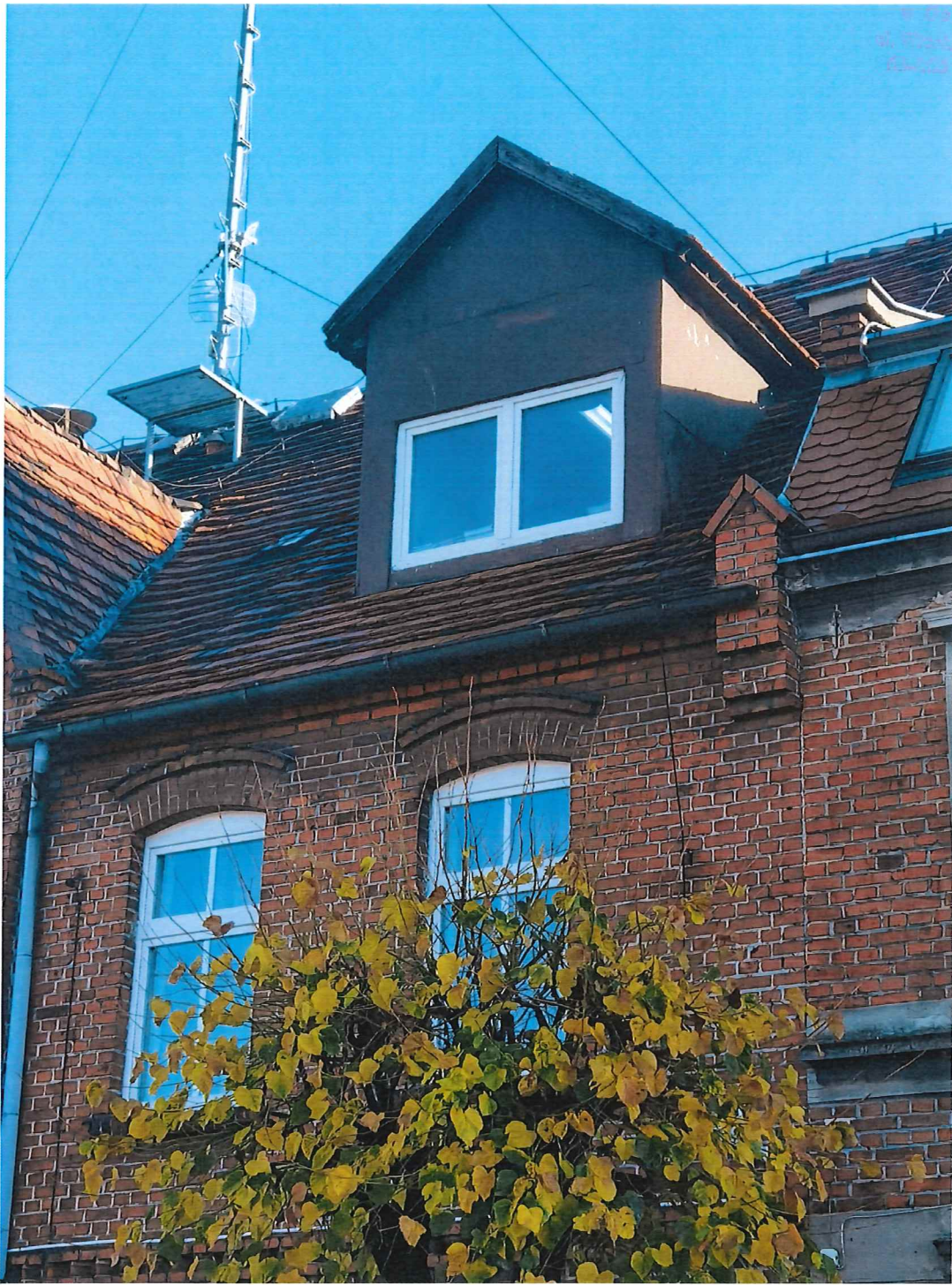
Ryc. 2. Wystawka przeznaczona do docieplenia.
