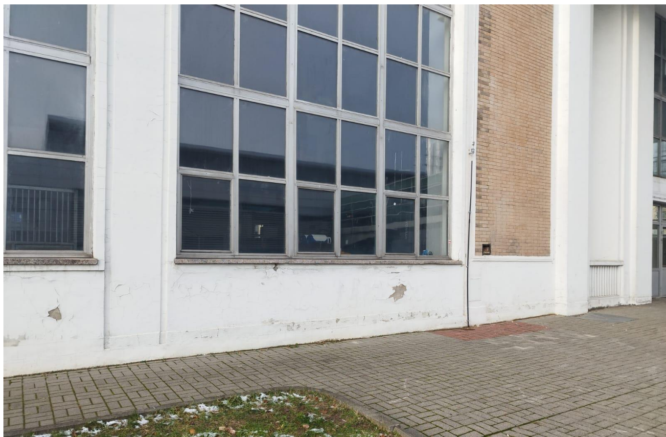
fol. 17 Widok elewację wschodnią, 2023, materiały własne
