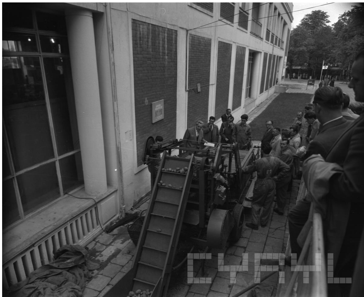
fot. 12 Widok na fragment elewacji zachodniej, (źródło: cyryl.poznan.pl)
