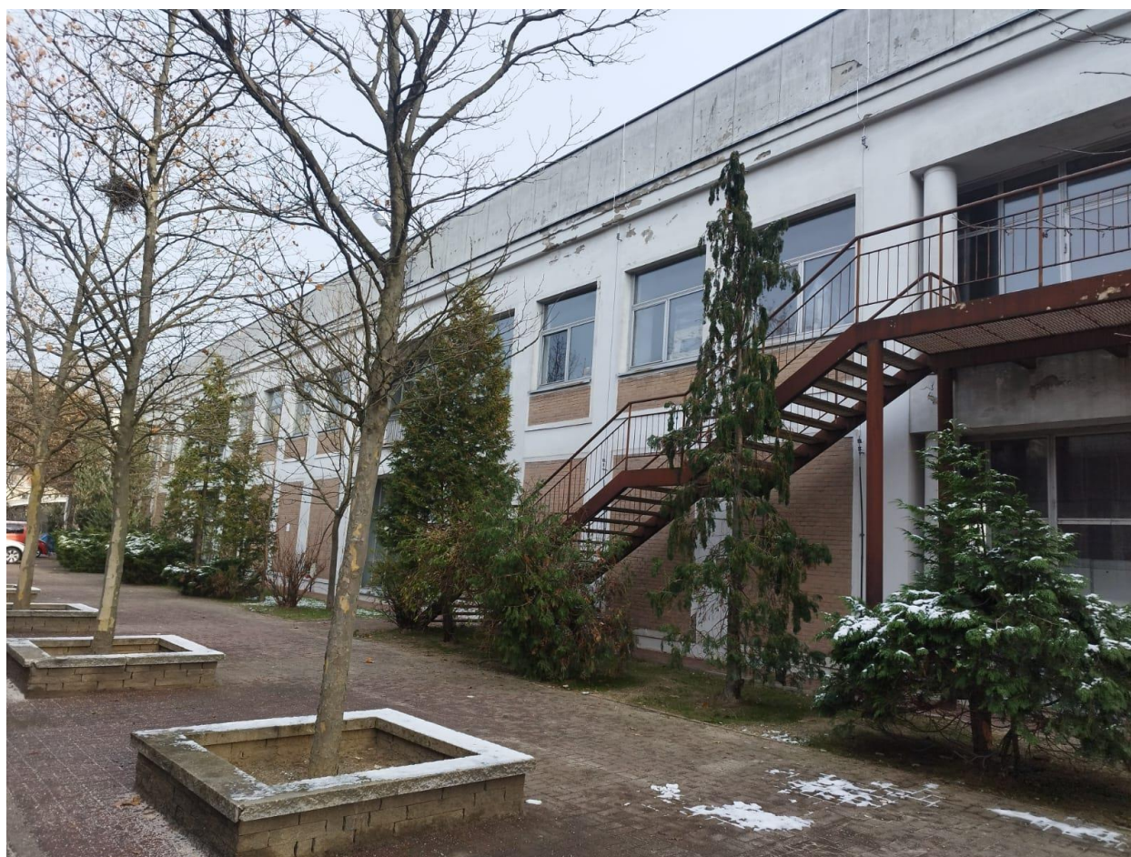
fot. 15 Widok na elewację zachodnią, 2023, materiały własne
