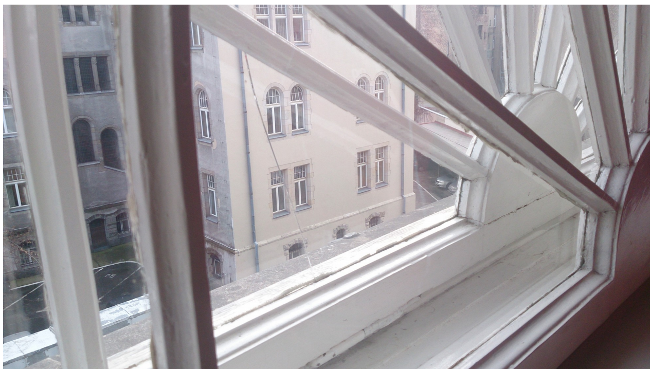
Fot. 1. Okna skrzynkowe, zabytkowe
