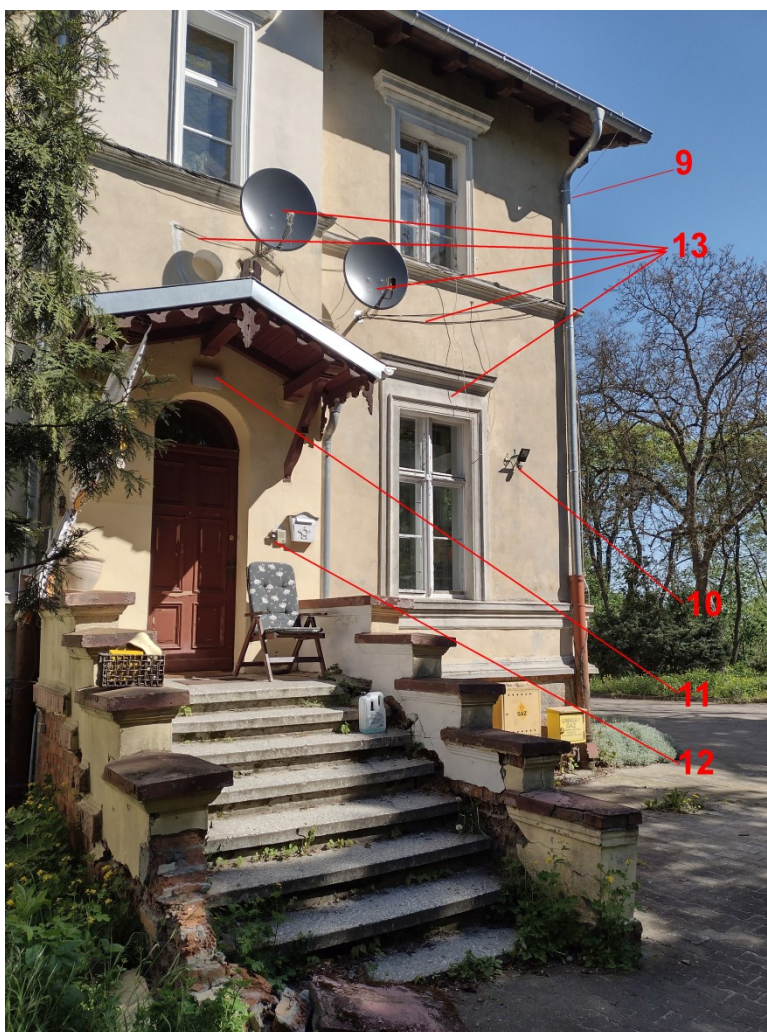
Zdjęcie nr 3. Elewacja południowa
