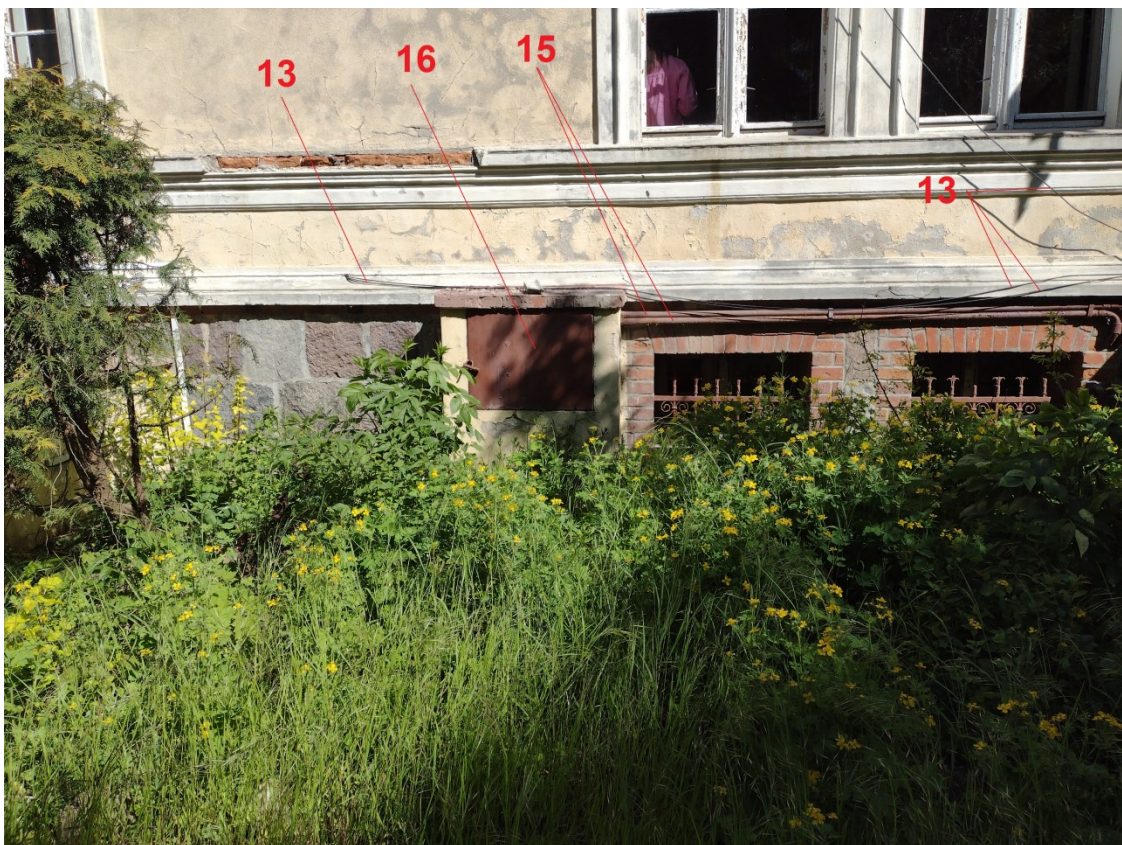
Zdjęcie nr 5. Elewacja południowa
