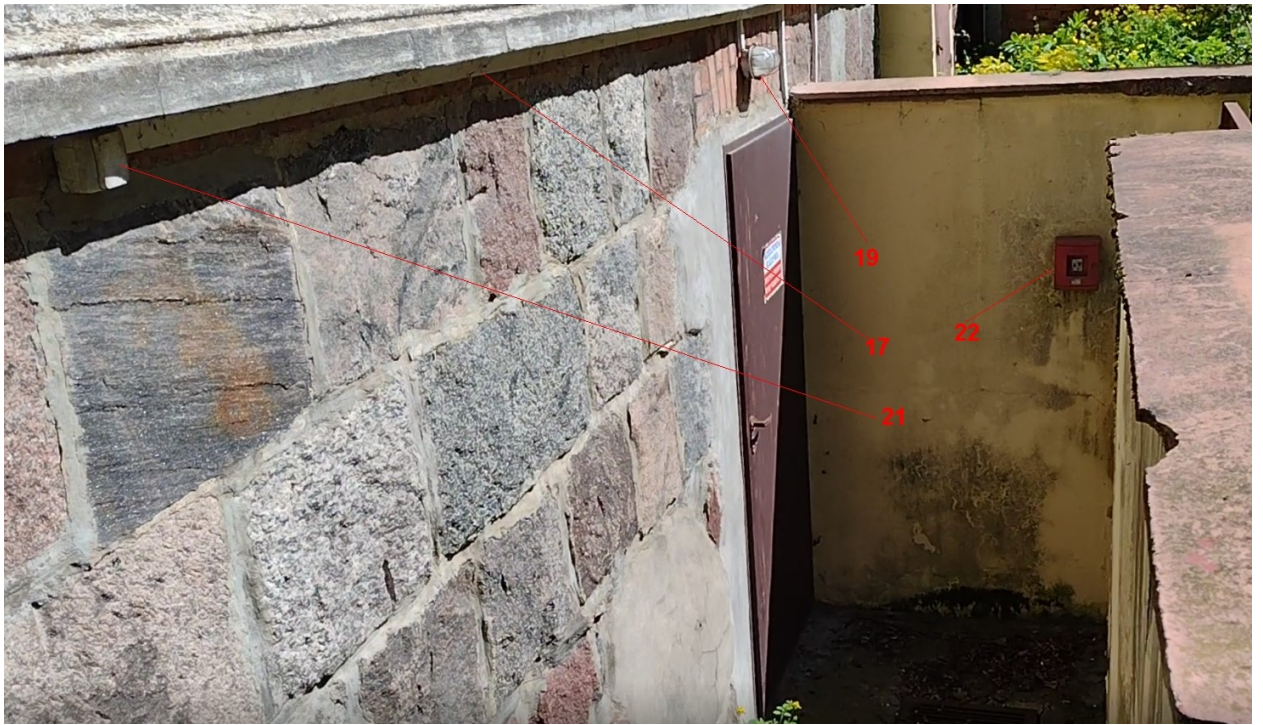
Zdjęcie nr 8. Elewacja południowa
