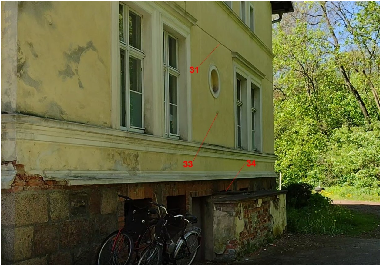
Zdjęcie nr 11. Elewacja północna
