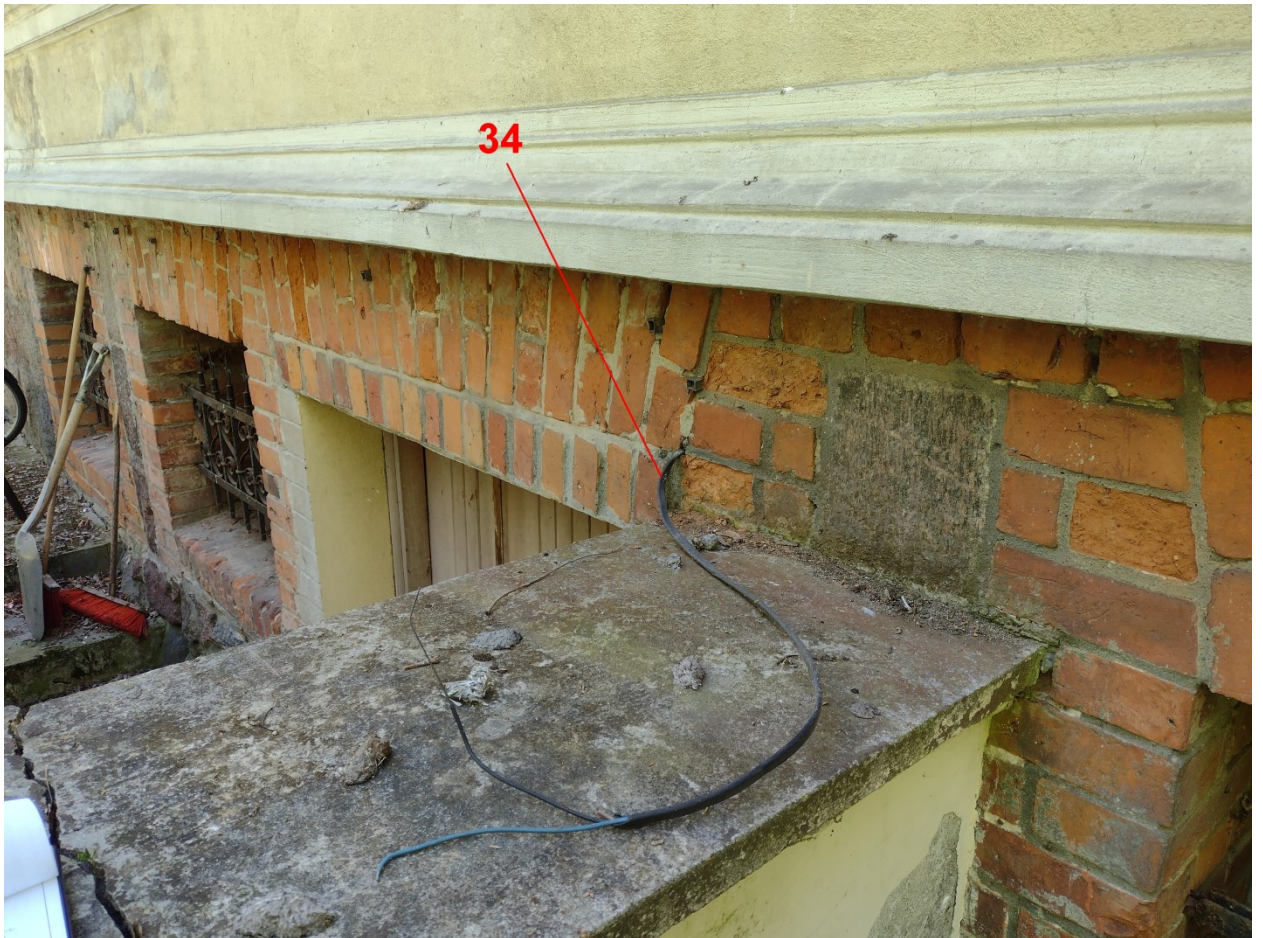
Zdjęcie nr 12. Elewacja północna
