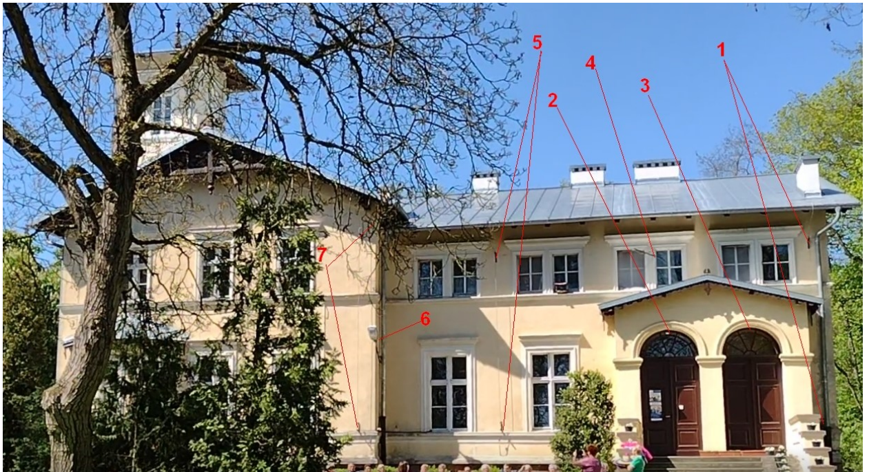
Zdjęcie nr 1. Elewacja frontowa – wschodnia
