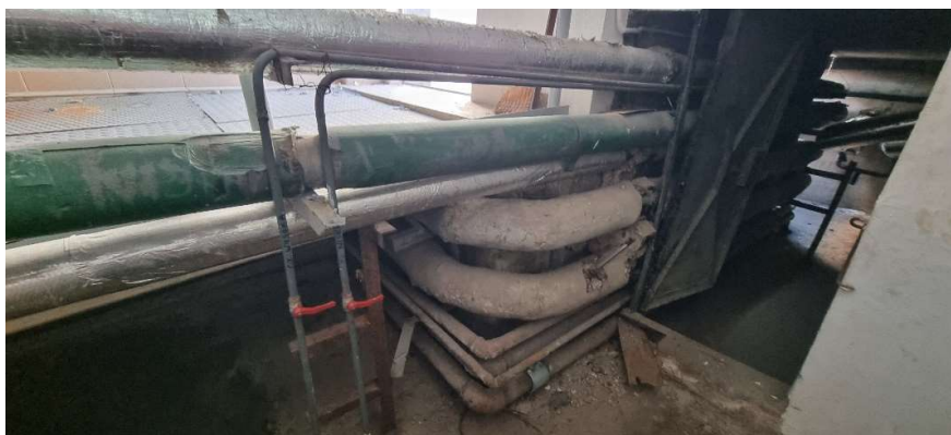
Zdjęcie 4 Wejście do kanału technicznego przełazowego od strony węzła cieplnego
