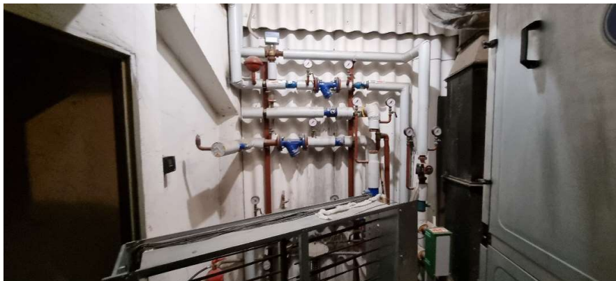
Zdjęcie 3 Fragment istniejącej centrali wentylacyjnej , oraz pod węzła ciepła technologicznego
