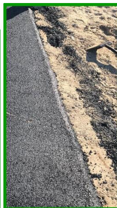
Prawidłowo sfazowane krawędzie, wykonane w równej linii, bez pęknięć i ubytków.
