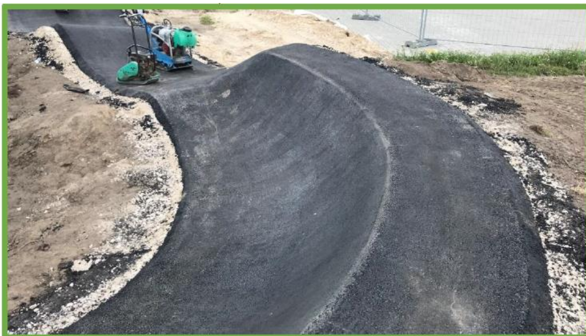
Prawidłowo wykonana nawierzchnia asfaltowa –jednorodna i gładka.
