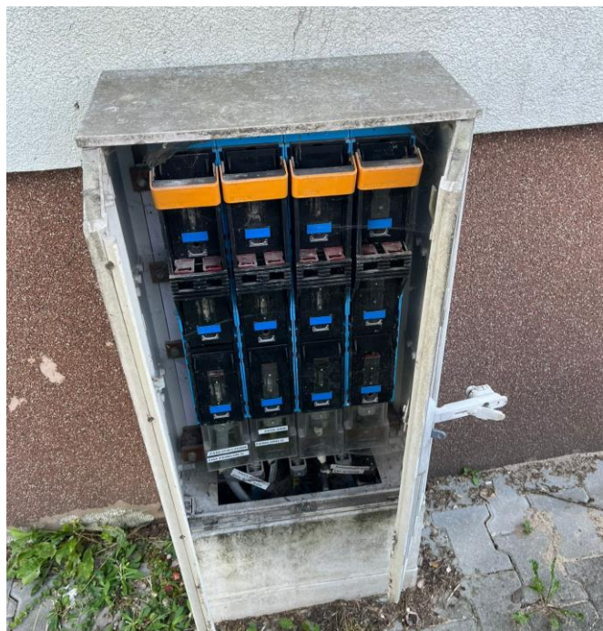
Istniejące Złącze Kablowe pawilonu „D” z wolną rezerwą rozłącznika listwowego
