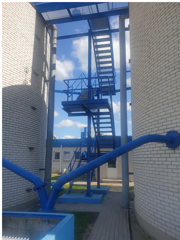
Fot. 12 Zbiorniki tlenowej stabilizacji ZTSO1, ZTSO2 – schody
