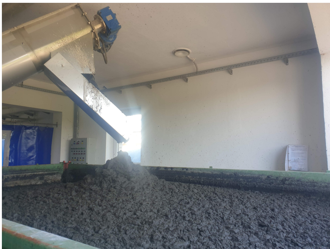
Fot. 7 Budynek socjalno-techniczny – pomieszczenie SHO
