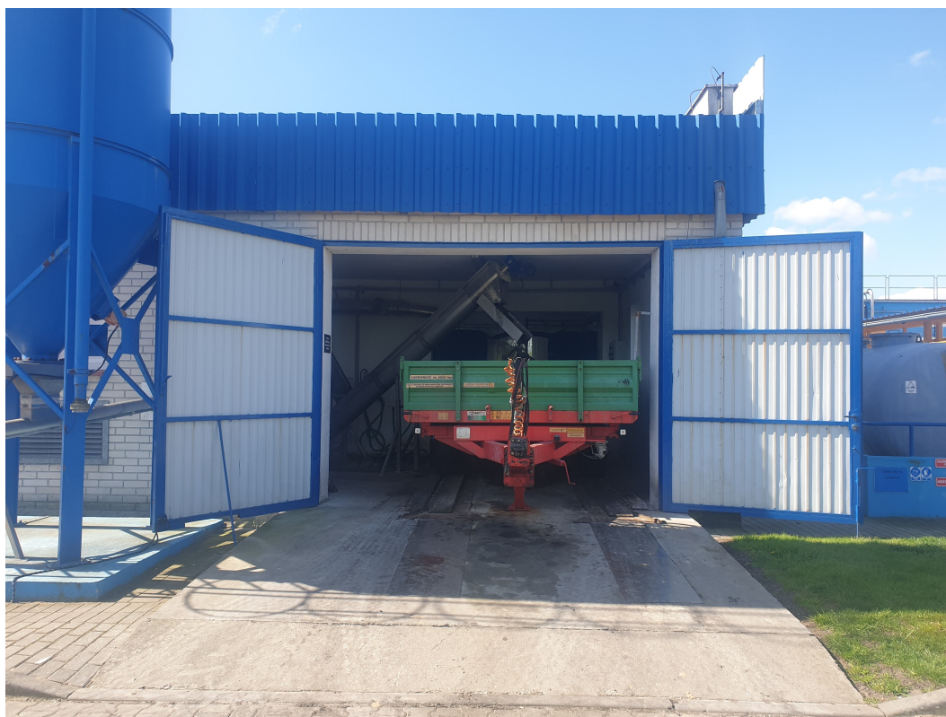
Fot. 4 Budynek socjalno-techniczny – widok na bramę do pomieszczenia SHO
