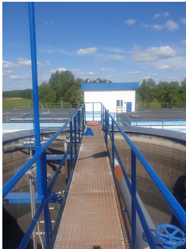
Fot. 11 Zbiorniki tlenowej stabilizacji ZTSO1 – pomost
