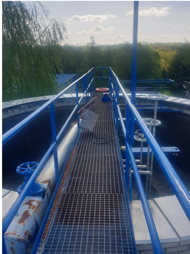
Fot. 10 Zbiorniki tlenowej stabilizacji ZTSO2 – pomost
