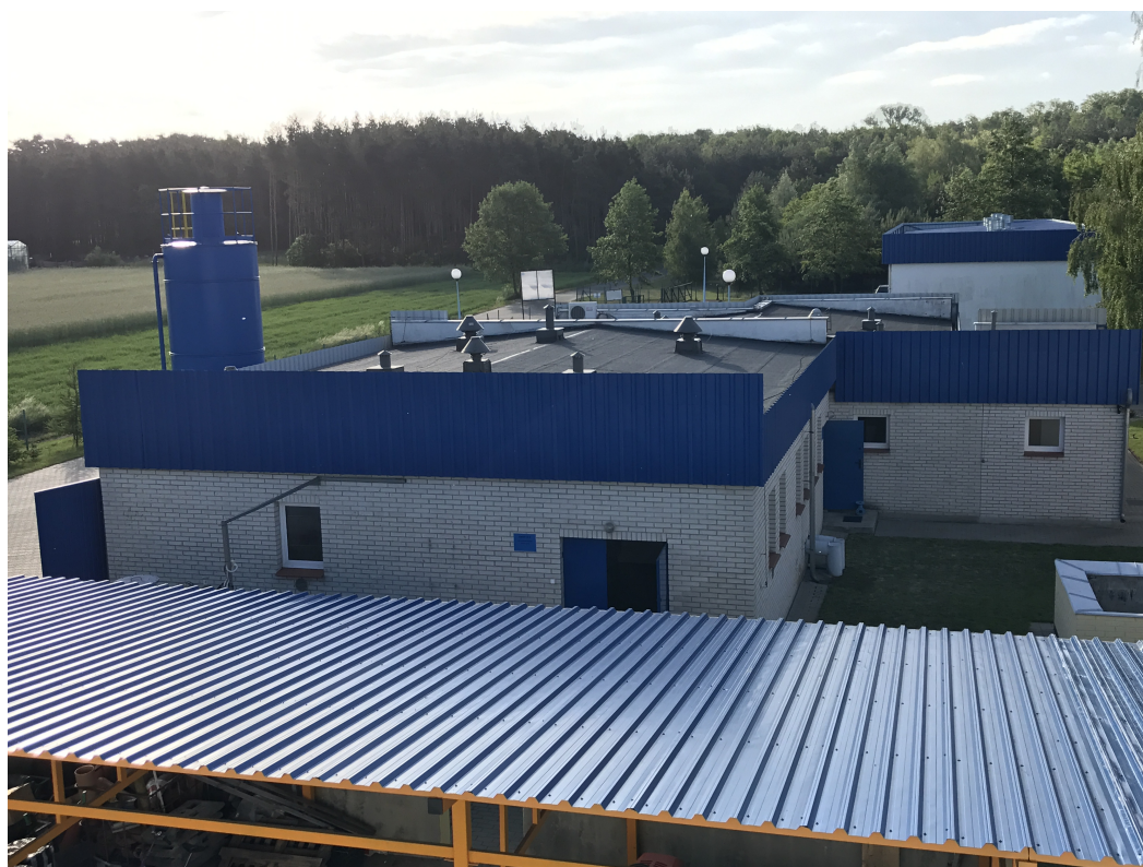
Fot. 3 Rzut dachu budynku socjalno-technicznego – widok od strony zachodniej
