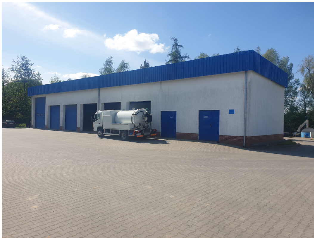
Fot. 2 Budynek garażowo-magazynowo-warsztatowy – ściana północna
