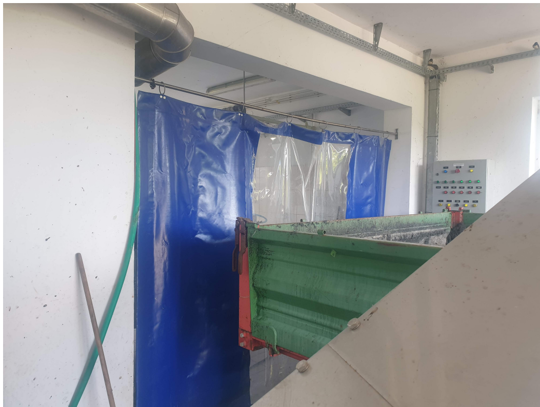
Fot. 8 Budynek socjalno-techniczny – pomieszczenie SHO, widok na przejście do pomieszczenia SOO
