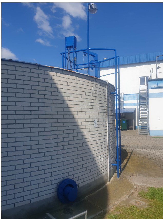
Fot. 13 Zbiornik nadawy ZN – widok na wejście na zbiornik i pomost
