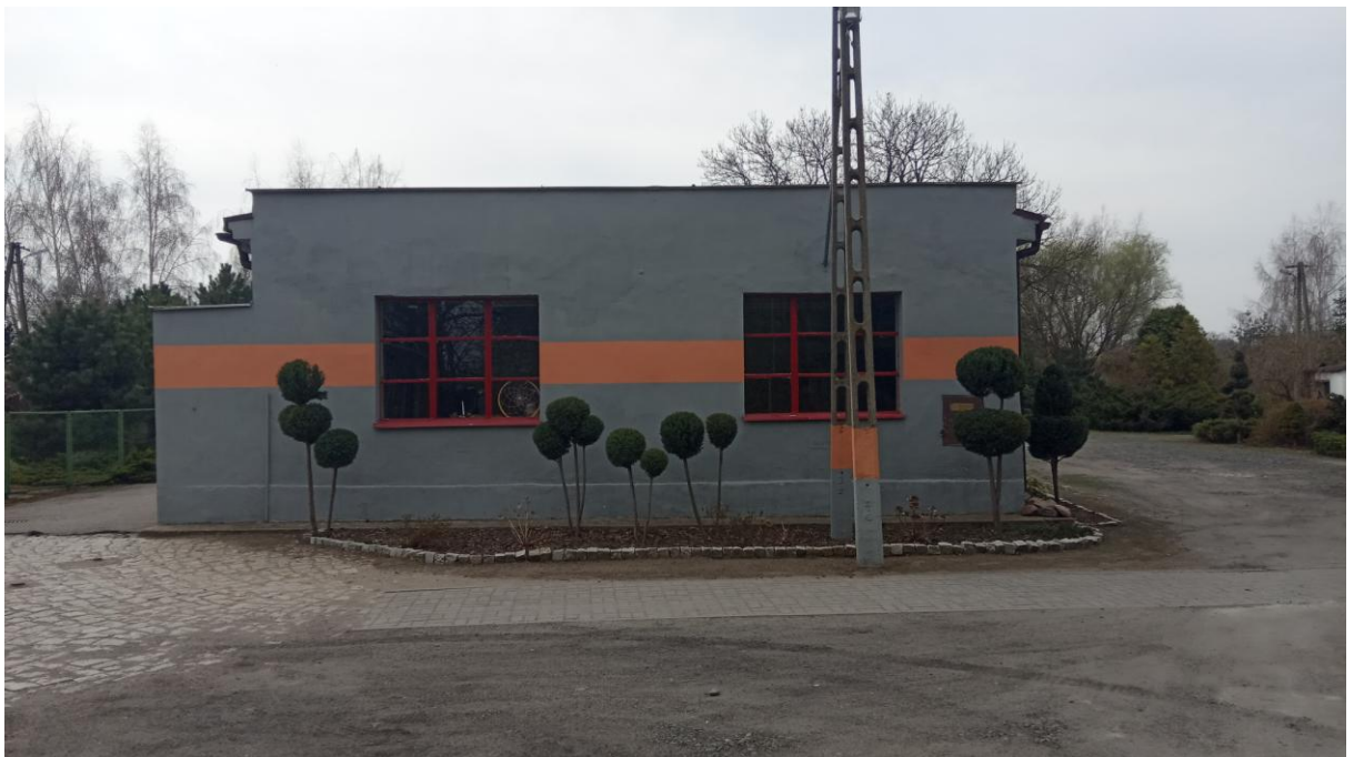
fot. 2 - elewacja północna
