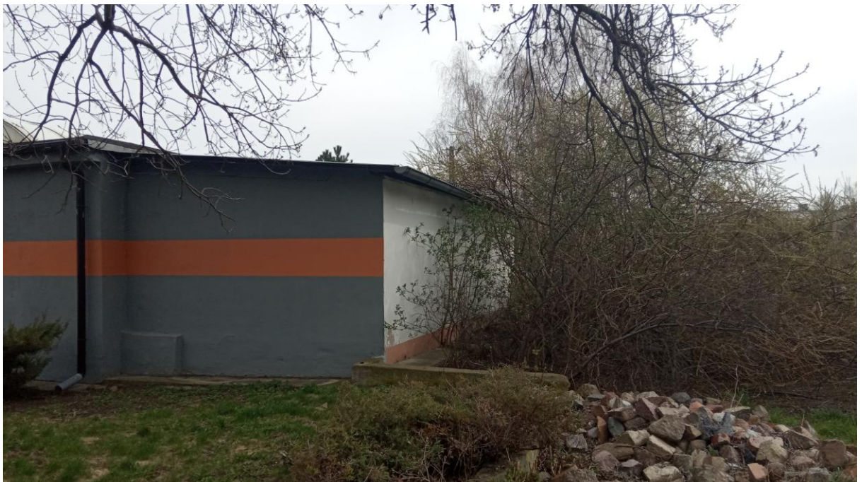
fot. 4 - elewacja południowa
