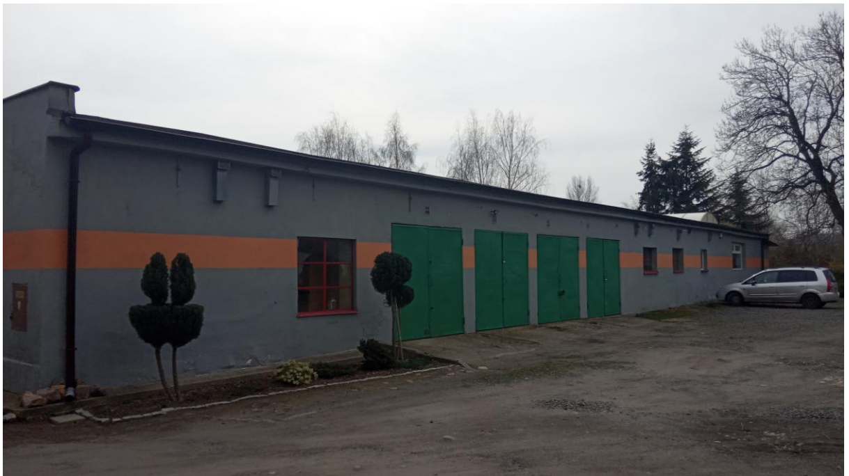
fot. 3 - elewacja zachodnia
