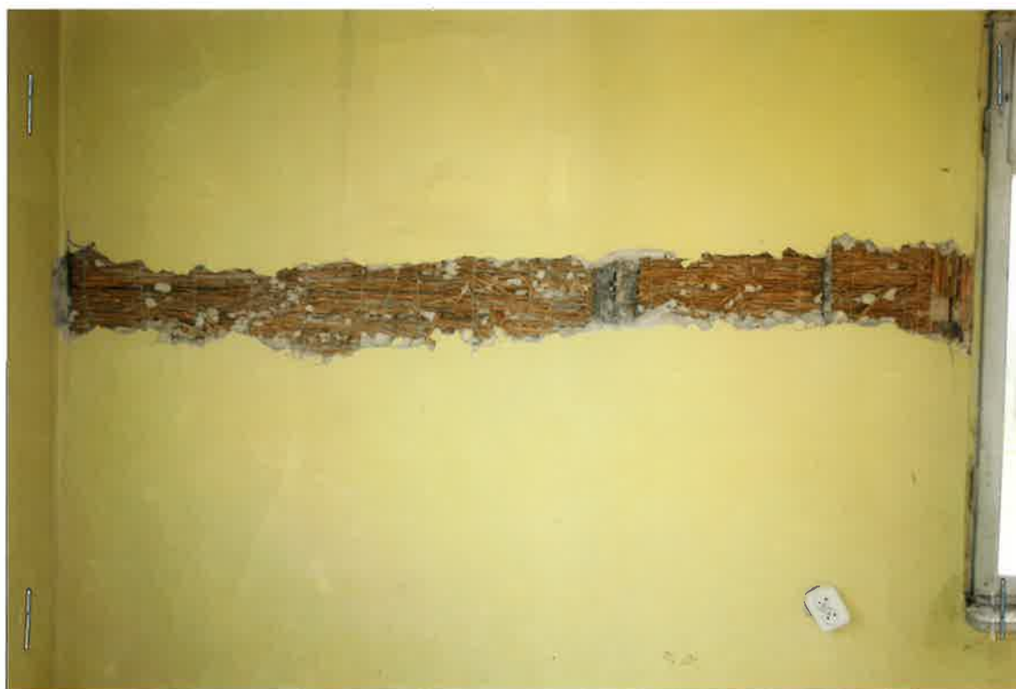
Zdjęcie 6 – Parter – odkrywka w ścianie zewnętrznej
