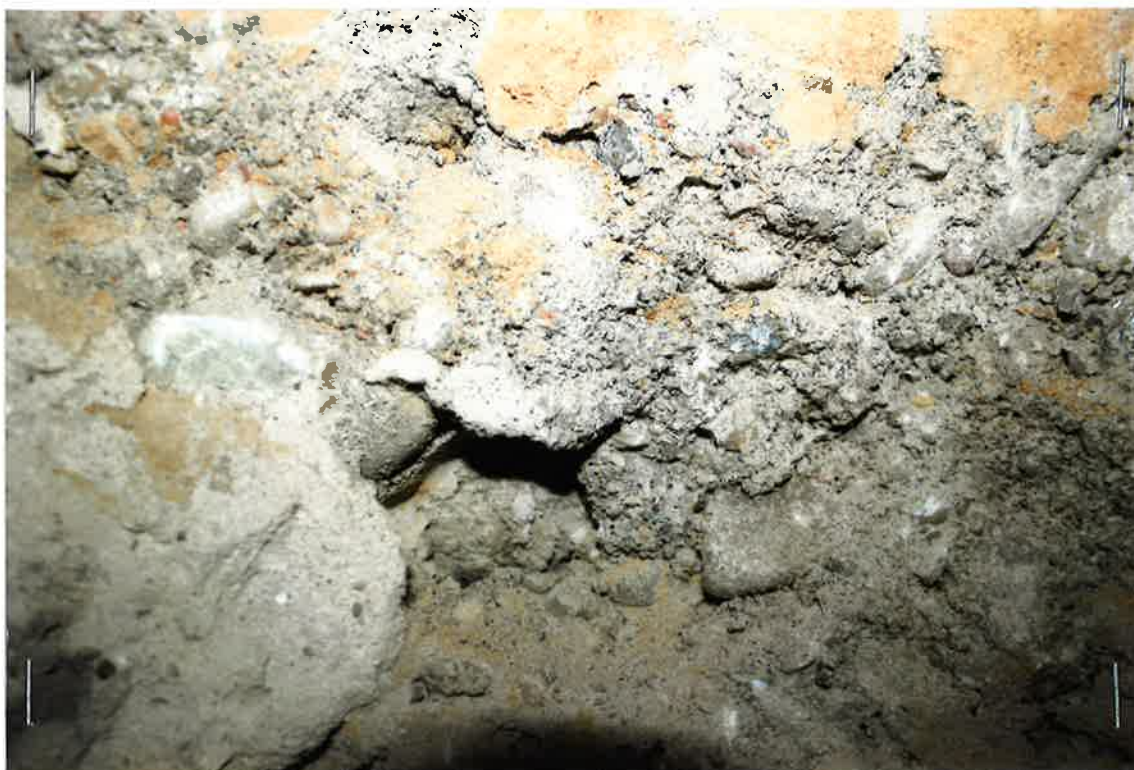
Zdjęcie 17 – Piwnica – odkrywka w ścianie zewnętrznej
