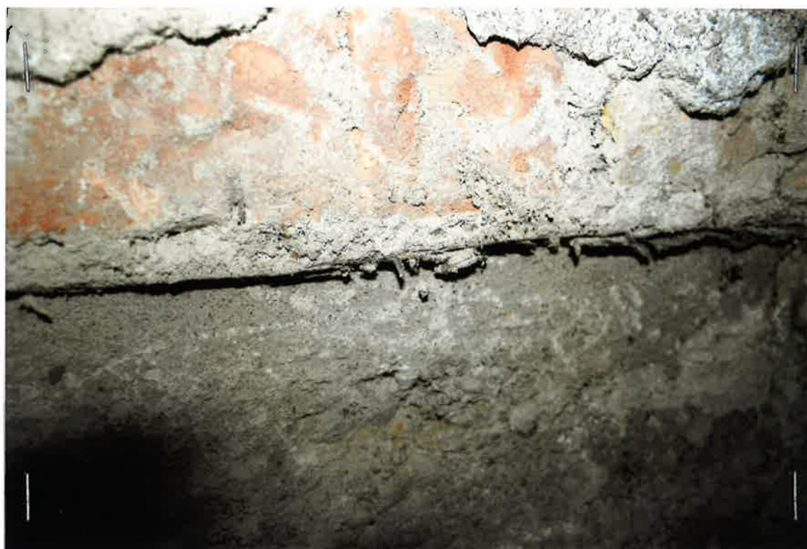
Zdjęcie 13 – Piwnica – położenie izolacji poziomej ścian
