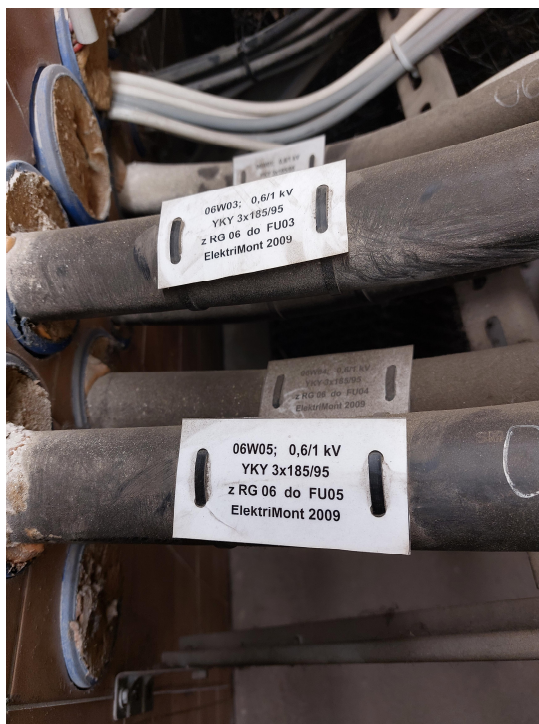
Zdj. 5 – Przekrój kabli zasilających istniejące dmuchawy
