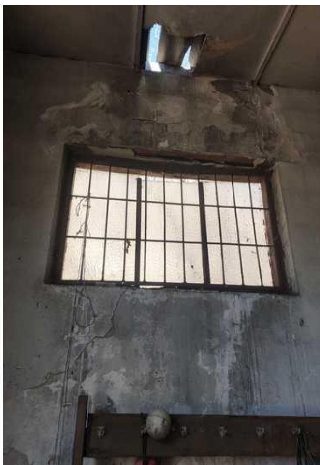
Zdjęcie nr 11. Budynek magazynowy.
