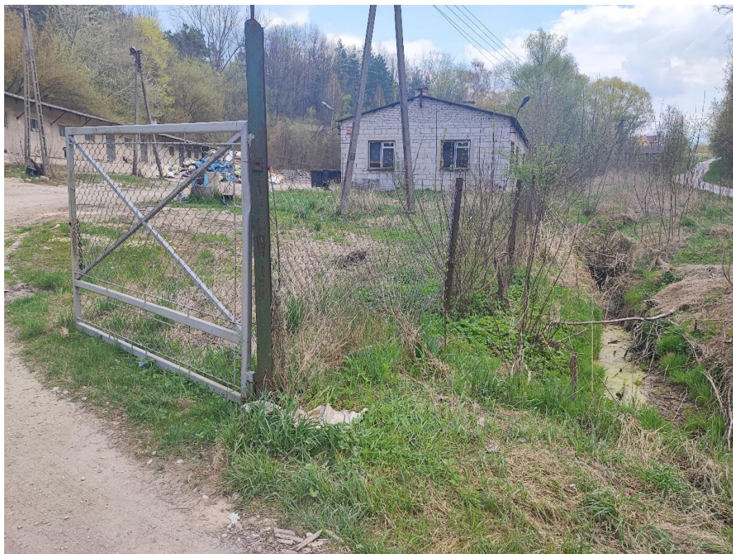
Zdjęcie nr 15. Brama, ogrodzenie.
