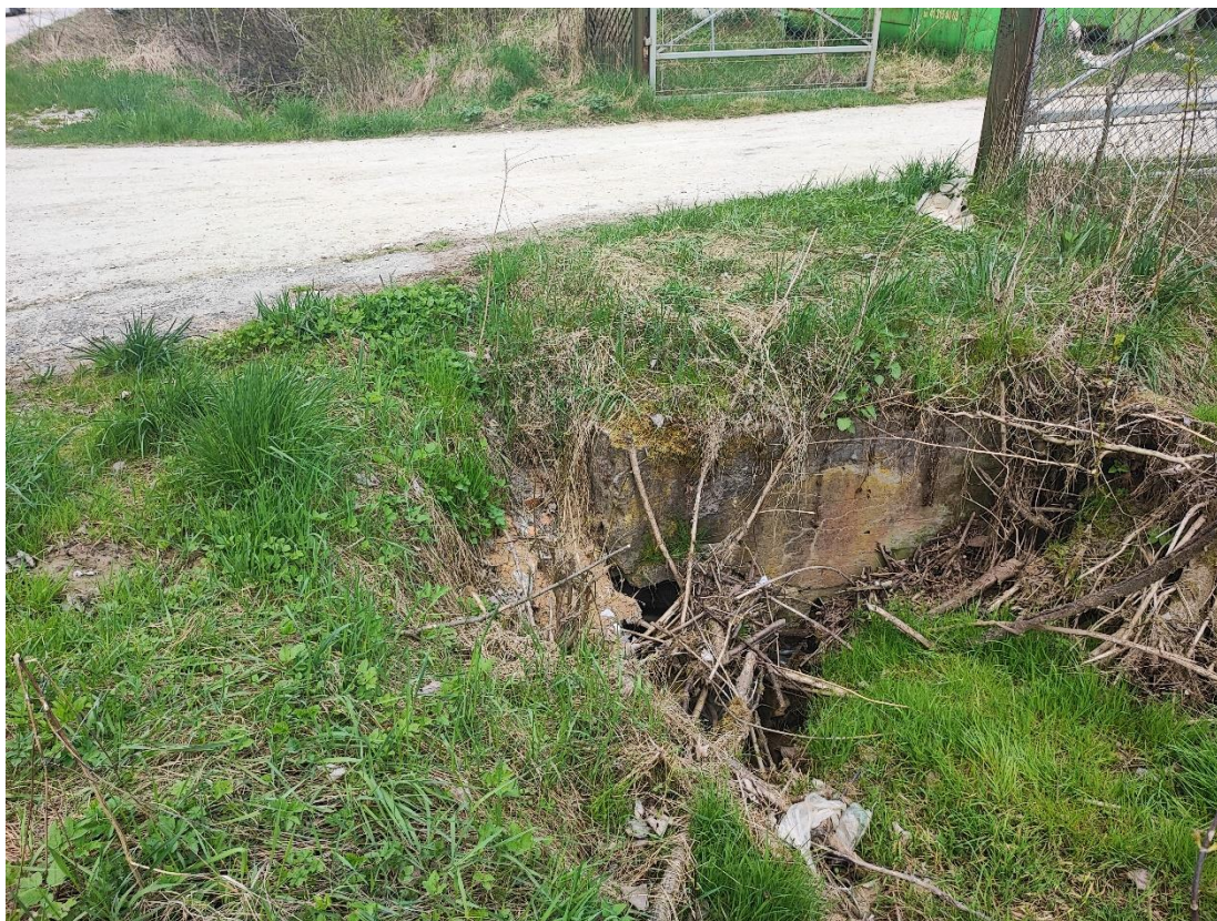
Zdjęcie nr 14. Wjazd na teren PSZOK – przepust drogowy.
