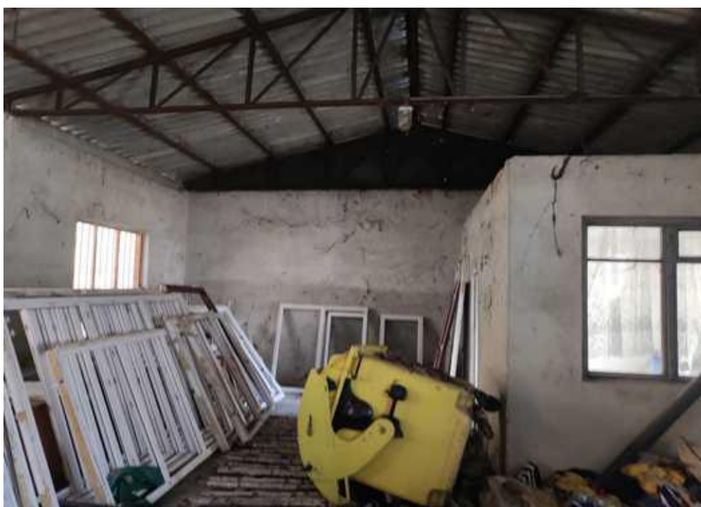
Zdjęcie nr 13. Budynek magazynowy.
