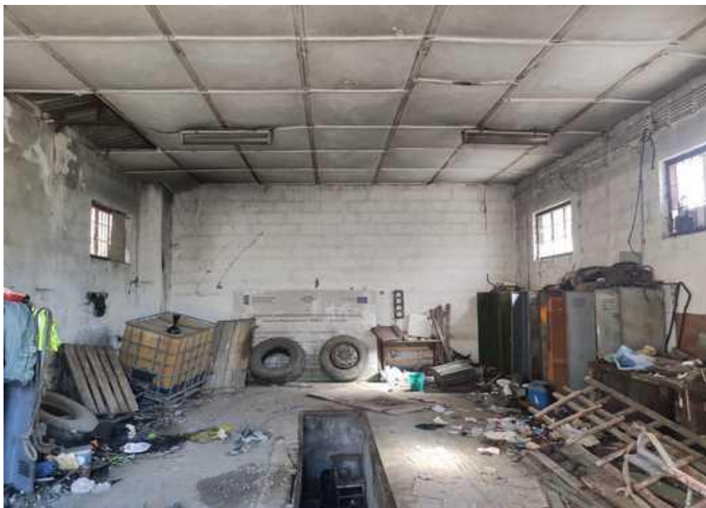
Zdjęcie nr 10. Budynek magazynowy.
