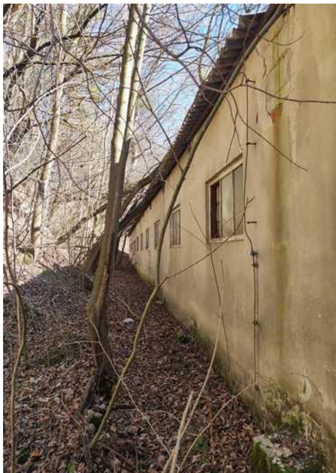
Zdjęcie nr 12. Budynek magazynowy – strona północna.
