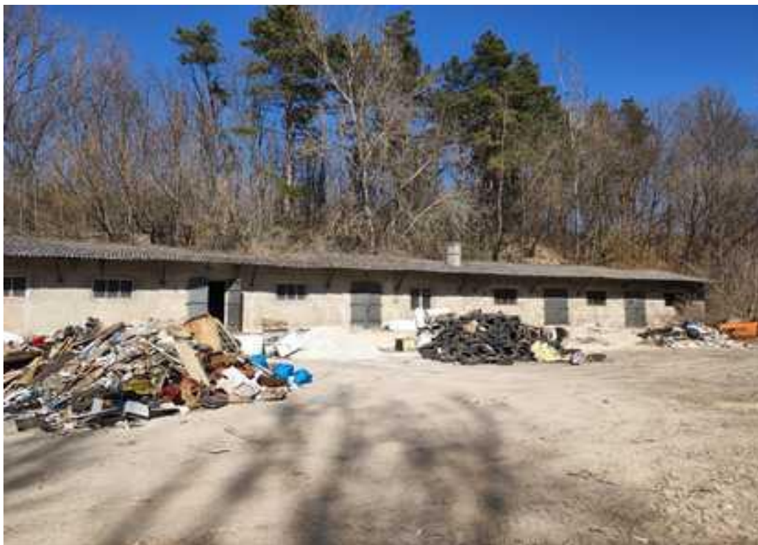
Zdjęcie nr 6. Budynek magazynowy, plac.
