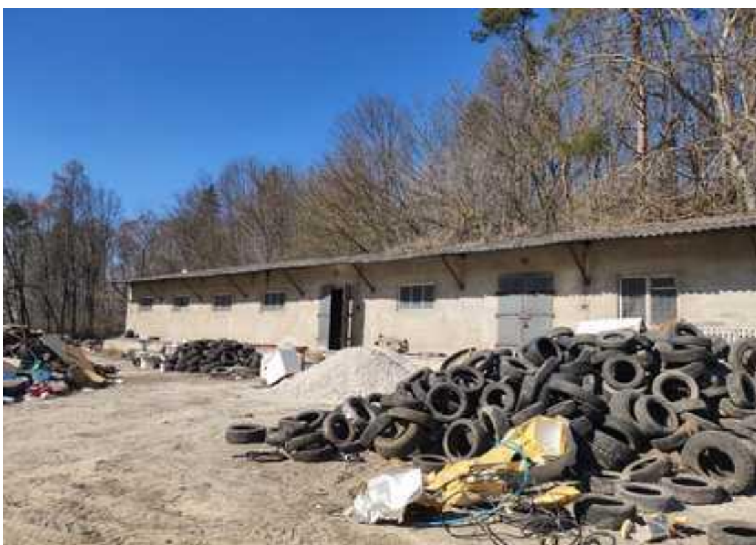
Zdjęcie nr 7. Budynek magazynowy, plac.
