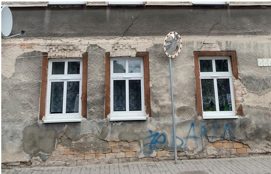
Elewacja frontowa – uszkodzenia tynku w strefie przyziemia
