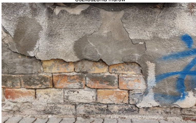
Wysolenia na ceglach, degradacja spoin i tynku
