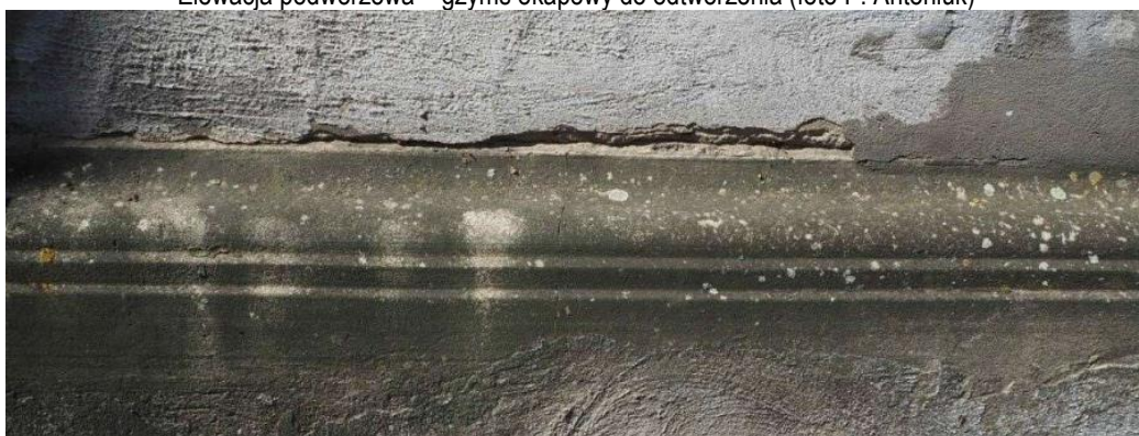
Elewacja podwórzowa – gzyms cokolowy do odtworzenia (foto P. Antoniuk)
