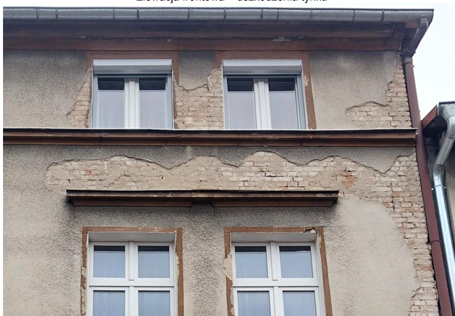
Elewacja frontowa – uszkodzenia tynku
