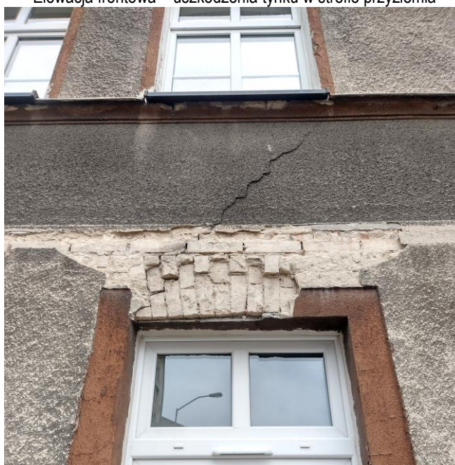
Uszkodzenia murów
