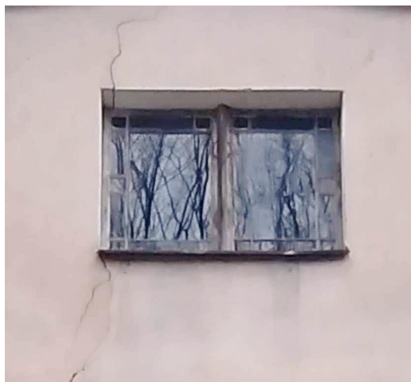
Okno do renowacji, pęknięcia muru
