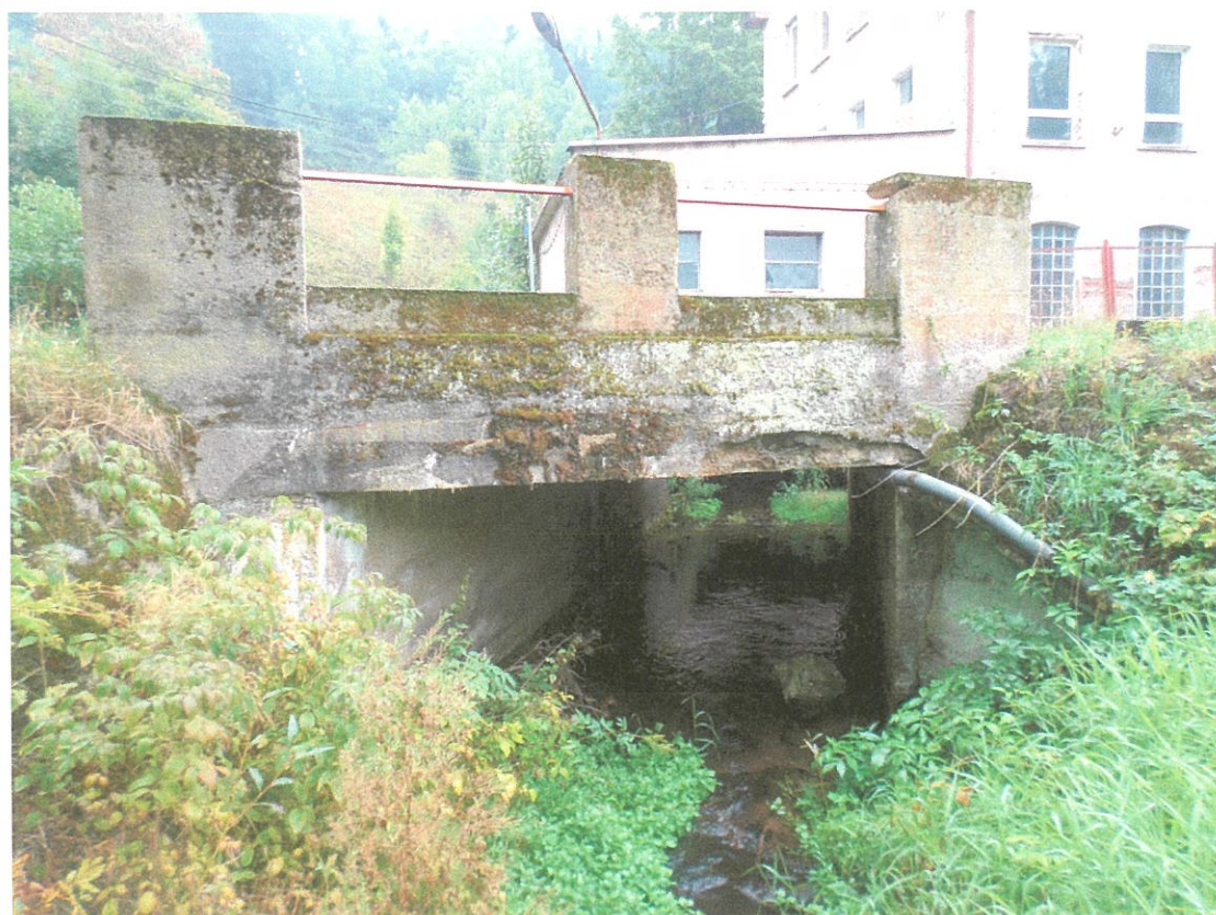
Fot. 2. Widok obiektu od strony górnej wody.
