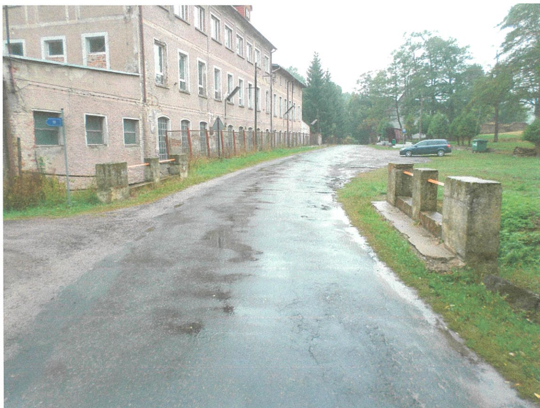
Fot. 1. Widok ogólny obiektu
