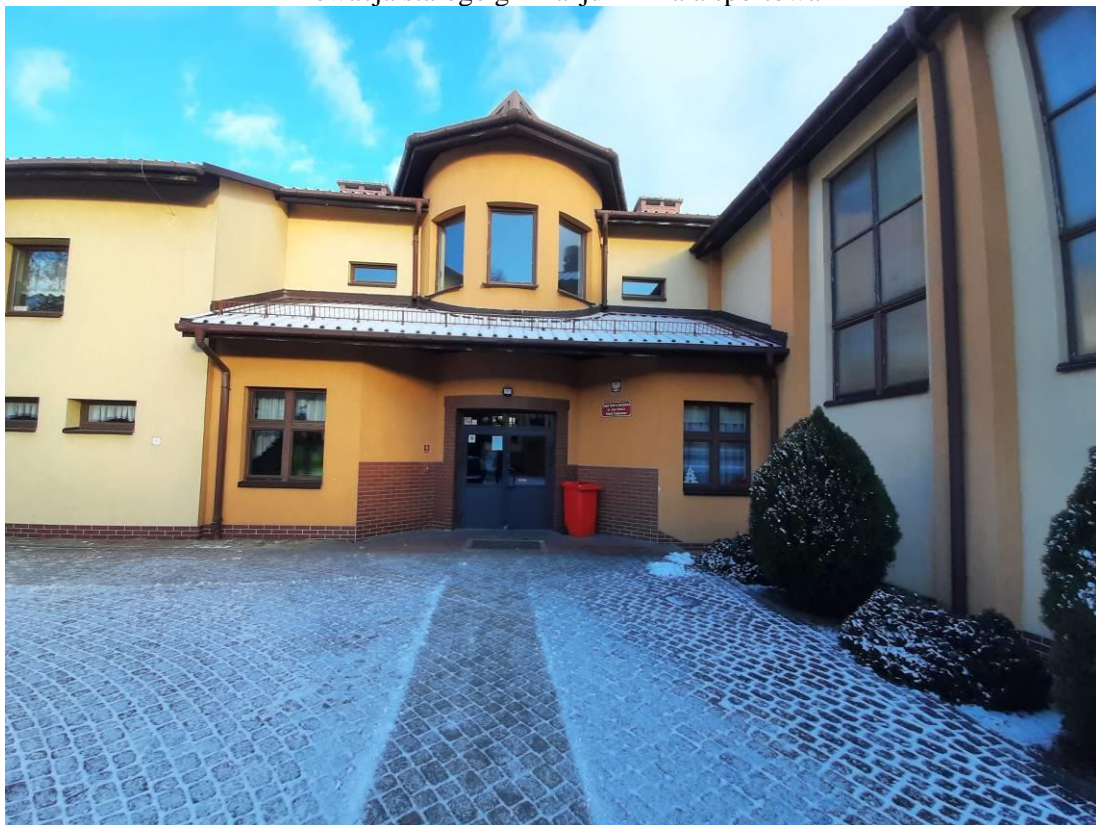
Elewacja starego gimnazjum
