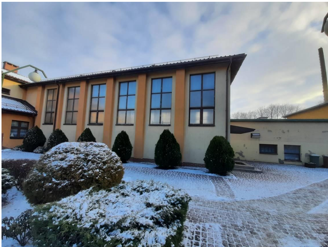
Elewacja starego gimnazjum – hala sportowa
