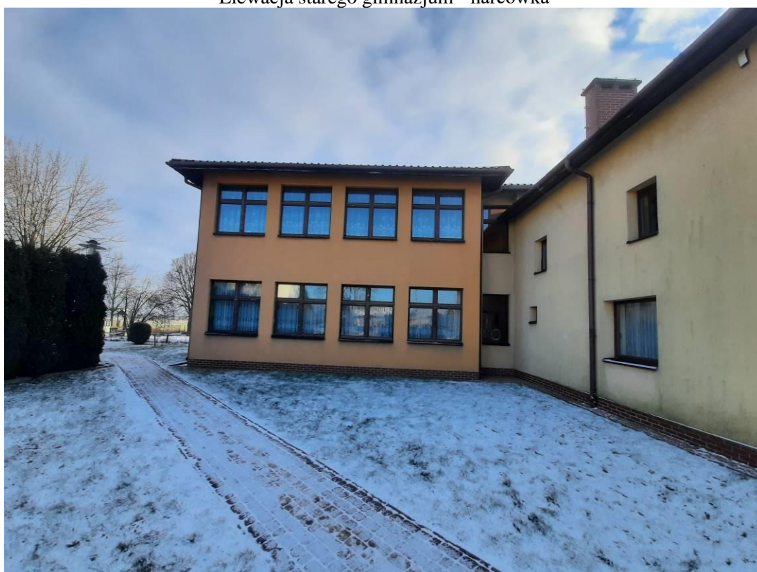
Elewacja starego gimnazjum
