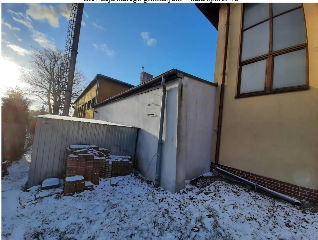
Elewacja starej szkoły – ocieplona hala za kotłownią
