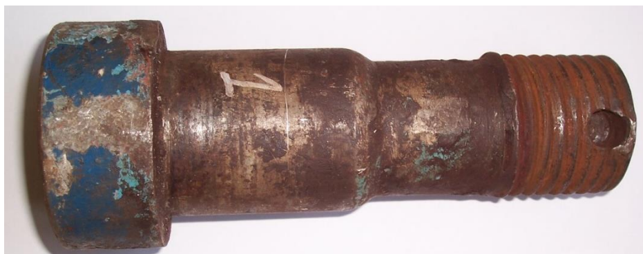
Rysunek 2. Śruba zawieszania wciągніка z zaawansowaną korozją gwintu.
