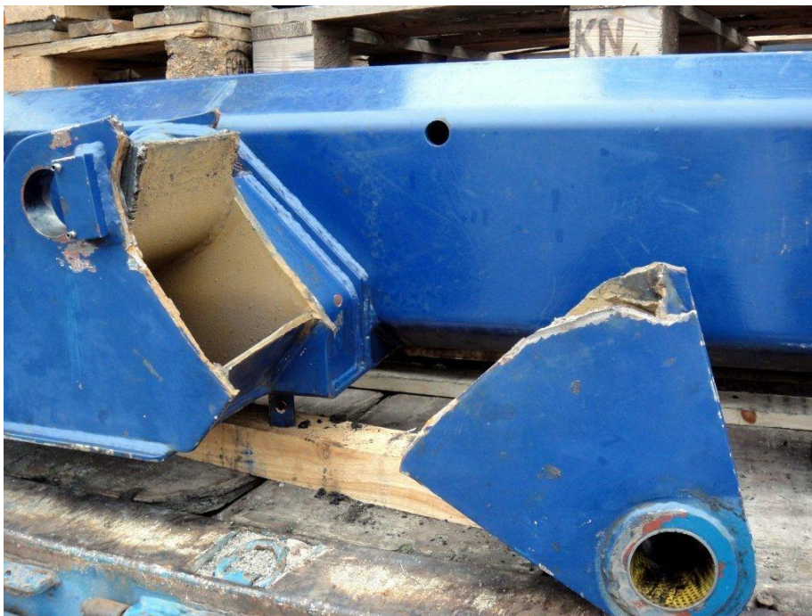
Rysunek 12. Pęknięcie zmęczeniowe czlonu podstawowego wysięgnika żurawia przenośnego o charakterze zmęczeniowym zainicjowane karbem występującym w miejscu spiętrzenia naprężeń (zmiana przekroju poprzez nakładki i liczne połączenia spawane z dużą ilością wad).
