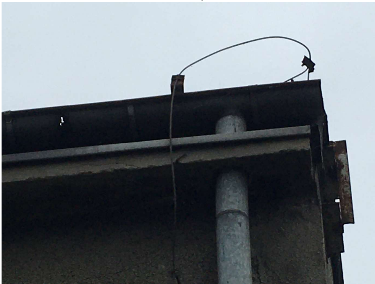
15. Nr inw. 1-0658 – BUDYNEK STACJI TRANSF., Nab. Gliwickie
