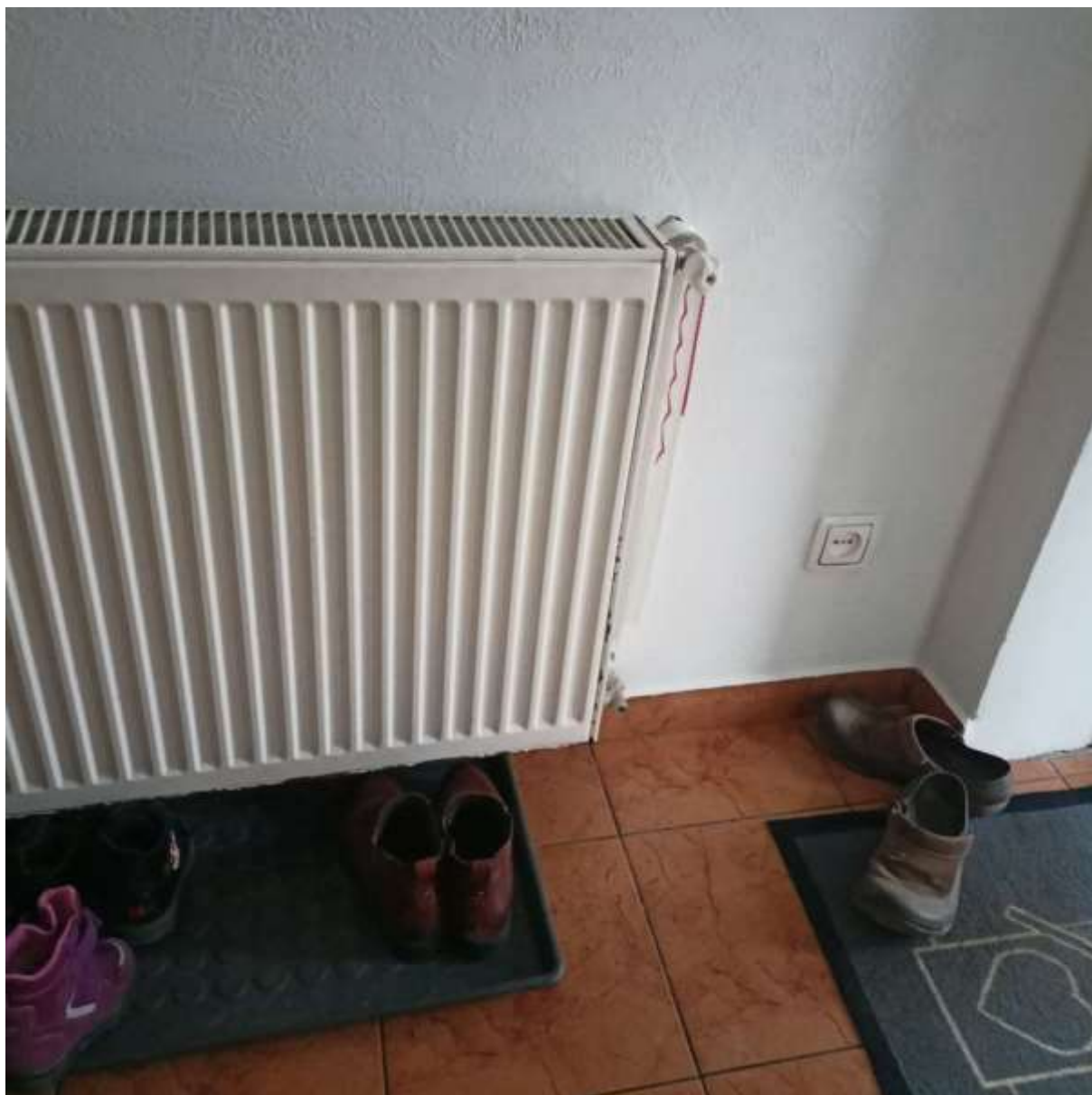
Rysunek 5 Zakres modernizacji - montaż termostatów do istniejących grzejników
