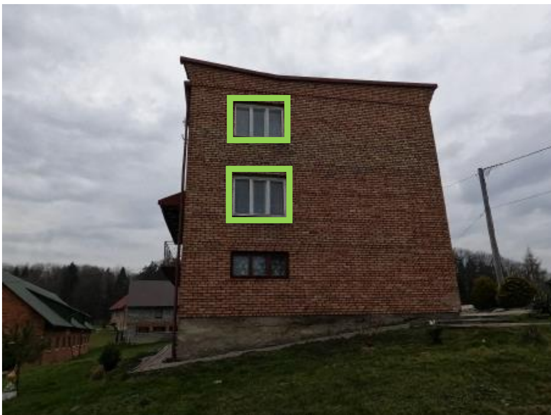
Rysunek 3 Zakres modernizacji – wymiana stolarki okiennej
