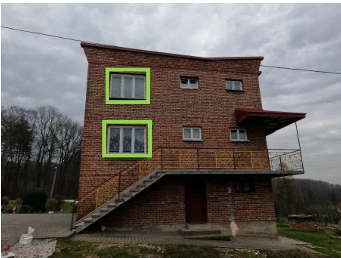
Rysunek 4 Zakres modernizacji – wymiana stolarki okiennej
