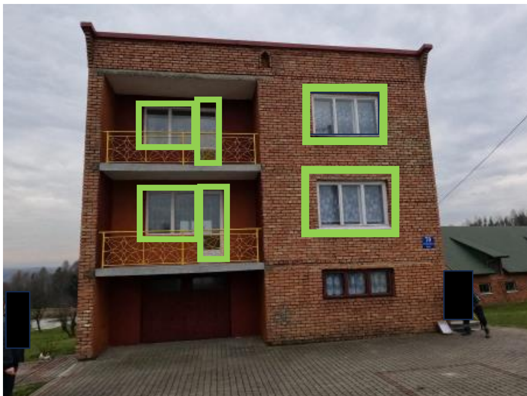
Rysunek 5 Zakres modernizacji – wymiana stolarki okiennej
