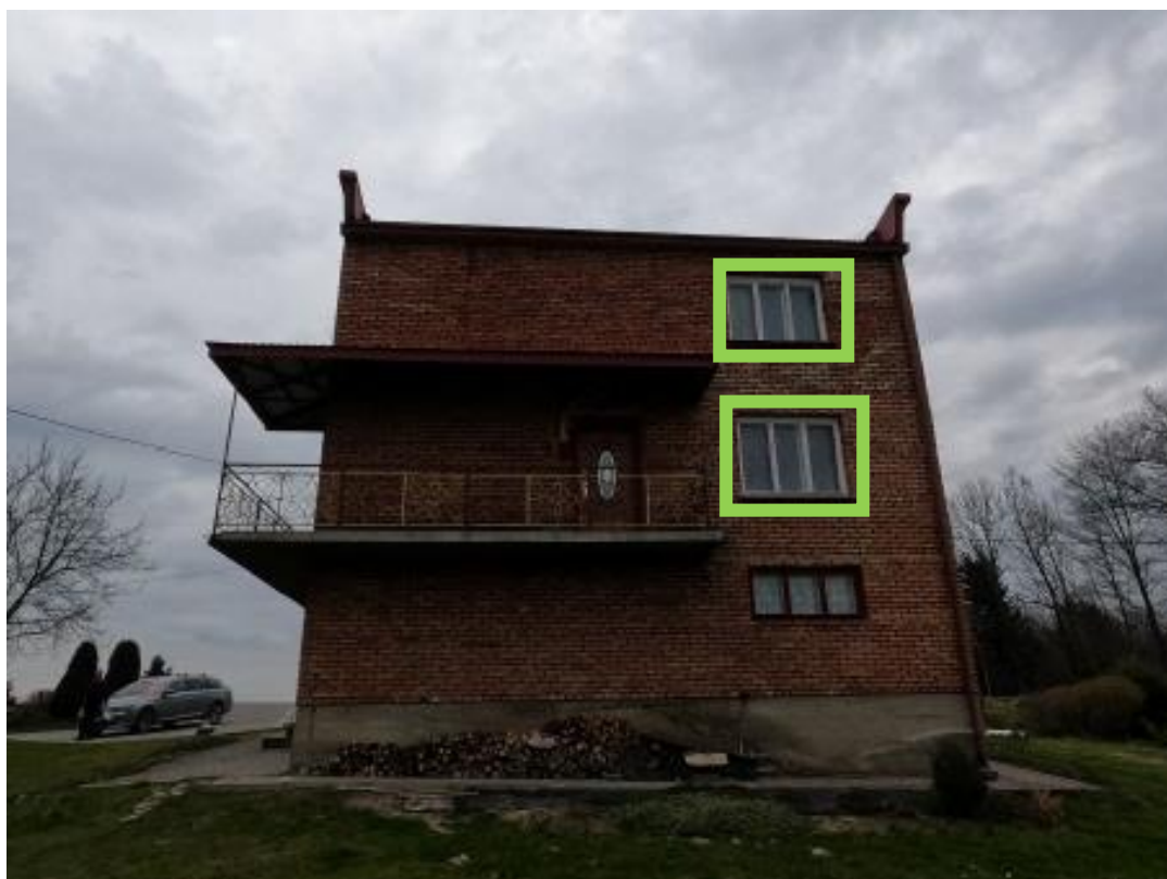
Rysunek 6 Zakres modernizacji – wymiana stolarki okiennej
