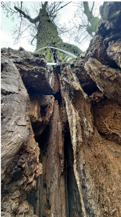
fot. 8 Wnętrze ubytku widziane przez miejscu starego obrywu
