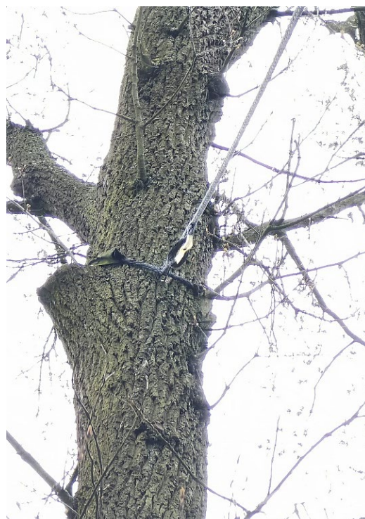
fot. 28 Wiązania w koronie
