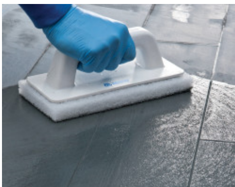
Czyszczenie spoin za pomocą pacy typu Scotch-Brite® (spoina częściowo utwardzona)
