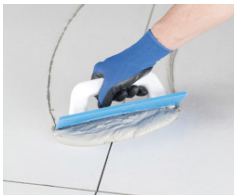
Spoinowanie płytek przy pomocy pacy gumowej
