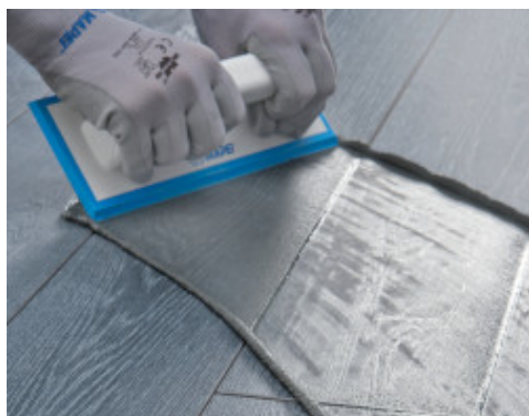
Aplikacja Ultracolor Plus za pomocą pacy gumowej na drewnopodobnej okładzinie z gresu porcelanowego
