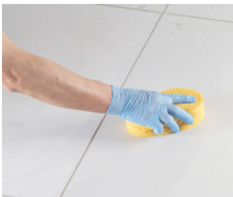
Czyszczenie i profilowanie fug przy użyciu gąbki celulozowej
