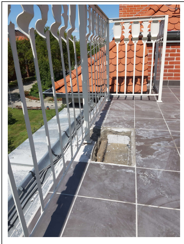
Odkrywka tarasu – piętro III
