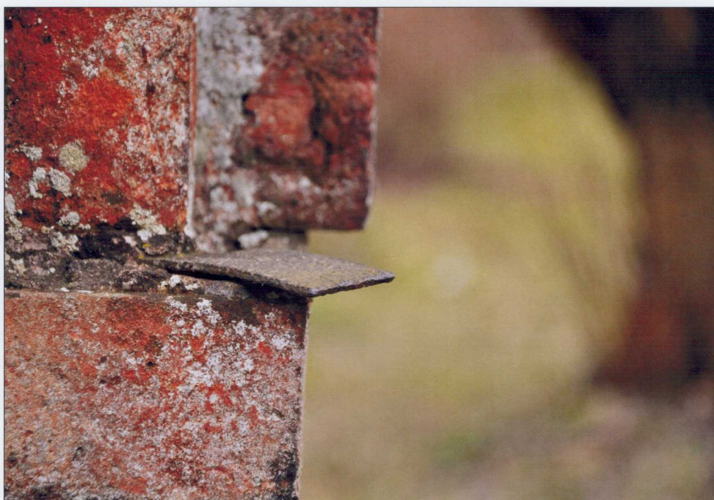
Fot.13. Cokół, wysolenia.
