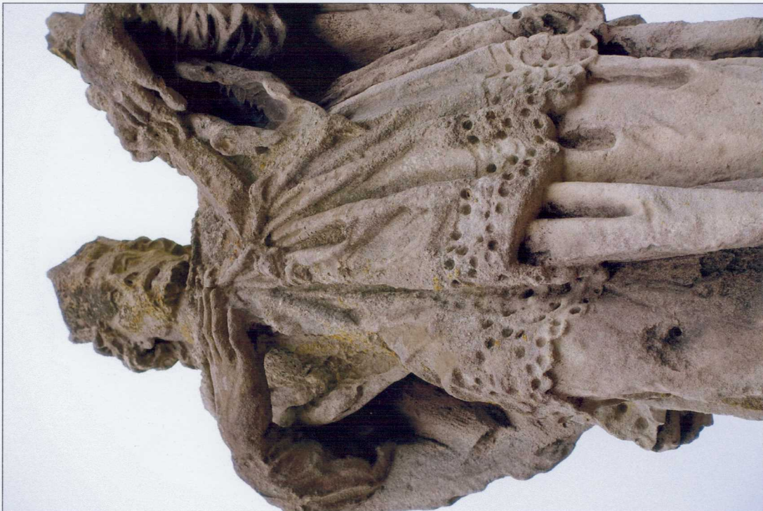
Fot.6. Figura św. Jana Nepomucena, widoczne czarne nawarstwienia i zielone ślady świadczące o obecności mikroorganizmów.
