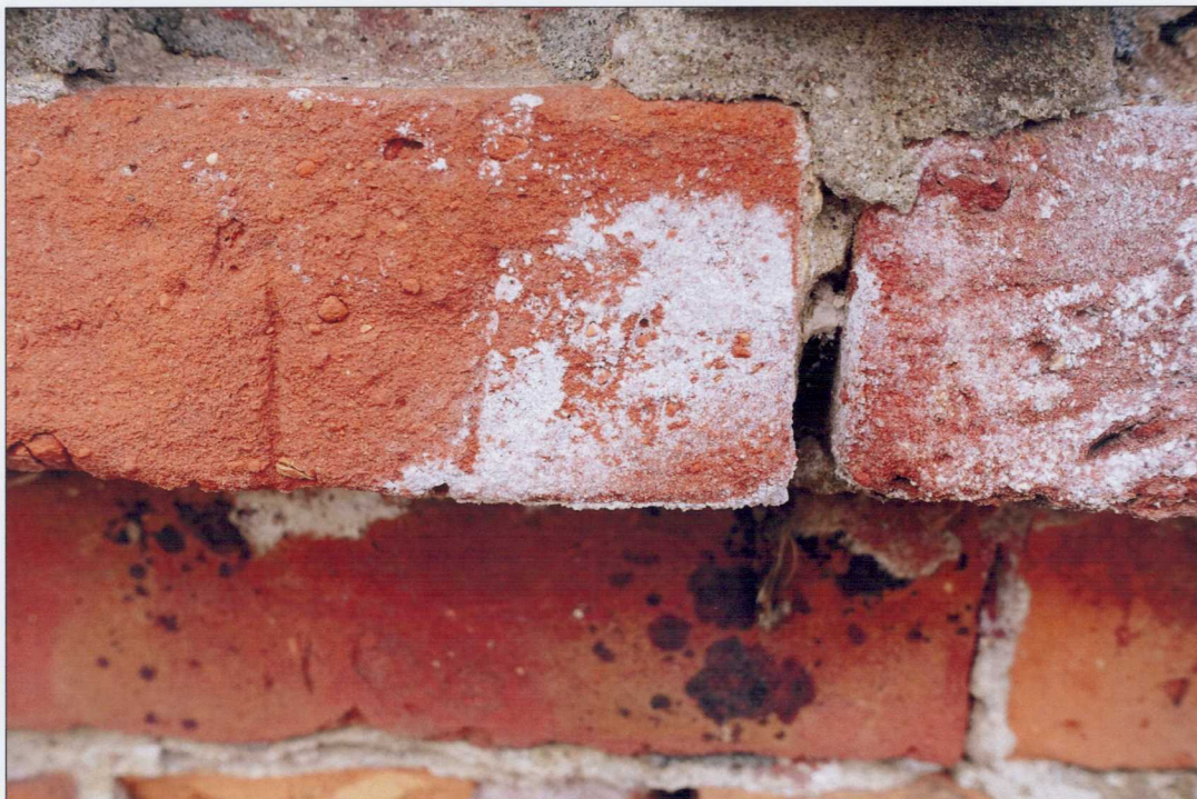
Fot.13. Cokół, wysolenia.
