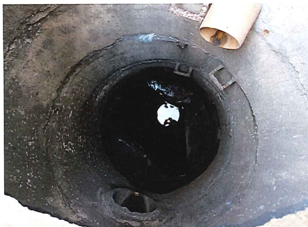
Studnia do zabudowy zasuw nożowej
