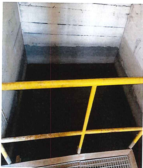
Zbiorniki ścieków oczyszczonych zlokalizowane przy oczyszczalni (miejsce zabudowy pomp ścieków)
