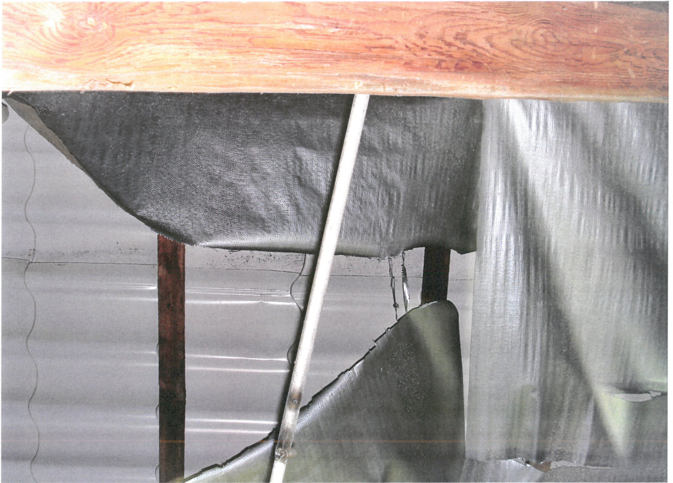
Widok uszkodzeń membrany dachowej na strychu w cz. mieszk. budyńku
