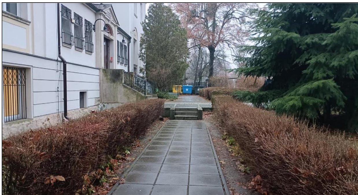
Zdjęcie nr 1 – Budynek przy ul. Witelona 25a. Budowa nachylonego chodnika w miejscu 3 istniejących stopni.
