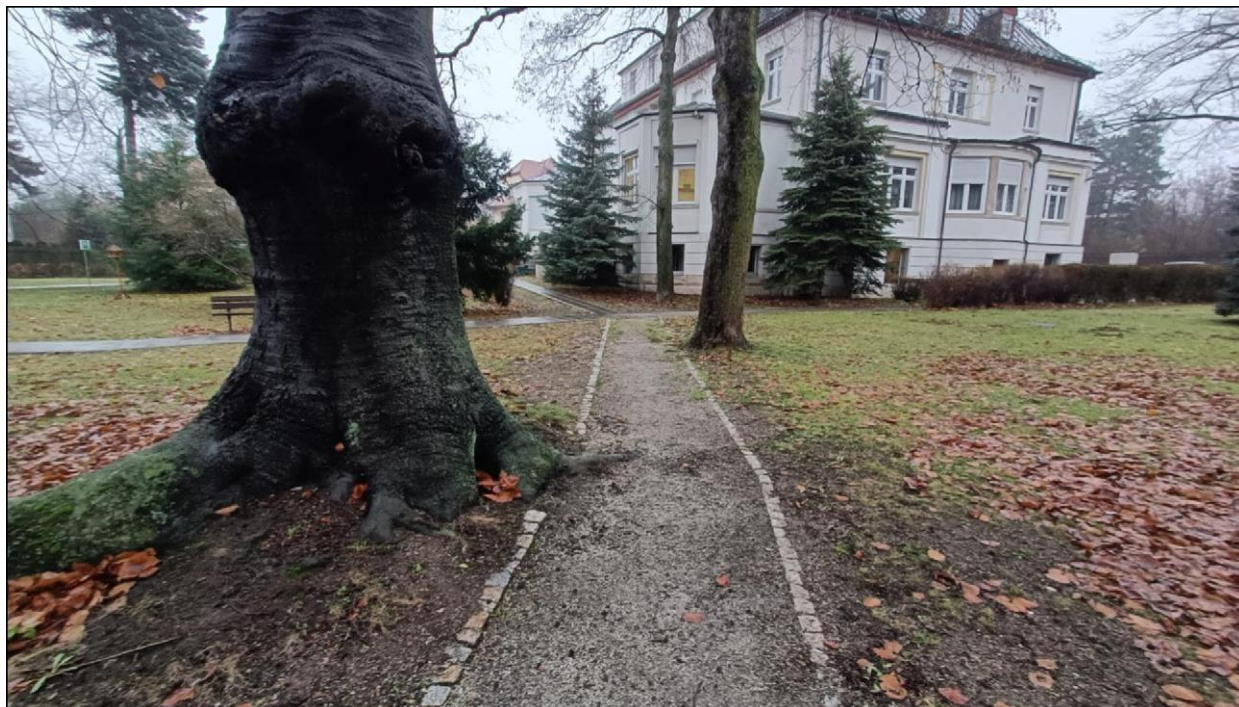
Zdjęcie nr 4 – Budynek przy ul. Witelona 25a. Przebudowanie istniejącego chodnika z nawierzchni gruntowej.
