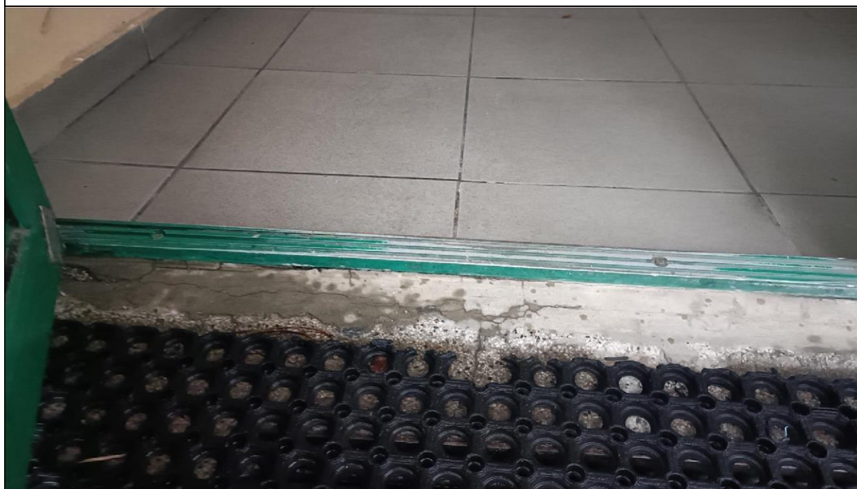
Zdjęcie nr 3 – Budynek przy ul. Witelona 25a. Wejście od strony stadionu.
