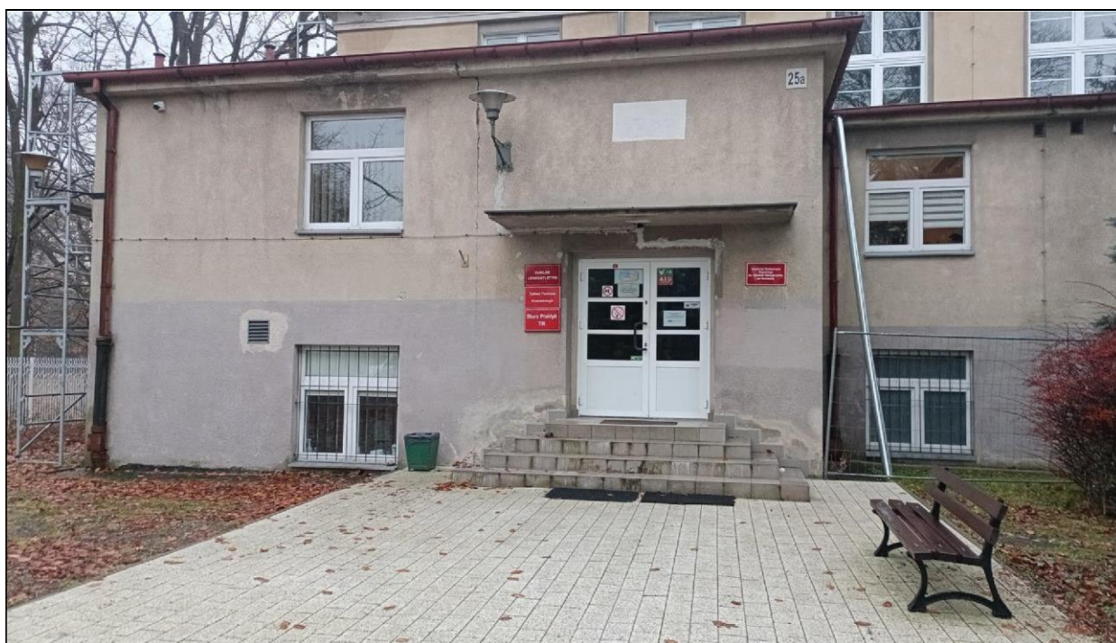
Zdjęcie nr 1 – Budynek przy ul. Witelona 25a. Istniejące wejście do budynku w lewej części obiektu.
