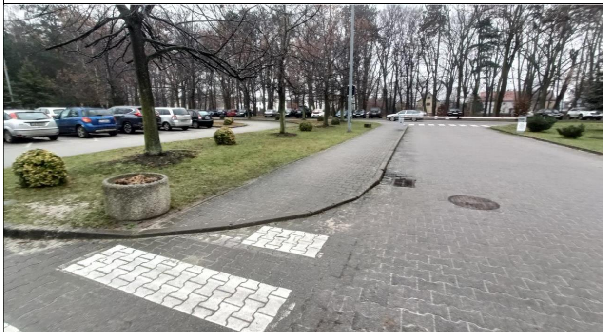
Zdjęcie nr 3 – Istniejące dojście do budynku P-3. Krawężnik do obniżenia / zlicowania z jezdnią.
