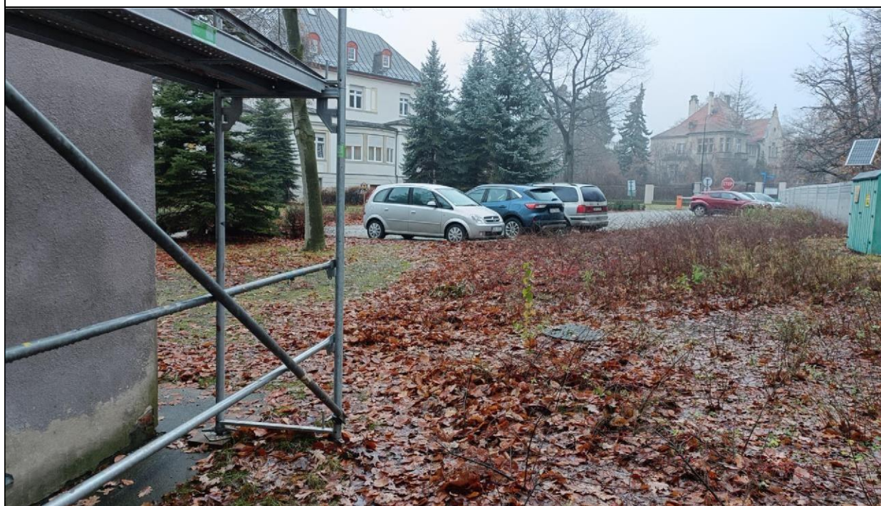
Zdjęcie nr 9 – Budynek przy ul. Witelona 25a. Wybudowanie chodnika łączącego nowe wejście do budynku z wejściem na stadion.
