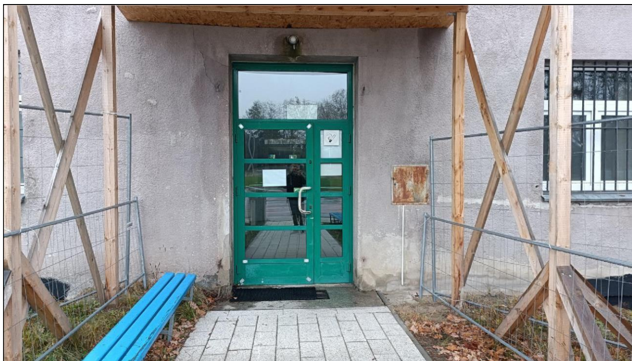
Zdjęcie nr 1 – Budynek przy ul. Witelona 25a. Wejście od strony stadionu.
