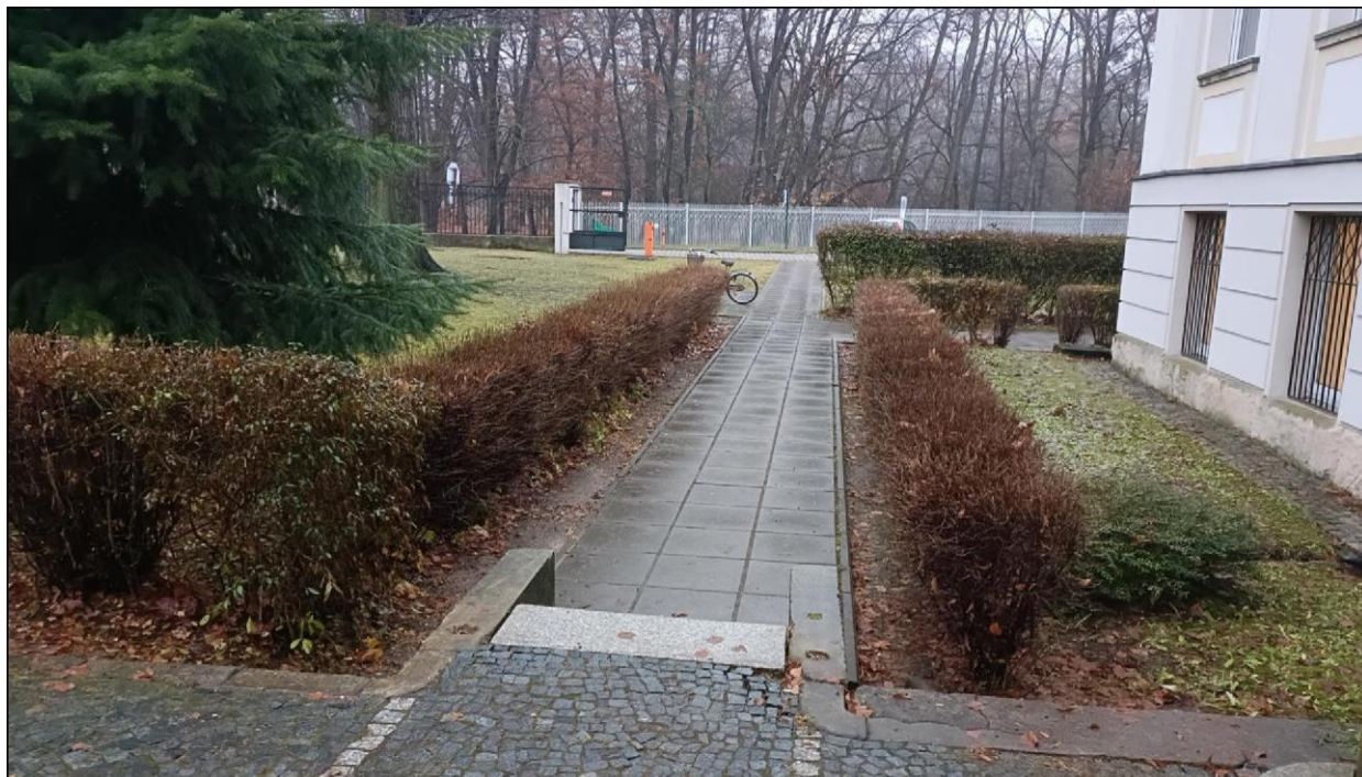
Zdjęcie nr 2 – Budynek przy ul. Witelona 25a. Budowa nachylonego chodnika w miejscu 3 istniejących stopni.
