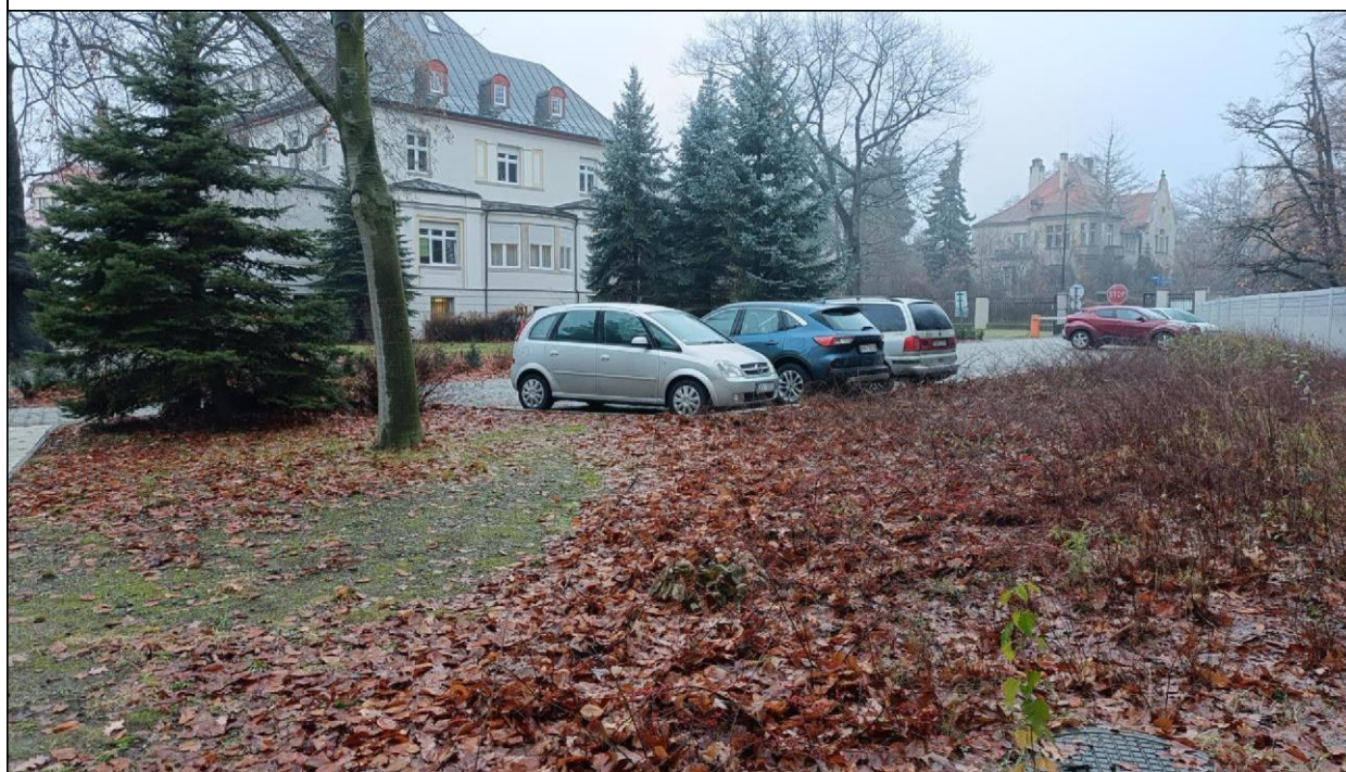
Zdjęcie nr 11 – Budynek przy ul. Witelona 25a. Wybudowanie chodnika z parkingów do wejścia do obiektu.
