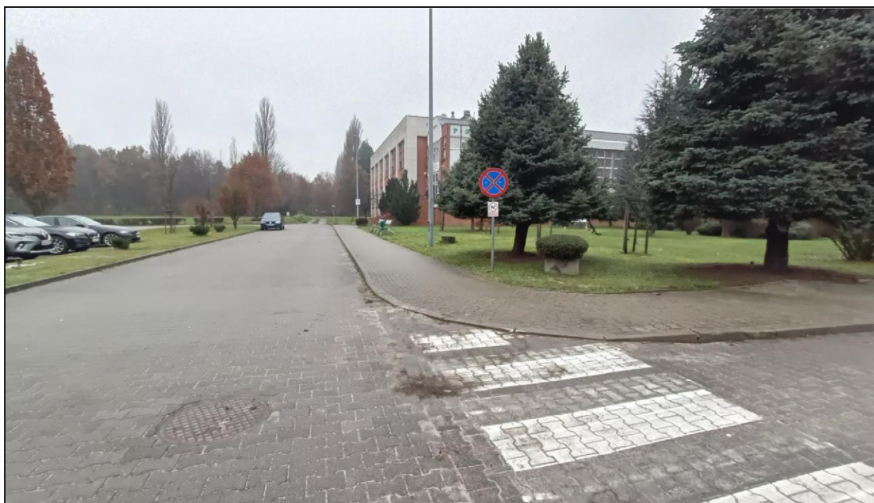
Zdjęcie nr 4 – Istniejące dojście do budynku P-3. Krawężnik do obniżenia / zlicowania z jezdnią.
