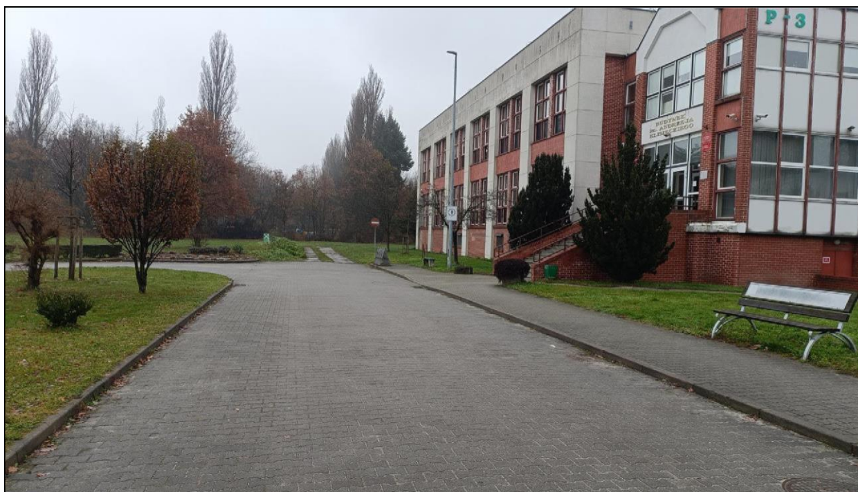
Zdjęcie nr 1 – Budynek P-3. Widok ogólny budynku P-3 z ukazaniem wejścia istniejącego do budynku.
