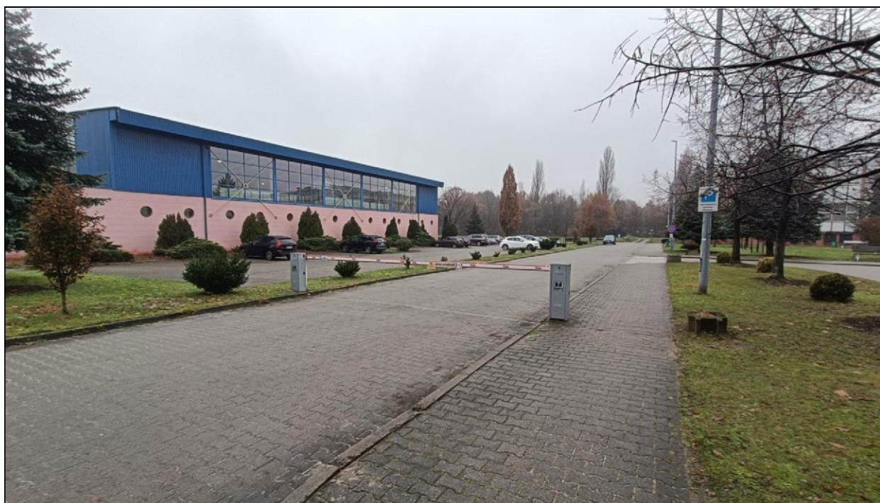
Zdjęcie nr 2 – Budynek P-3. Szlaban na wjeździe do usunięcia.
