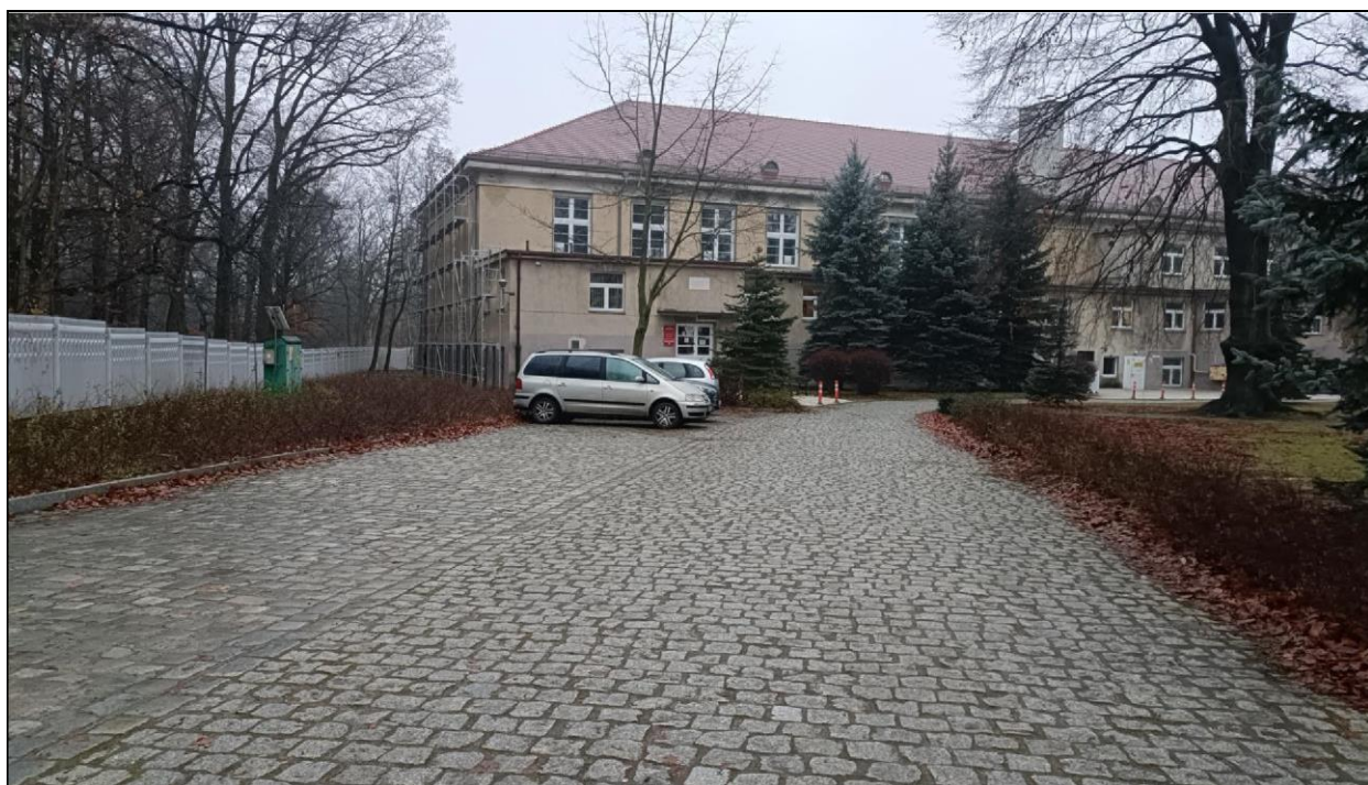
Zdjęcie nr 1 – Budynek przy ul. Witelona 25a. Lokalizacja miejsc parkingowych dla osób z niepełnosprawnościami.
