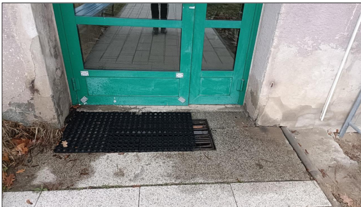
Zdjęcie nr 2 – Budynek przy ul. Witelona 25a. Wejście od strony stadionu.
