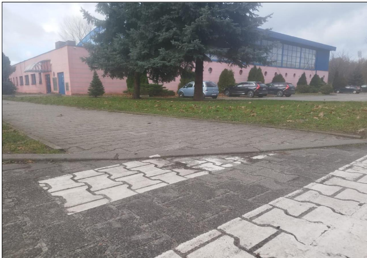
Zdjęcie nr 1 – Istniejące dojście do budynku P-3. Krawężnik do obniżenia / zlicowania z jezdnią.
