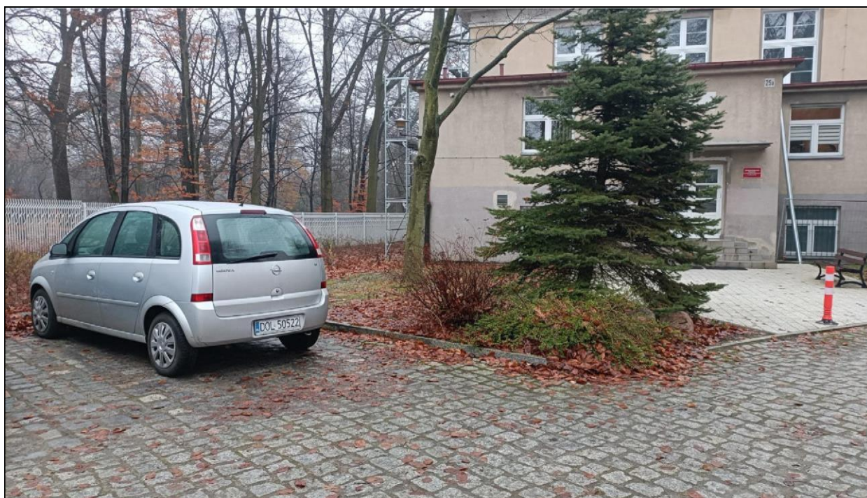
Zdjęcie nr 10 – Budynek przy ul. Witelona 25a. Wybudowanie chodnika z parkingów do wejścia do obiektu.
