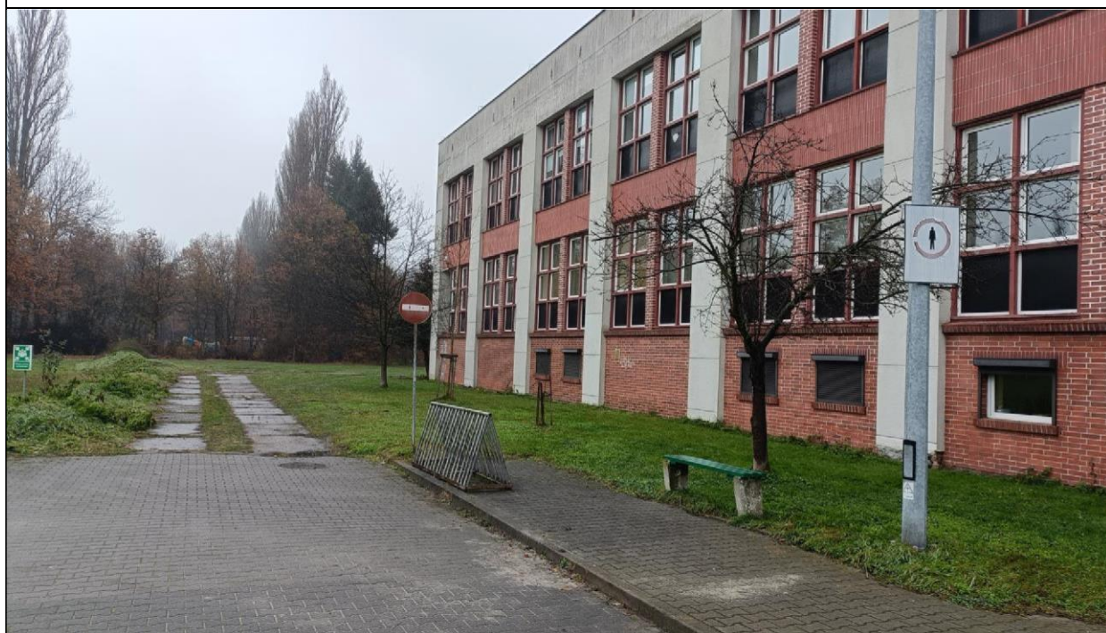
Zdjęcie nr 2 – Budynek P-3. Propozycja terenu zielonego do zagospodarowania na parking po prawej stronie jezdni na początku drogi pożarowej, za wejściem istniejącym do budynku.
