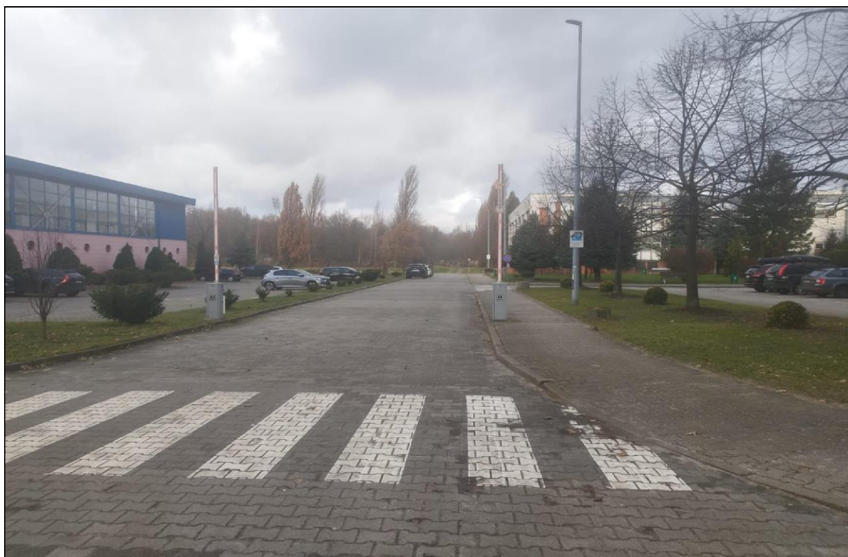
Zdjęcie nr 2 – Istniejące dojście do budynku P-3. Krawężnik do wyrównania z jezdnią.
