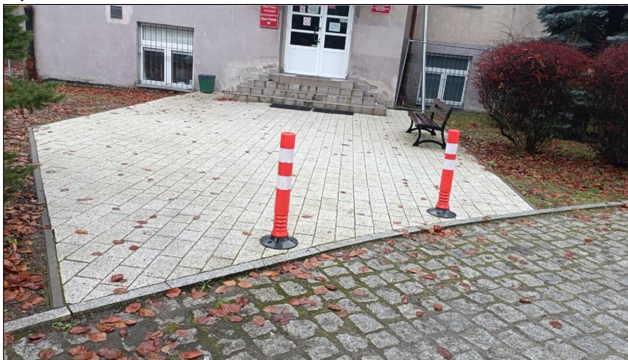
Zdjęcie nr 1 – Budynek przy ul. Witelona 25a. Zbyt wysoki krawężnik na dojściu.
