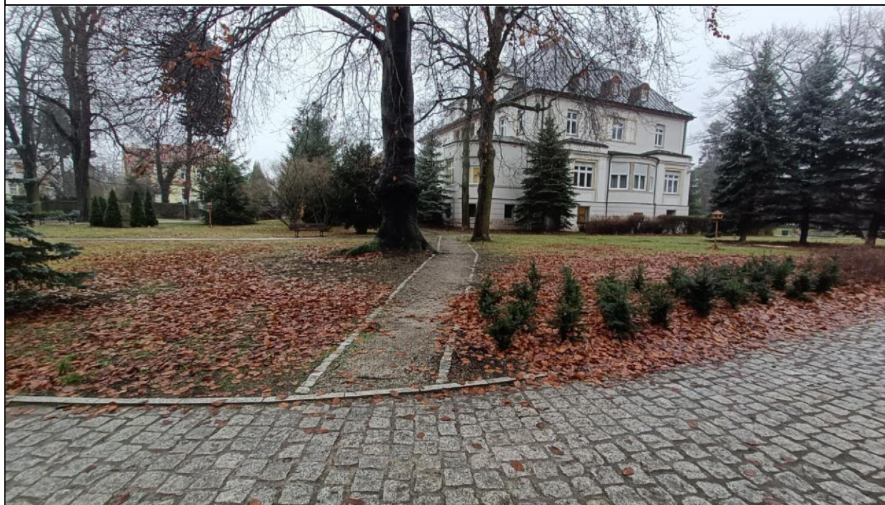
Zdjęcie nr 3 – Budynek przy ul. Witelona 25a. Przebudowanie istniejącego chodnika z nawierzchni gruntowej.
