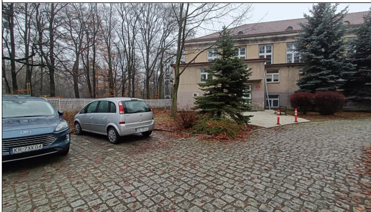
Zdjęcie nr 2 – Budynek przy ul. Witelona 25a. Lokalizacja miejsc parkingowych dla osób z niepełnosprawnościami.
