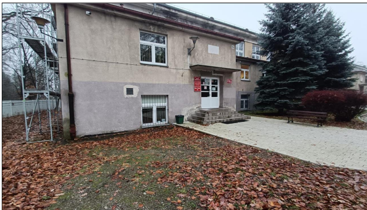
Zdjęcie nr 2 – Budynek przy ul. Witelona 25a. Istniejące wejście do budynku w lewej części obiektu.
