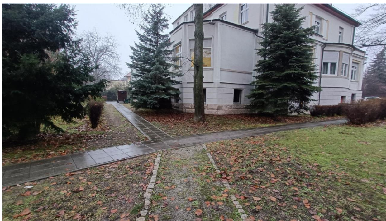
Zdjęcie nr 5 – Budynek przy ul. Witelona 25a. Przebudowanie istniejącego chodnika z nawierzchni gruntowej.
