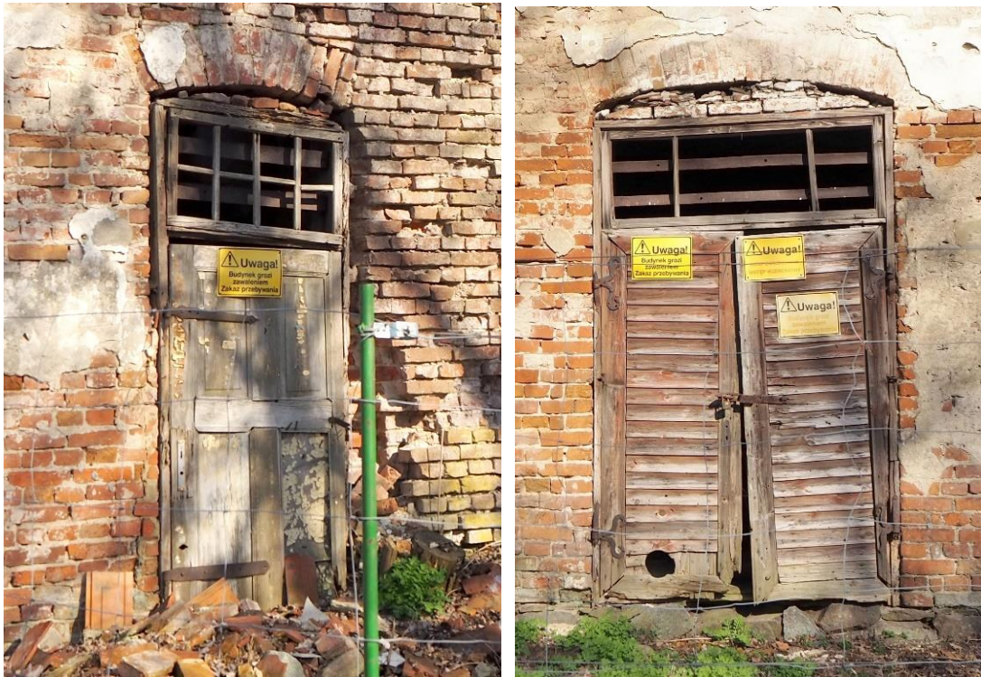
Fot. 28-29. Zachowały się oryginalne drzwi w elewacji zachodniej jednak są w bardzo złej kondycji. Drewno jest spróchniałe i zbutwiałe. Oryginalne zawiasy pokryte są produktami korozji.
