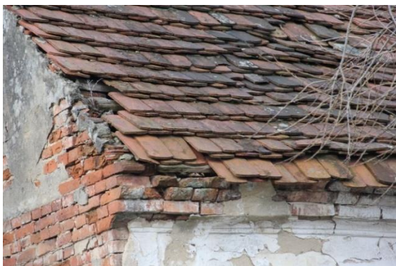
Fot. 4-5. Spichrz był pokryty dachem ceramiczny z dachówki „karpiówki” zakładamy na koronkę. Na szczycie umieszczone były gąsiory.
