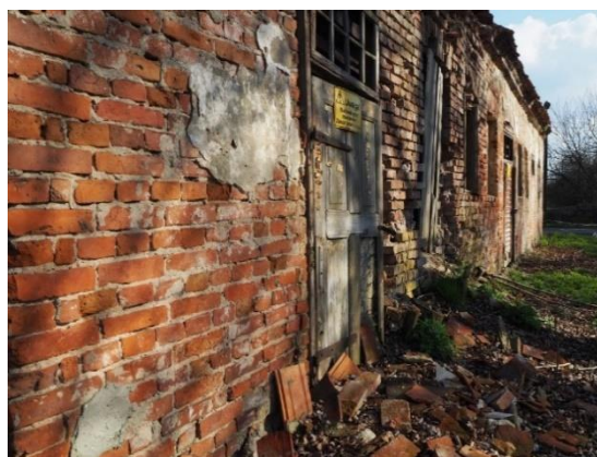
Fot. 24-25. Część północna elewacji zachodniej w najgorszym stanie poprzez zawalony dach. Elewacja z licznymi ubytkami w cegle i spoinie. Pod murami elewacji widoczna dachówka, która spadła podczas zawalenia się dachu.
