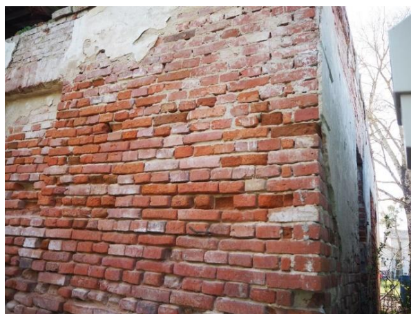
Fot. 2-3. Od wschodniej strony mury spichrza są w bardzo złym stanie. W części, gdzie dach się zawalił cegły sypią się i pudrują, pozbawione są oryginalnego spieku. Widoczne pozostałości po dawnym tynku i boniach. W większości tynk odpadł od powierzchni lica ściany.
