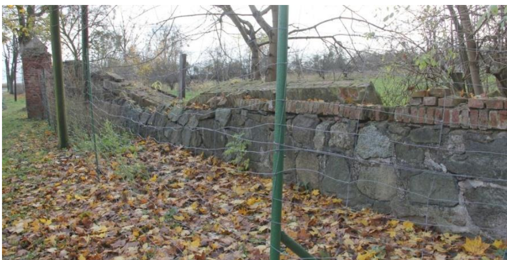
Fot. 51. Zachowana oryginalna część muru ceglanoego wraz ze słupkiem bramy. Uzupełnienia spoiną cementową są wtórne jak i założone na zaprawę cementową dachówki.
