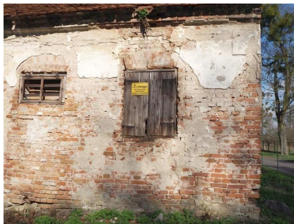
Fot. 26-27. Większość otworów okiennych nieszkliwionych z drewniana kratą w ościeżnicy jest bez okiennic. Jedyne okiennice zachowały się w części zachodnio południowej.
