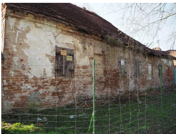
Fot. 2-3. Od wschodniej strony mury spichrza są w bardzo złym stanie. W części, gdzie dach się zawalił cegły sypią się i pudrują, pozbawione są oryginalnego spieku. Widoczne pozostałości po dawnym tynku i boniach. W większości tynk odpadł od powierzchni lica ściany.
