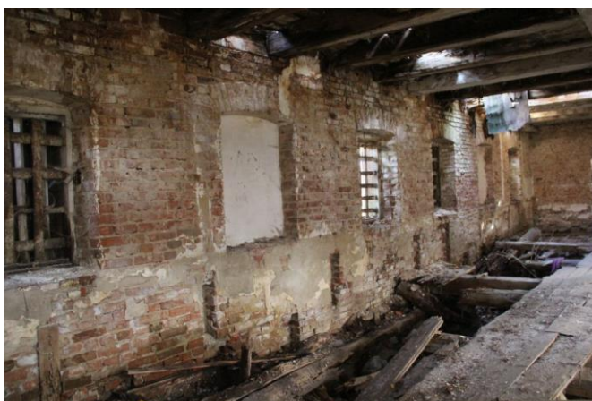
Fot. 30. Stan zachowania wnętrza spichrza w 2021 r.
