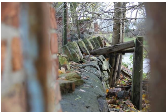
Fot. 54-58. Zaprawa cementowa niekorzystnie wpłynęła na stan zachownia muru. W tylnej części muru została wykonana wylewka cementowa, co widać na zdjęciu. Tylna część muru została otynkowana cementem. Na szczyt muru i słupka została zamocowana dachówka na zaprawę cementową. Pierwotnie szczyty murów i słupki były zakończone cegłą wmurowaną na skos.
