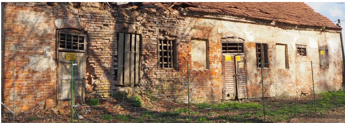
Fot. 23. Widoczne otwory okienne z okiennicami oraz dwa otwory drzwiowe, jak również blendy.
