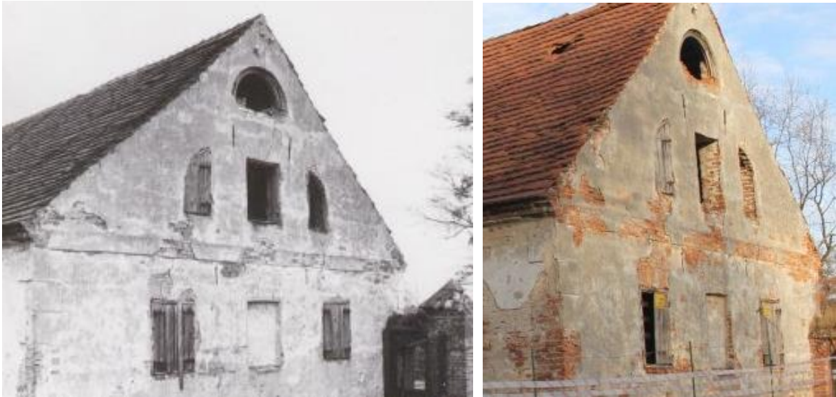
Fot. 24. Widoczne na starej fotografii oryginalne okienice na zawiasach. Po prawej stan w 2021 r.
