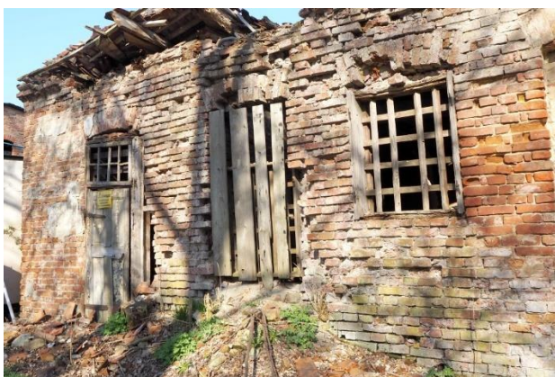
Fot. 24-25. Część północna elewacji zachodniej w najgorszym stanie poprzez zawalony dach. Elewacja z licznymi ubytkami w cegle i spoinie. Pod murami elewacji widoczna dachówka, która spadła podczas zawalenia się dachu.
