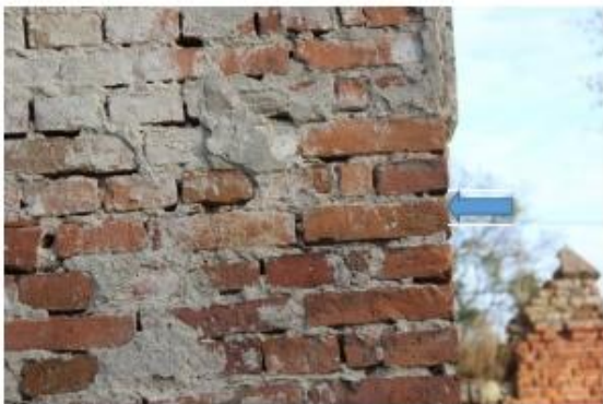
Próbka nr. 5. Zaprawa pobrana ze spoiny
