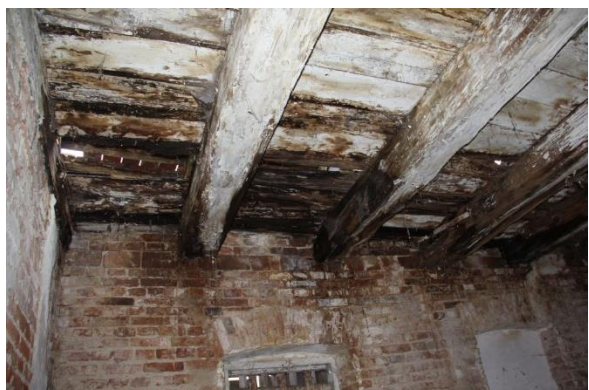
Fot. 31-35. Stan zachowania stropu spichrza w 2021 r.
