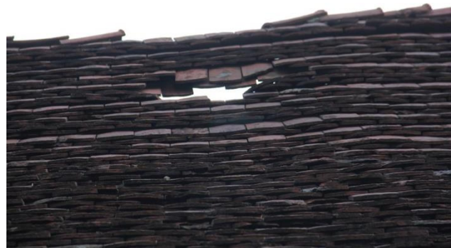
Fot. 19-20. Konstrukcja więźby dachowej uległa destrukcji. Widoczne są liczne ubytki w dachówce „karpówce”. Więźba nie spełnia swojej funkcji. Dach grozi kolejnym zawaleniem.
