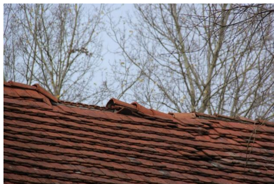
Fot. 4-5. Spichrz był pokryty dachem ceramiczny z dachówki „karpiówki” zakładamy na koronkę. Na szczycie umieszczone były gąsiory.
