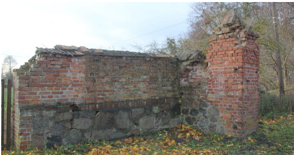
Fot. 51. Zachowana oryginalna część muru ceglanoego wraz ze słupkiem bramy. Uzupełnienia spoiną cementową są wtórne jak i założone na zaprawę cementową dachówki.
