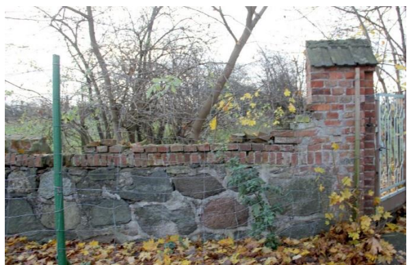
Fot. 54-58. Zaprawa cementowa niekorzystnie wpłynęła na stan zachownia muru. W tylnej części muru została wykonana wylewka cementowa, co widać na zdjęciu. Tylna część muru została otynkowana cementem. Na szczyt muru i słupka została zamocowana dachówka na zaprawę cementową. Pierwotnie szczyty murów i słupki były zakończone cegłą wmurowaną na skos.
