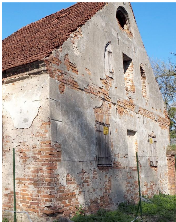
Fot. 60-61. Elewacja południowa: 3-osiowa. Pomędzy kondygnacjami pas z tynku. Blenda pomiędzy otworami okiennymi. W narożnikach murów widoczne boniowania.
