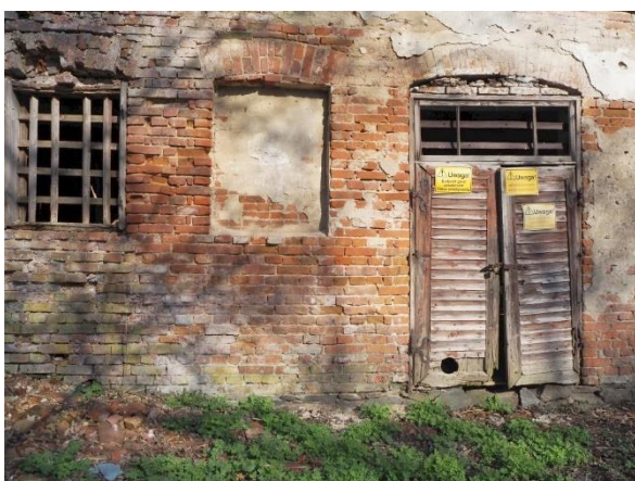
Fot. 26-27. Większość otworów okiennych nieszkliwionych z drewniana kratą w ościeżnicy jest bez okiennic. Jedyne okiennice zachowały się w części zachodnio południowej.
