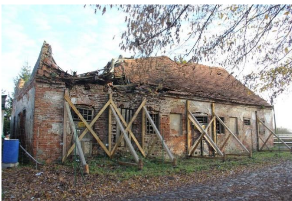
Fot. 62-63. Elewacja północna - analogiczna do elewacji południowej, 3-osiowa. Pomędzy kondygnacjami pas z tynku. Blenda pomiędzy otworami okiennymi. W narożnikach murów widoczne boniowania.
