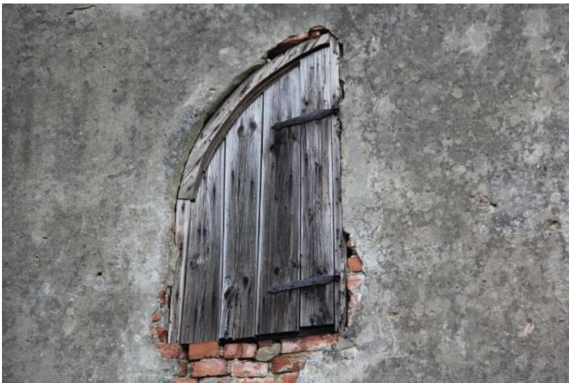
Fot. 34. Po lewej stronie elewacji zachowała się ościeżnica ze skrzydłem okienicy założona na zawiasy.
