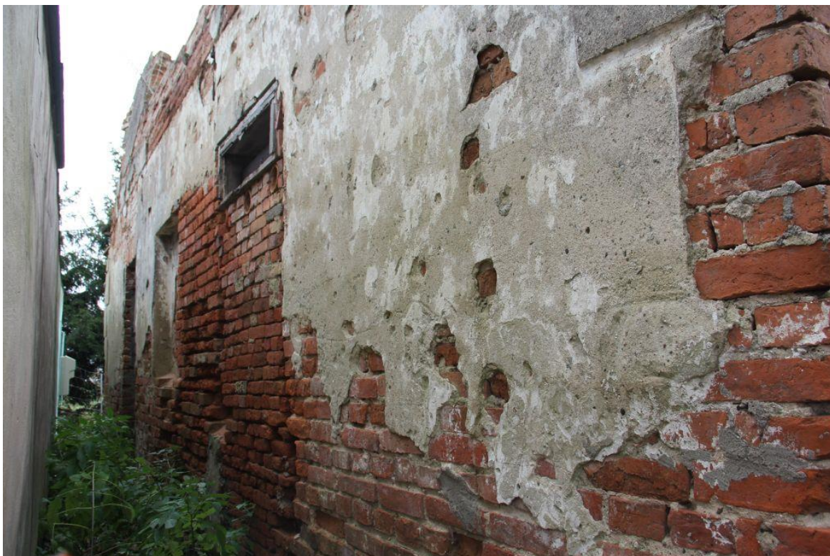
Fot. 39. Elewacja północna po lewej stronie posiada wtórny otwór drzwiowy, który prawdopodobnie pierwotnie był oknem. Na środkowej osi posiada blendę. Po prawej stronie zamurowane jest wtórnie okno. Z białej karty wynika, że elewacja północna była analogiczna do elewacji południowej.
