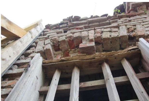
Fot. 21-22. Okna drewniane i drzwi od strony elewacji zachodniej są w bardzo złym stanie. Drewno jest spróchniałe i przegnite.
