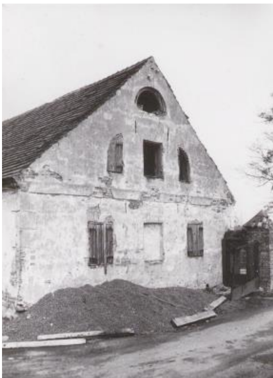
Fot. 60-61. Elewacja południowa: 3-osiowa. Pomędzy kondygnacjami pas z tynku. Blenda pomiędzy otworami okiennymi. W narożnikach murów widoczne boniowania.
