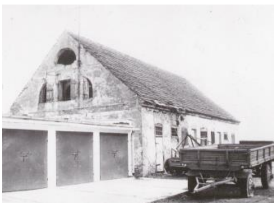
Fot. 62-63. Elewacja północna - analogiczna do elewacji południowej, 3-osiowa. Pomędzy kondygnacjami pas z tynku. Blenda pomiędzy otworami okiennymi. W narożnikach murów widoczne boniowania.
