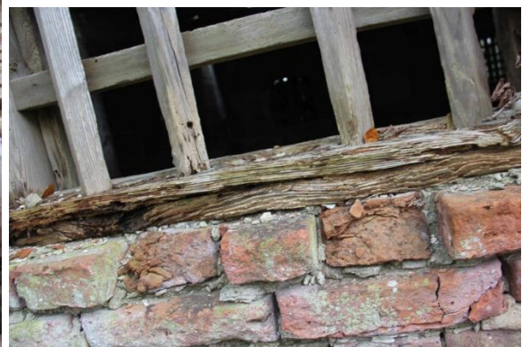
Fot. 21-22. Okna drewniane i drzwi od strony elewacji zachodniej są w bardzo złym stanie. Drewno jest spróchniałe i przegnite.
