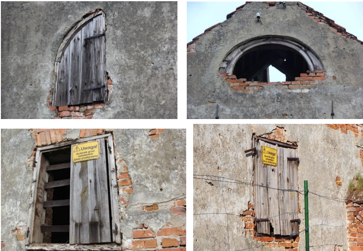
Fot. 25-29. Zachowane oryginalne ościeżnice w otworach okiennych oraz okienice na zawiasach.
