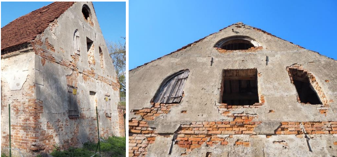
Fot. 31-32. Elewacja południowa była 3 osiowa. Na szczycie elewacji mieścił się półokrągły otwór okienny. Pod nim trzy otwory okienne.
