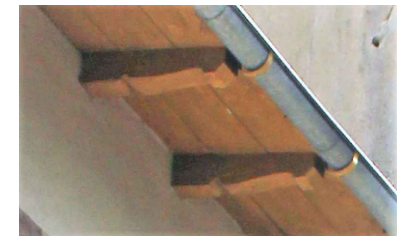
NALEŻY ZACHOWAĆ HISTORYCZNĄ GEOMETRIĘ KOŃCÓWKI DŹWIGARA NA PODSTAWIE ZACHOWANYCH KROKWI
