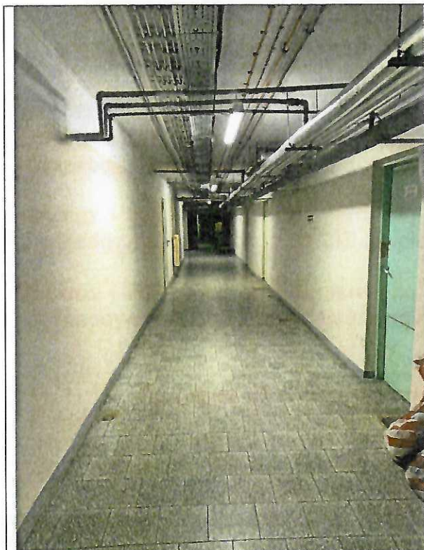
Fot. 3 – zaniżona wysokość korytarza w skrzydłach A/B
