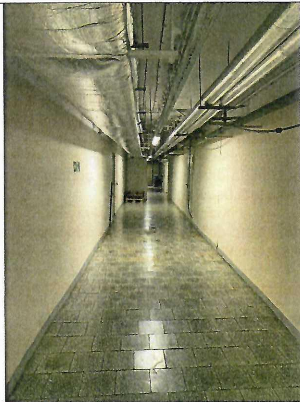
Fot. 4 – zaniżona wysokość korytarza w skrzydle C
