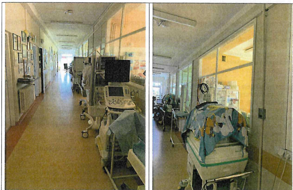
Fot. 1,2 – szklana obudowa drogi ewakuacyjnej na kondygnacji +1.
