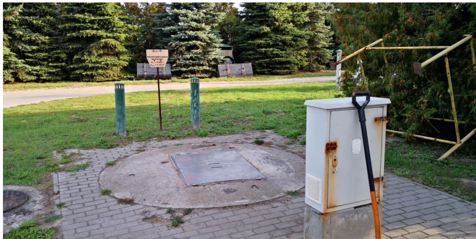
Fot. 1. Przepompownia główna.
