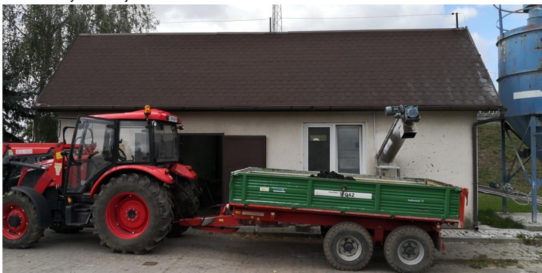
Fot. 16 Budynek stacji odwadniania osadu
