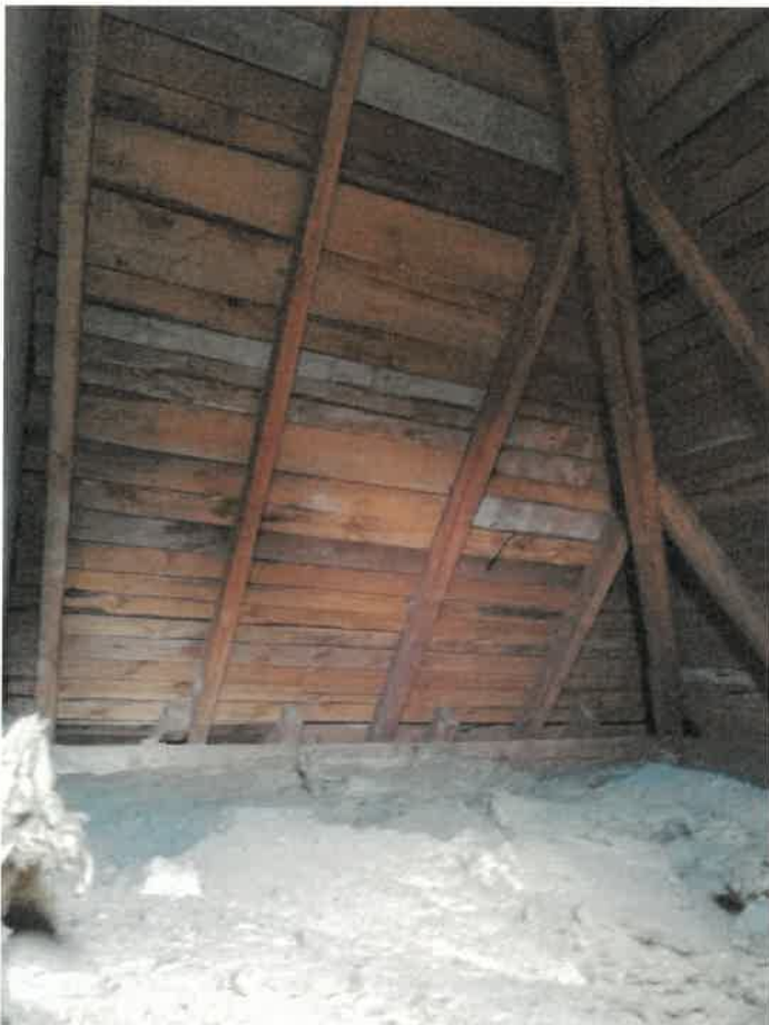
Widok konstrukcji drewnianej więźby i pokrycia izolacją stropu nieużytkowego nad poddaszem.
