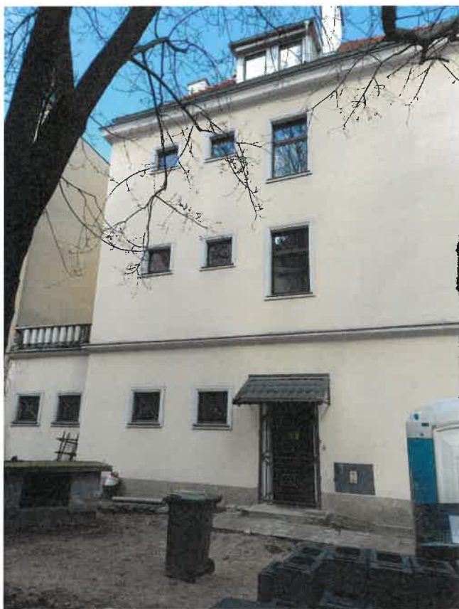
Widok elewacji od strony dziedzińca.
