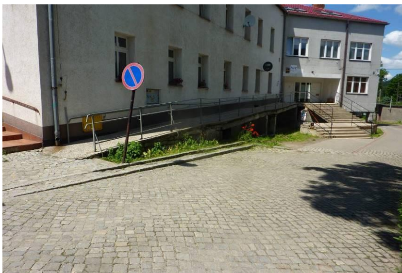
Fot. Widok ogólny pochylni i schodów od strony wjazdu na posesję. Budynek SPZOZ widoczny na drugim planie
