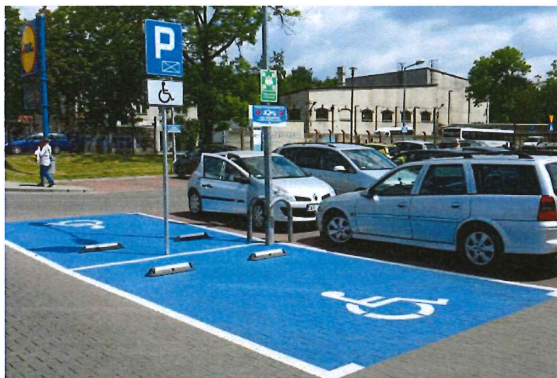
Przykład poprawnie wykonanego oznakowania stanowiska dla osób niepełnosprawnych.
